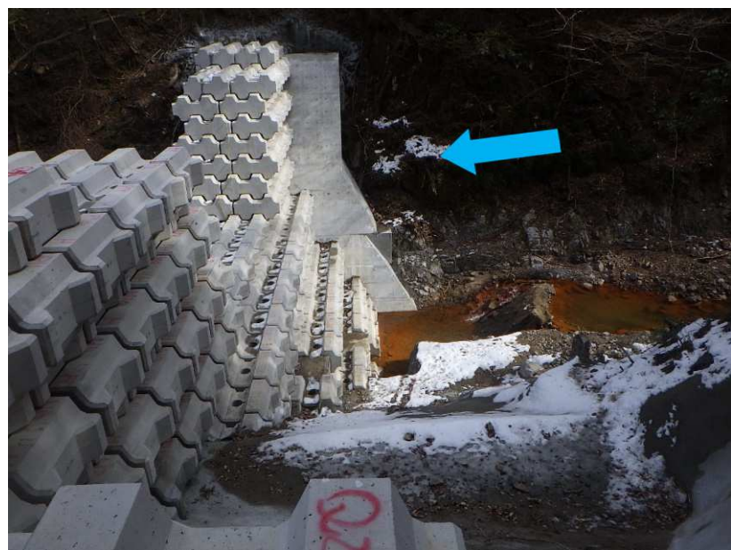
土石流発生前 (R4年2月撮影 堰堤完成時)
