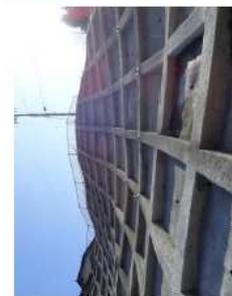
① 吹付法砕工+鉄筋挿入工
