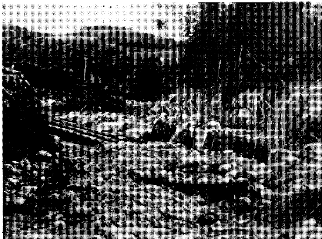
黒田橋附近被災状況
