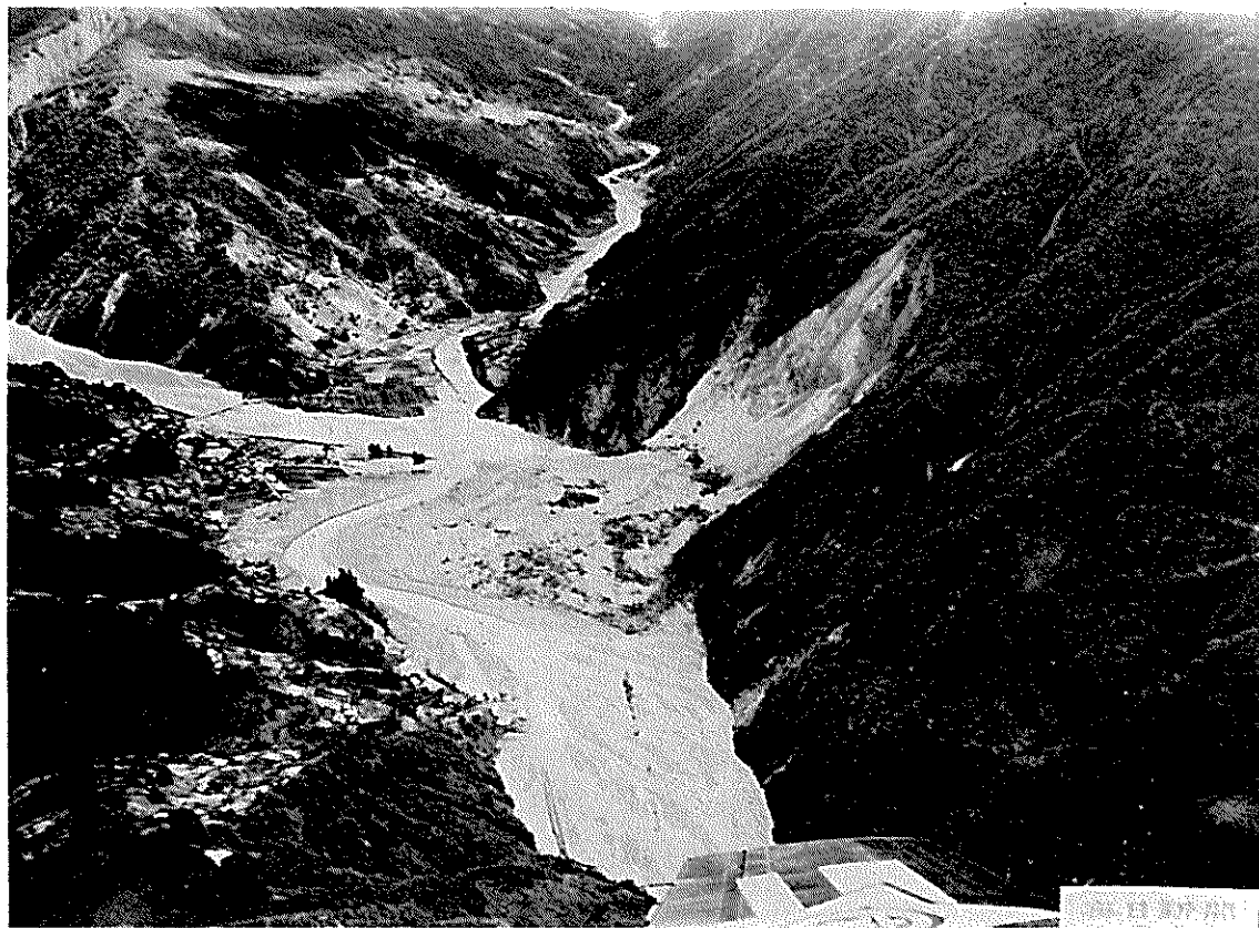
大西山崩潰状況 (崩潰土量 320万立方米)
