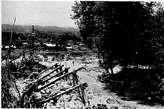
南大島川中流部被災状況写真
