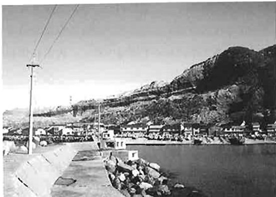
“名立崩れ”の跡…稜線から下の絶壁が崩壊跡（名立町）
