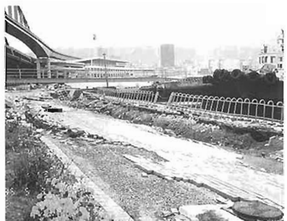
兵庫県南部地震で、地盤の液状化により被災した護岸 (川上、1995)
