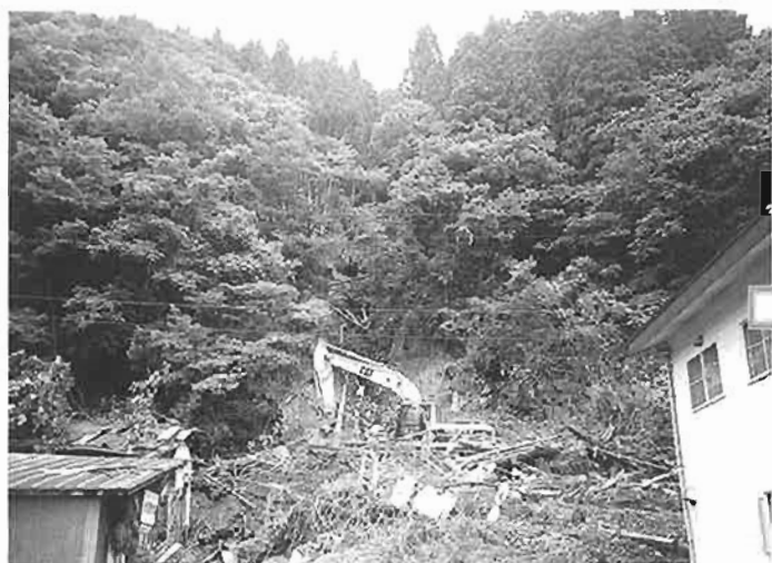
長野県小谷村光明地区
