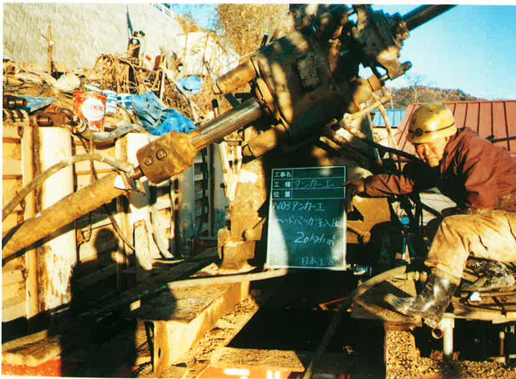
(上島) アンカー工 施工中
