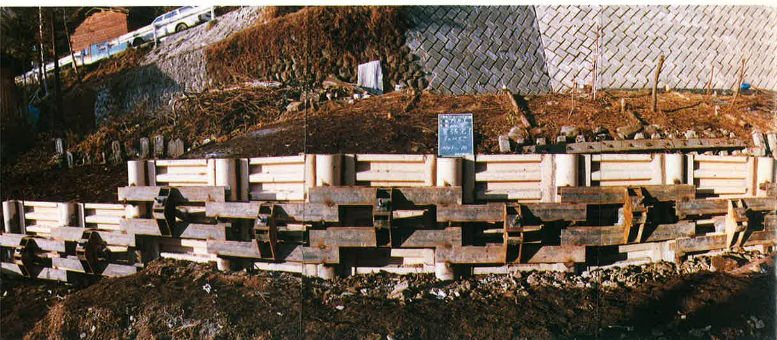
(上 島) 地すべり抑止杭一部完成
