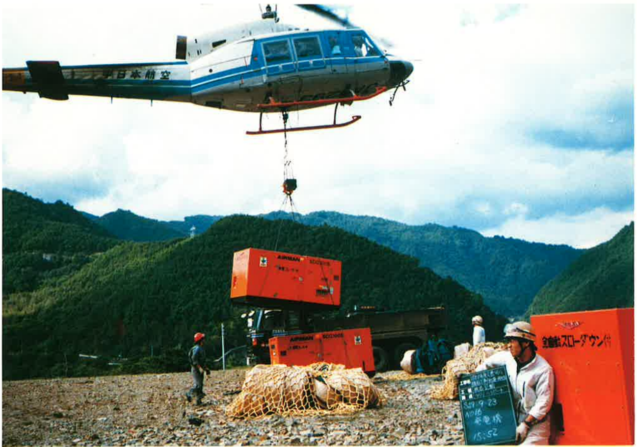
道路が不通のため、ヘリコプターにより運搬される重機類
