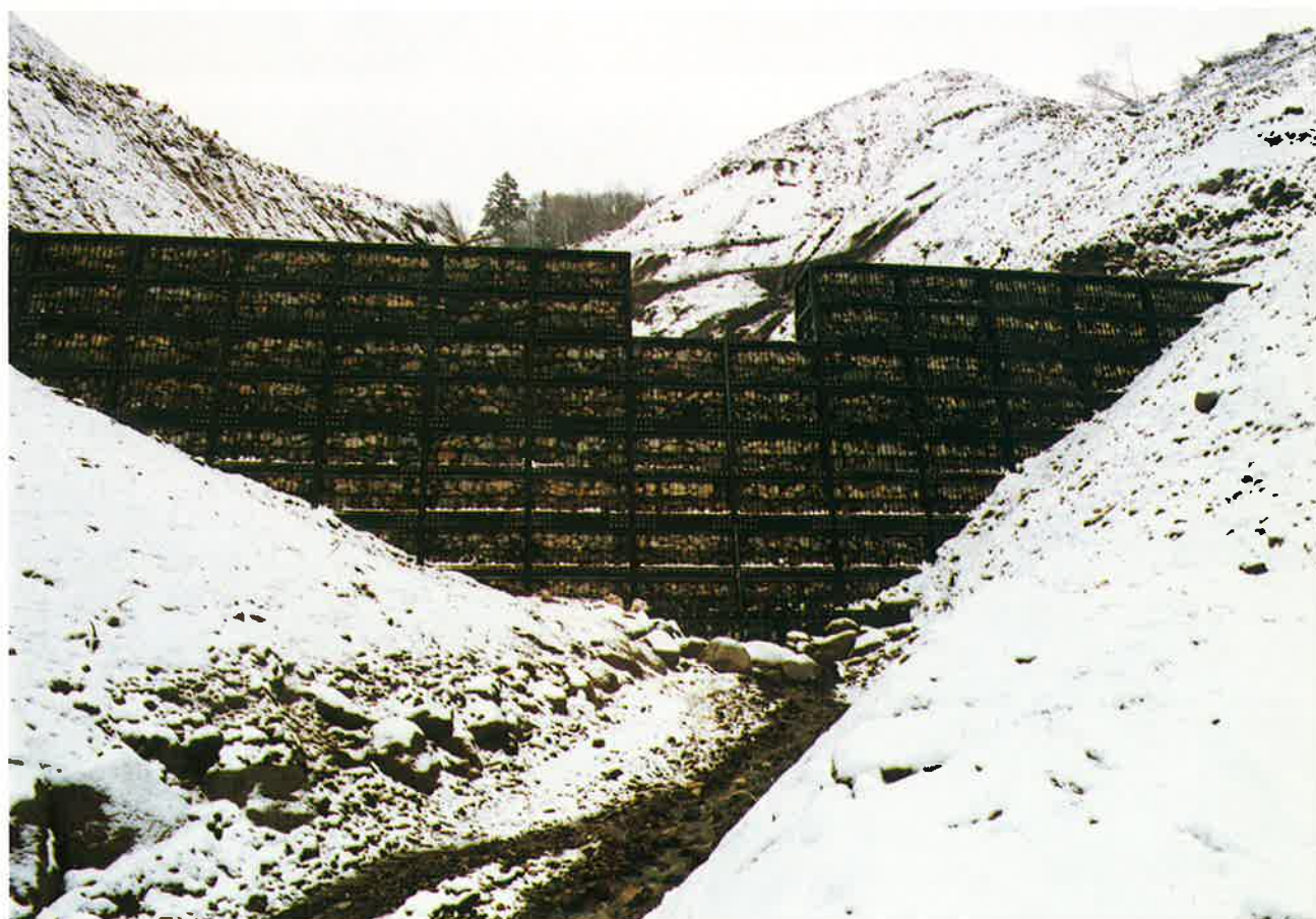
(滝 越) 地すべり脚部の押えとなる谷止工完成
