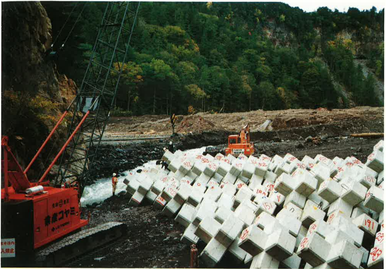
王滝川に流出した土石流の固定を図るブロック床固工
