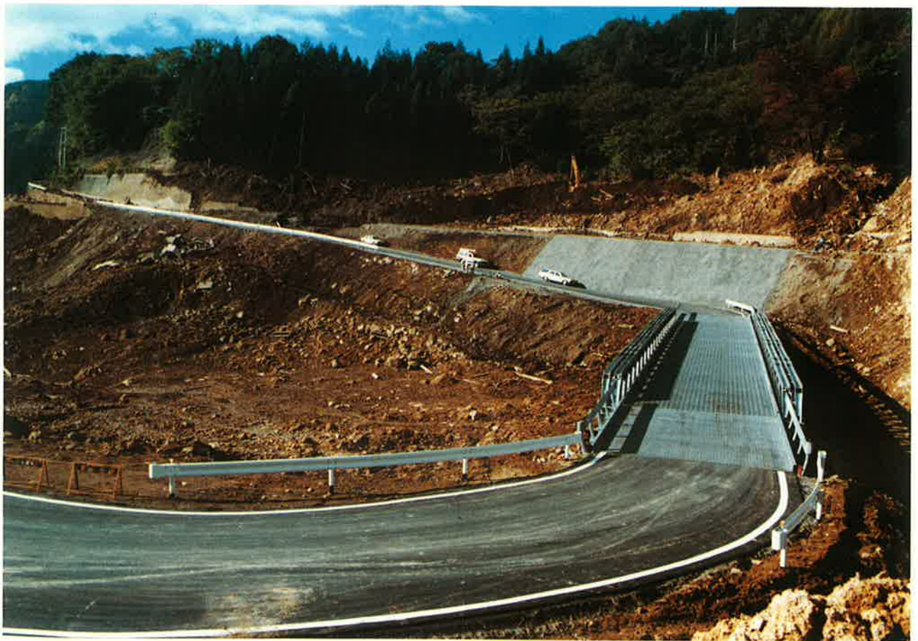
松越地区の大崩壊により流失した唯一の県道の仮復旧成る
