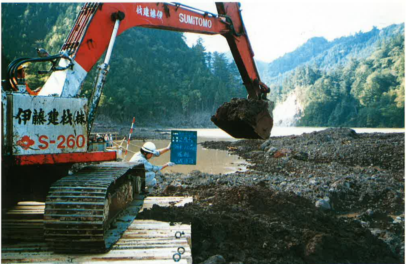
土石流により王滝川上流に出現した天然ダム湖からの流路開削工
