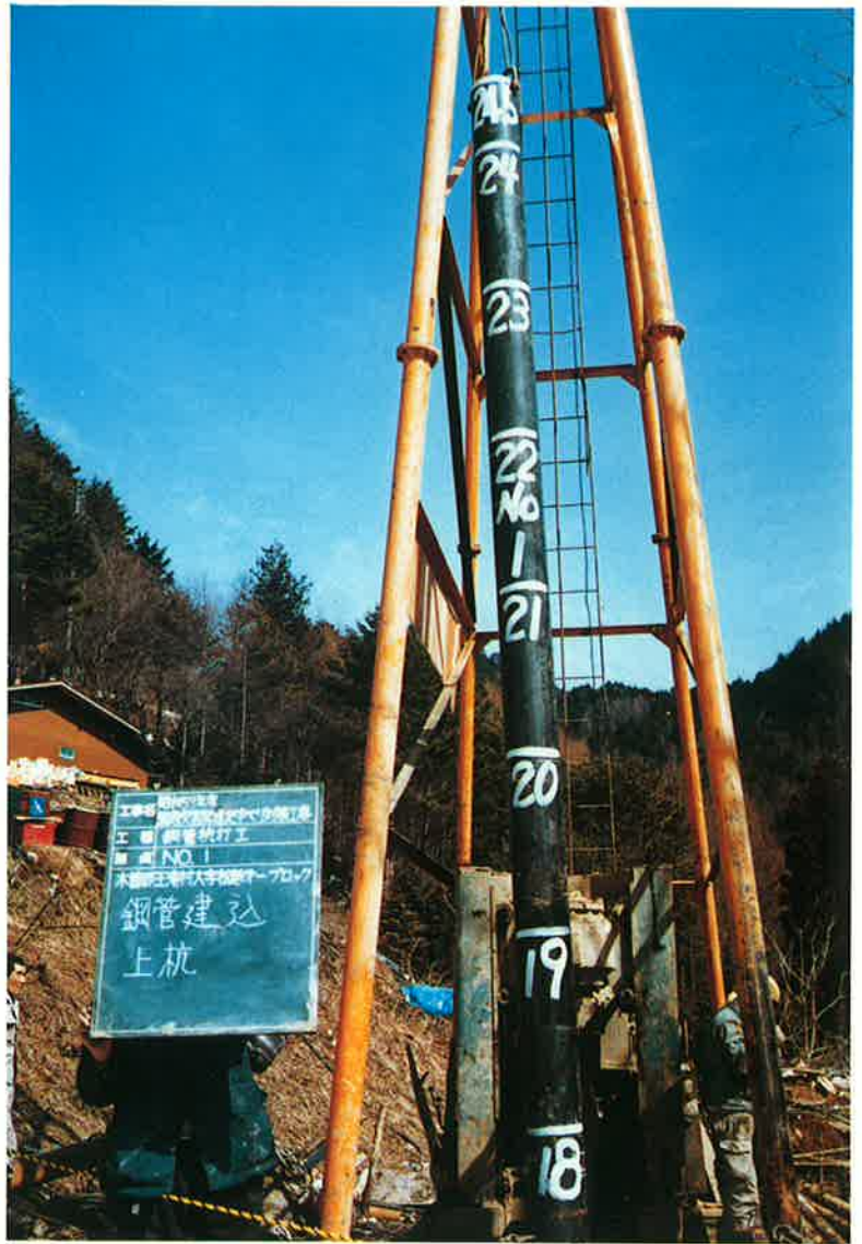
(松越) 地すべり抑止杭施工中
