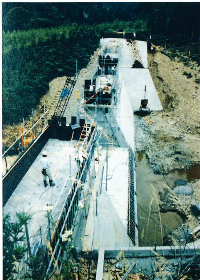
本堤施工状況 左岸より本堤を望む
