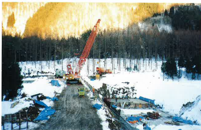
本堤施工中 前方仮排水路
