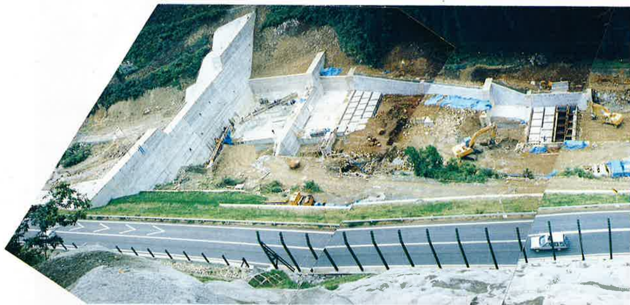
副堤、副々堤施工中 右岸より望む
