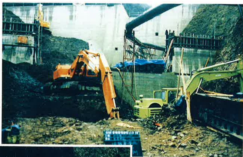
副堤 バックホー2台による堀削中
