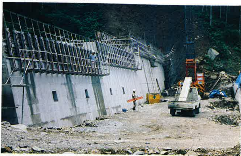
本堤型枠組立
