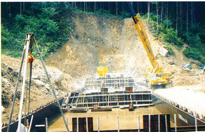
本堤バケットによるコンクリート打設
