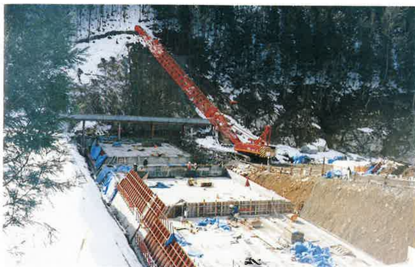
本堤コンクリート打設中
