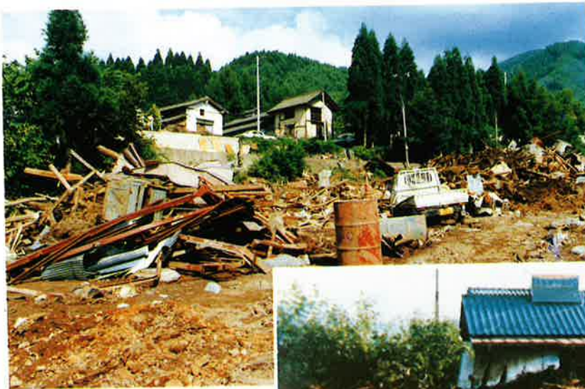
全壊家屋の残がい (仁礼町西原地区)
