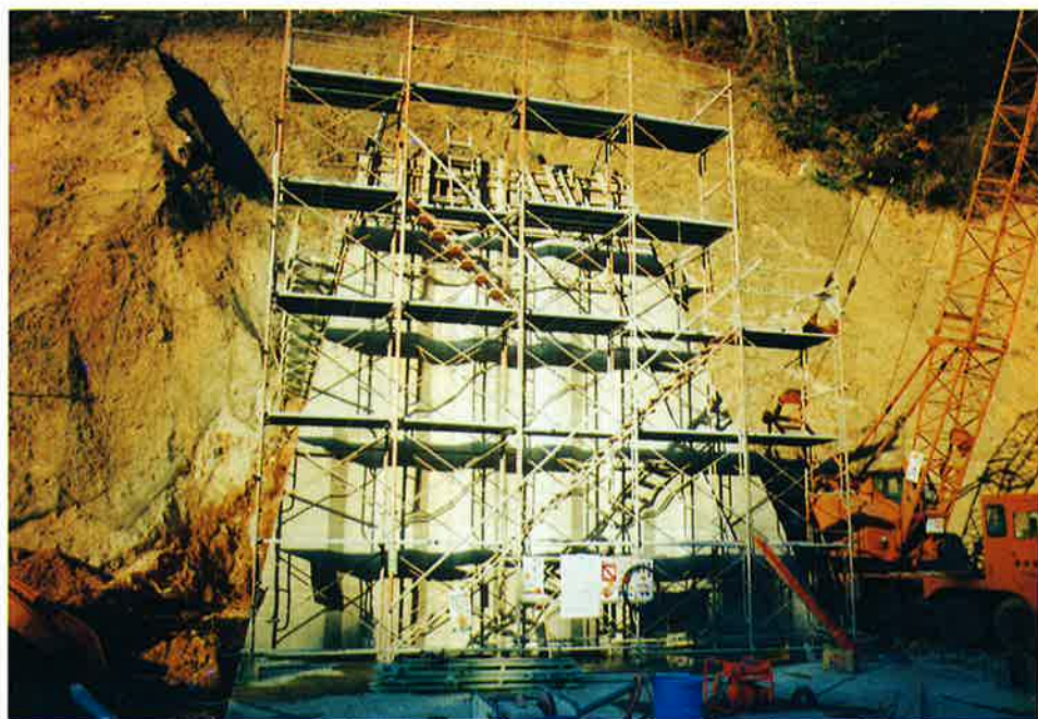
施工中の足場
