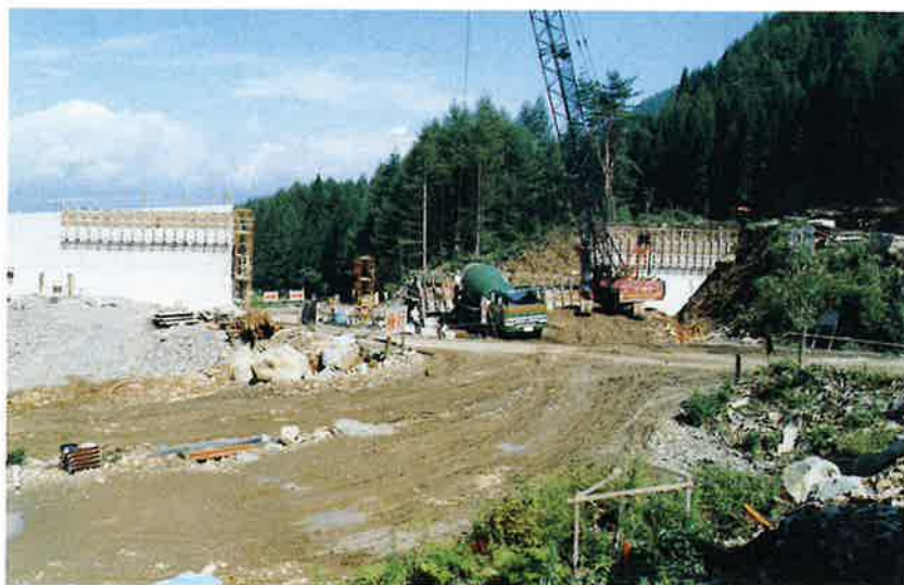
本堤コンクリート打設中
