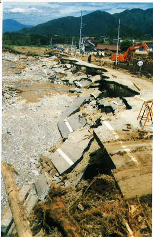
濁流にえぐられた県道中村長野線(現・長野須 坂インター線) (仁礼町関谷地区)
