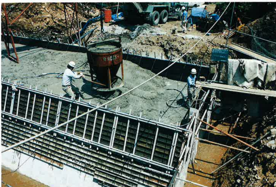
本堤コンクリートバケットによる打設中
