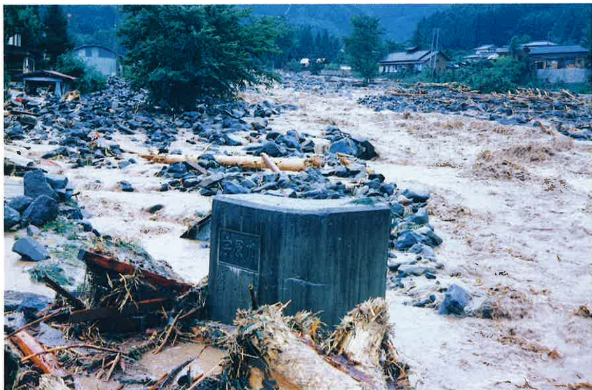
国道宇原橋付近 着手前
