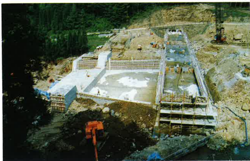
本堤右岸袖掘削完了
