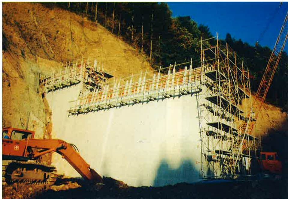
本提右岸袖部施工中
