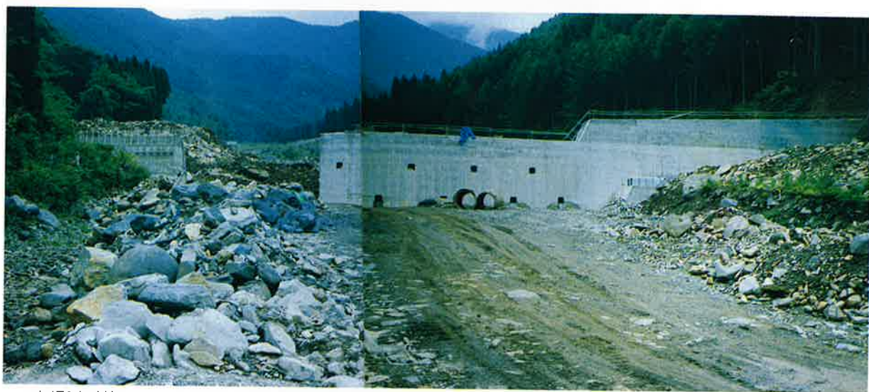
本堤形が整いつつある(右岸開口部運搬路に使用)
