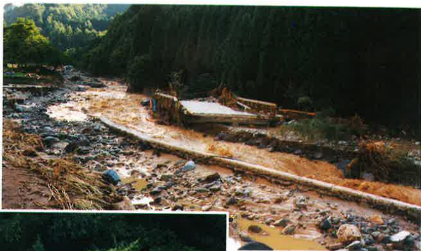
500 m 近くも流された瀬之脇 橋(コンクリート橋長さ29・1 m幅4・6 m) (仁礼町)
