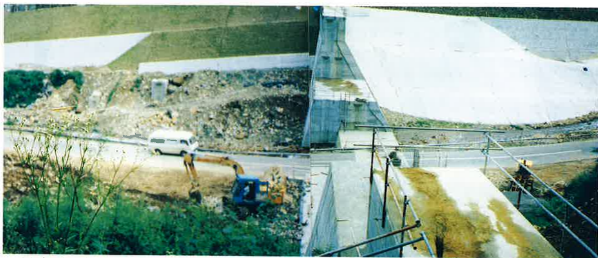
副ダム施工中
