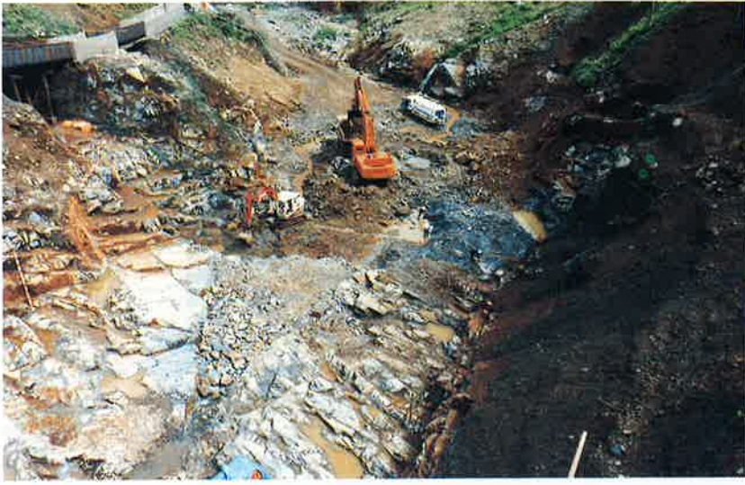
150tクローラークレーンによる本堤コンクリート打設
