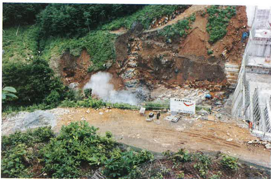
硬岩火薬による堀削作業中
