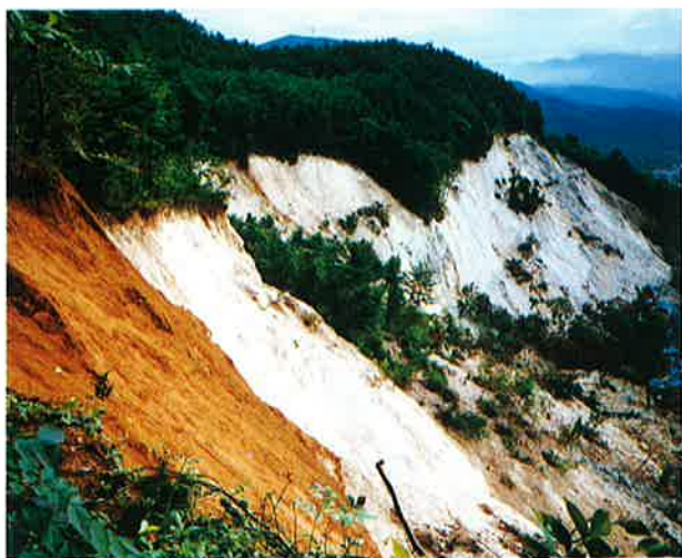
地すべり滑落崖(落差約70m)
