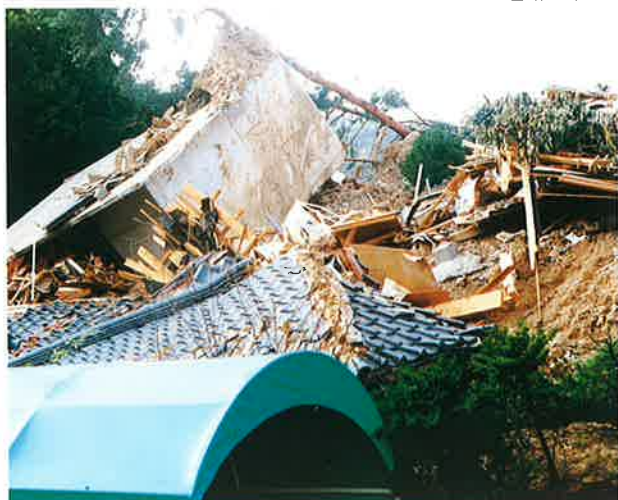
土砂に押し上げられたガレージ（不動域下方）
