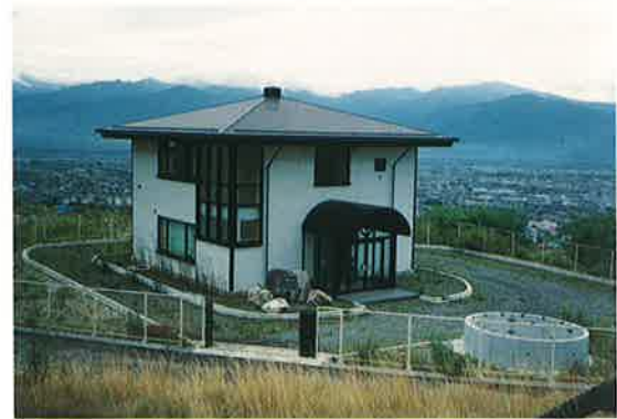
▲地すべり観測センター(自動観測システムの集中管理)
