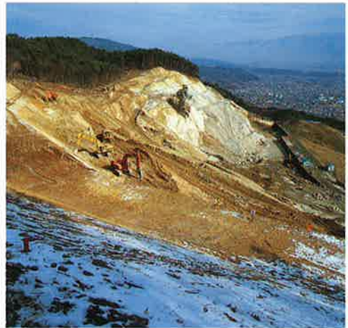
▼大型重機を用いた滑落崖斜面の掘削状況
