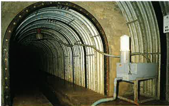
▲排水トンネル
