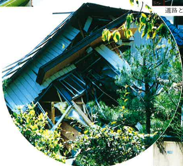
倒壊した家屋
