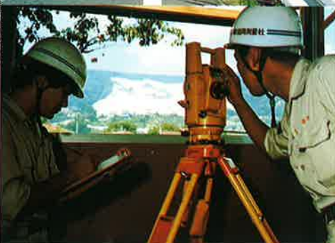
移動量を確認する光波測量
