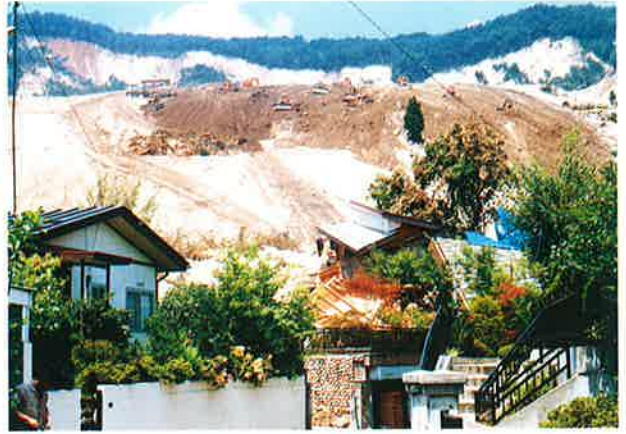
最高時28台のブルドーザーによる整地
