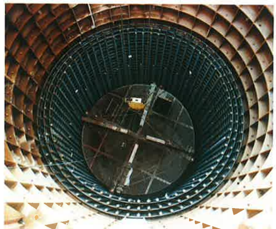
▲鉄筋組立(Dφ51)
