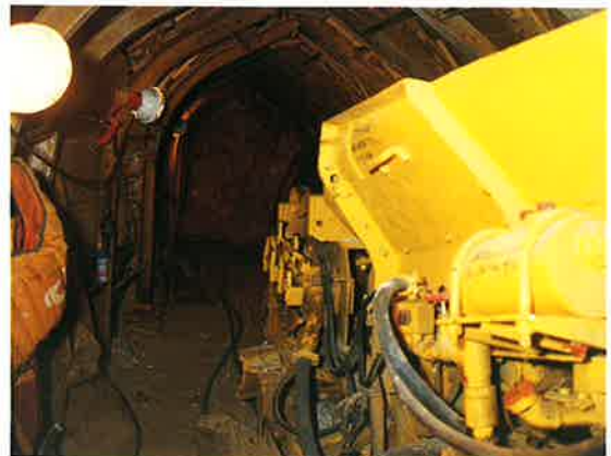
▲掘削中のトンネル内部
