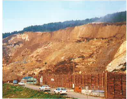
▲二次崩落直後の状況
