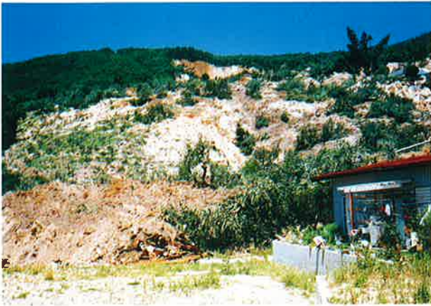
整地前（地すべり直後の土砂流出状況）
