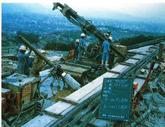
▲削孔及びケーシング抜の状況
