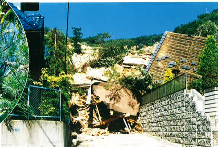
道路と下方の家屋へ押しよせた土砂、屋根
