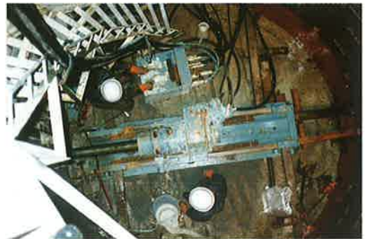
▲RCセグメント集水井ボーリング作業中
