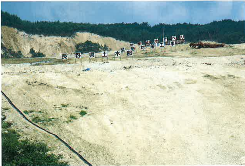
整地の完了した地すべり地
