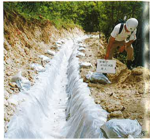
頭部からの雨水 排除のための仮排水路
