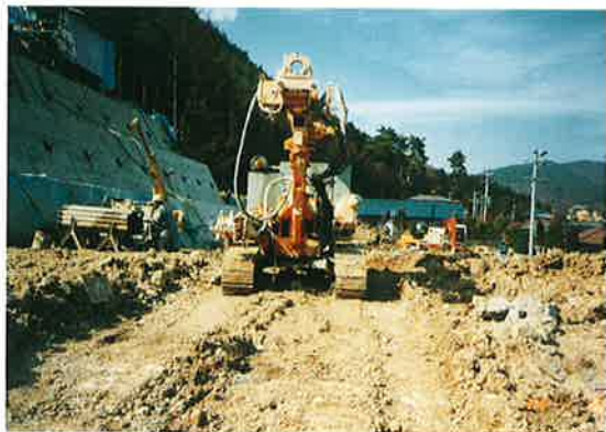
▲復旧工事が進む湯谷団地
