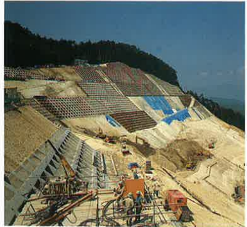
▼法枠工、アンカー工の施工状況
