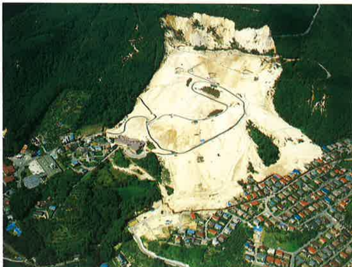
応急対策工事の完了した地すべり地全景
