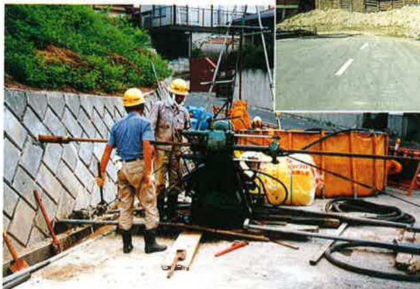
湯谷団地ですすめられた集水横ポーリング
