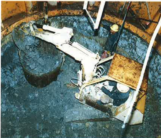
▲機械による掘削作業
