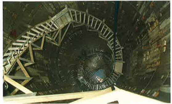
▲集水井(RCセグメント)
