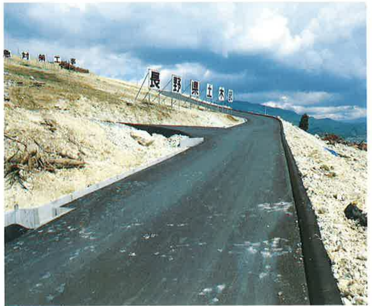
応急対策から恒久対策にむけてすべり地内に整備された仮設道路
