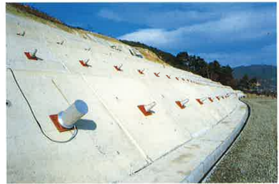
▲団地上部法枠アンカー工
