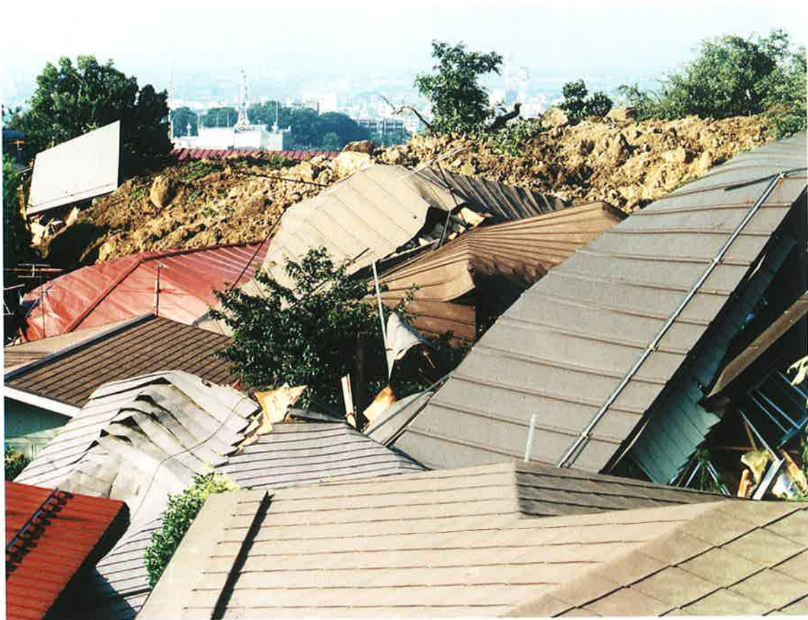
湯谷団地にあった住宅が、次々と土砂に押しつぶされました。
