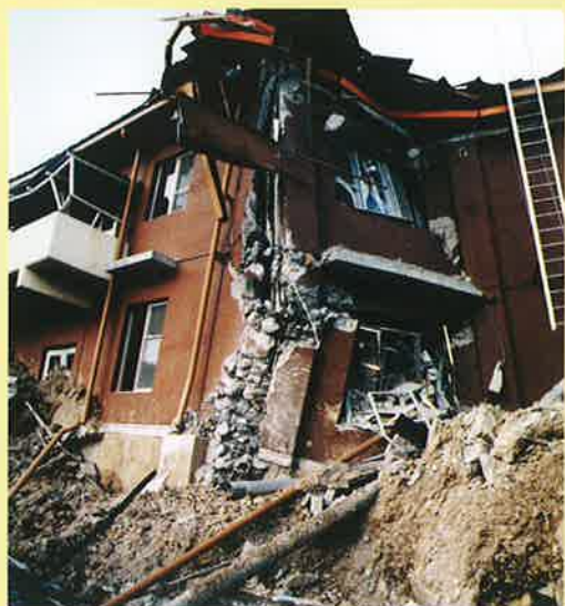
巨大な土のかたまりは、コンクリートの建物も押しつぶしました。
