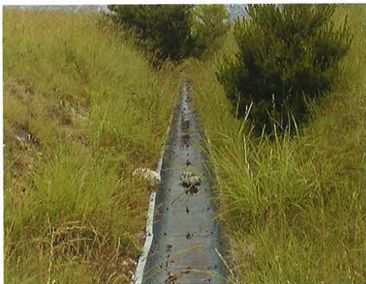
地附山のあちらこちらで水路工を見ることができます。
