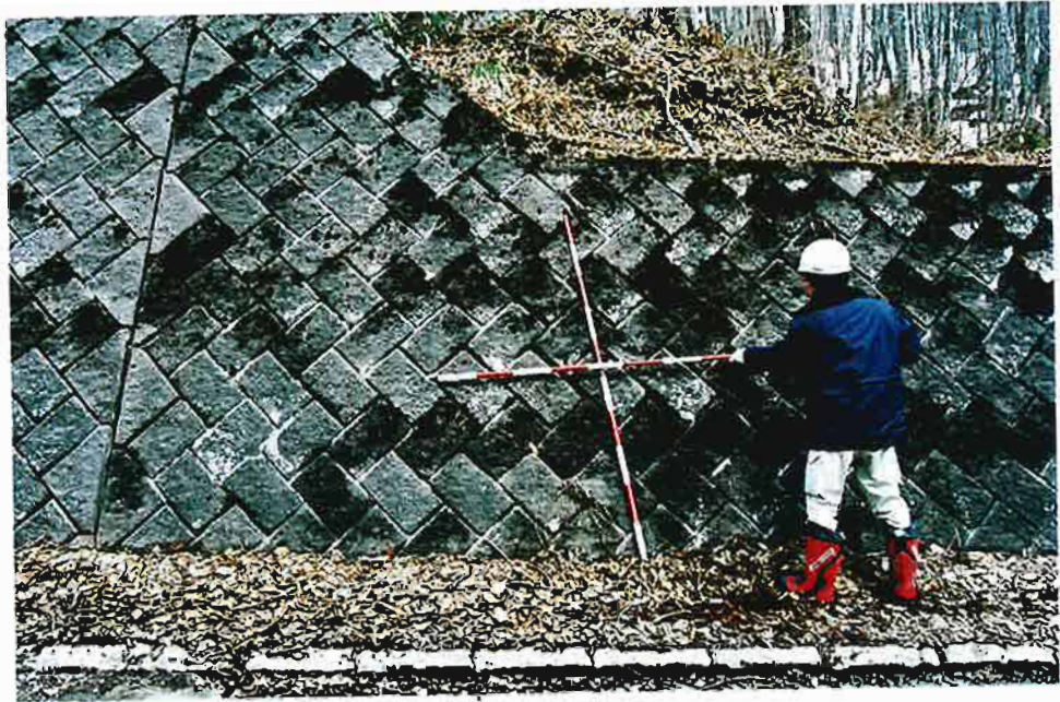
H10.3 末撮影 Aブロック西側部。擁壁の引っ張り亀裂。
