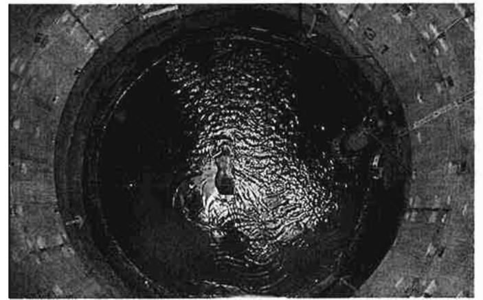
集水井掘削状況
