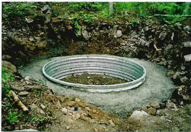
固定コンクリート打設
