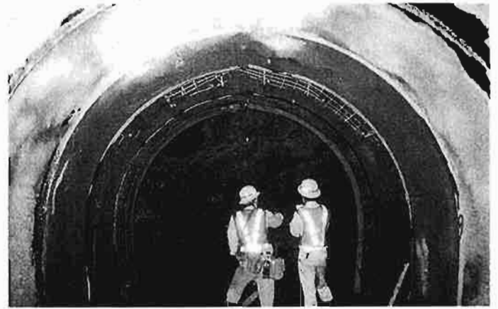
トンネル切羽状況
