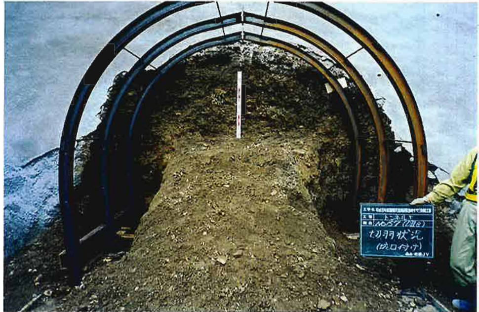
写真-1 切羽No.157の地質状況。褐色の崩積土堆積物より形成される。 (倉下旧期地すべり堆積物より構成)
