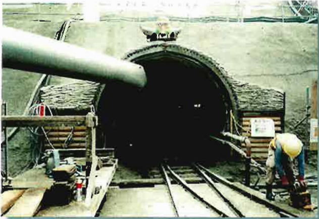
トンネル坑口
