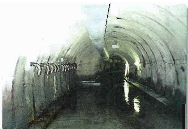
集水ボーリング室全景
