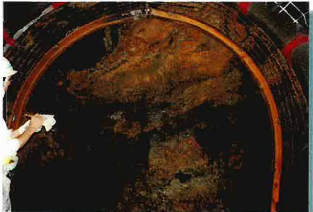
鋼製支保工・溶接金網設置状況
