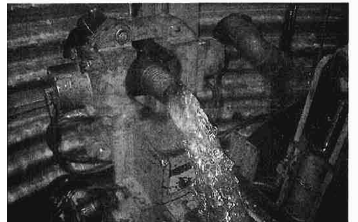
集水ボーリング掘削中の排水 (400l / min)
