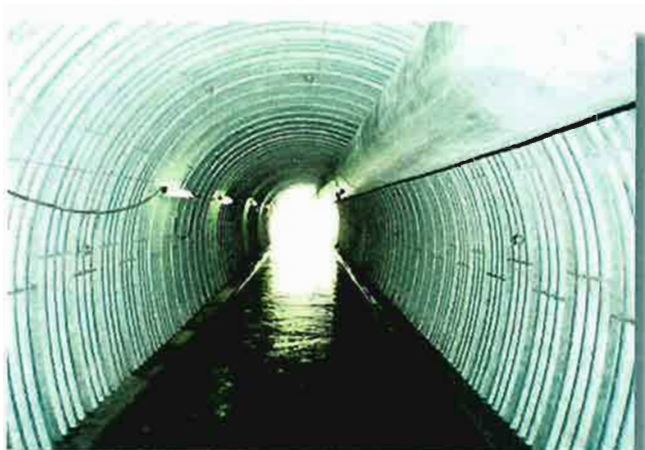
坑口部 (ライナープレート設置)
