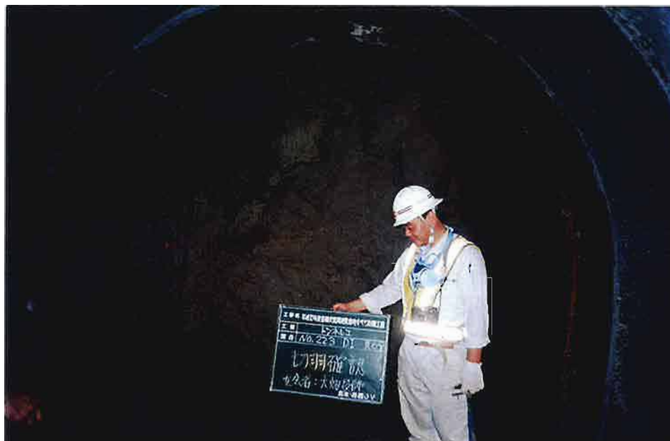
写真-1 切羽状況No.223 左上半より強風化凝灰岩層が分布して、白色を呈している。割れ目沿いには少量の湧水が認められる。
