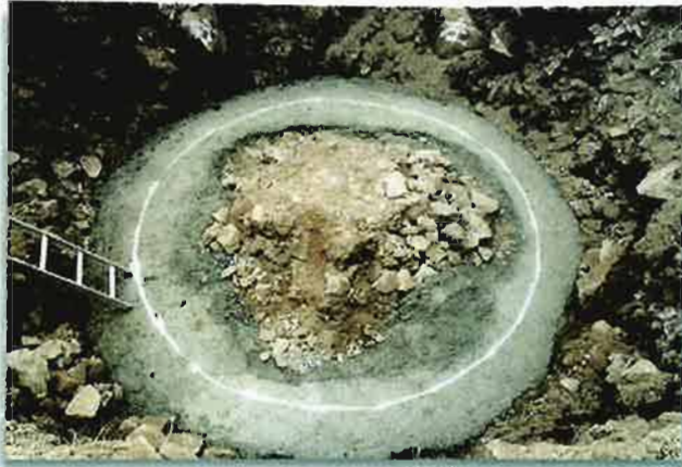
基礎コンクリート打設
