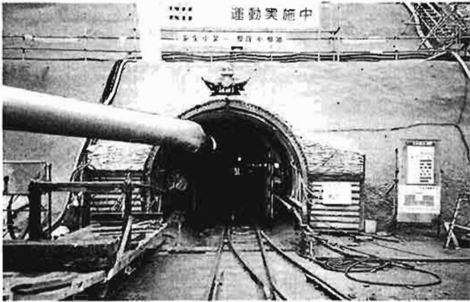
倉下排水トンネル工抗口
