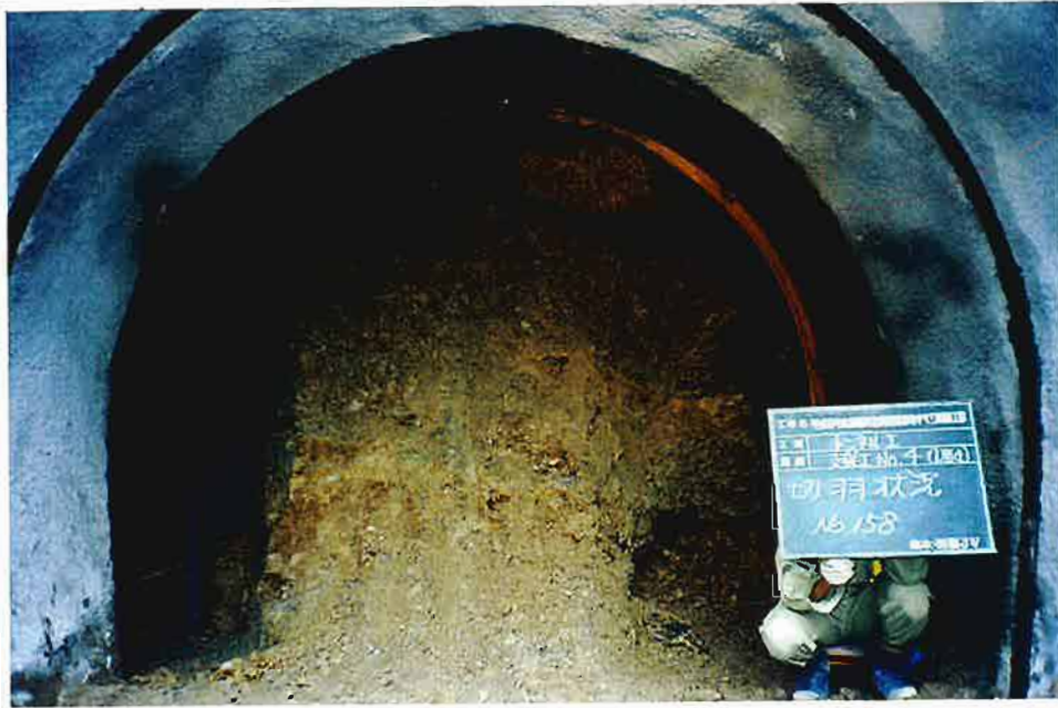
写真-3 切羽No.158 の状況。褐色を呈する崩積土部に右上側に黑色粘土層を含有する。全体に軟質である。
