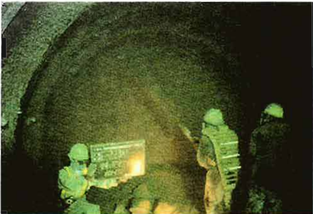
吹付コンクリート状況
