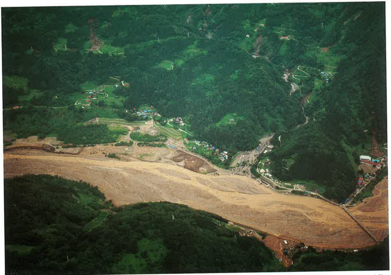
来馬地区人家上部で地すべり発生 土沢（右方）は土石流で荒廃、下方は姫川本川
