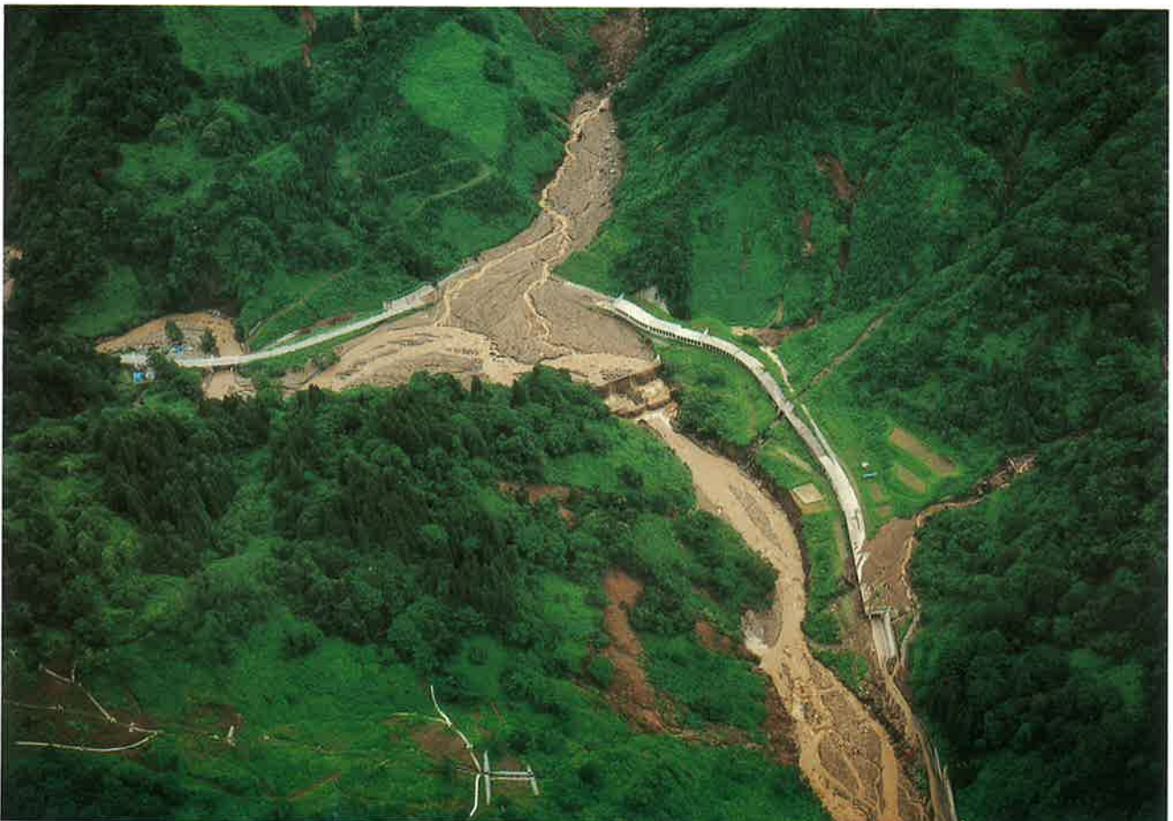
中谷川支川押立沢の土石流が県道に氾濫
