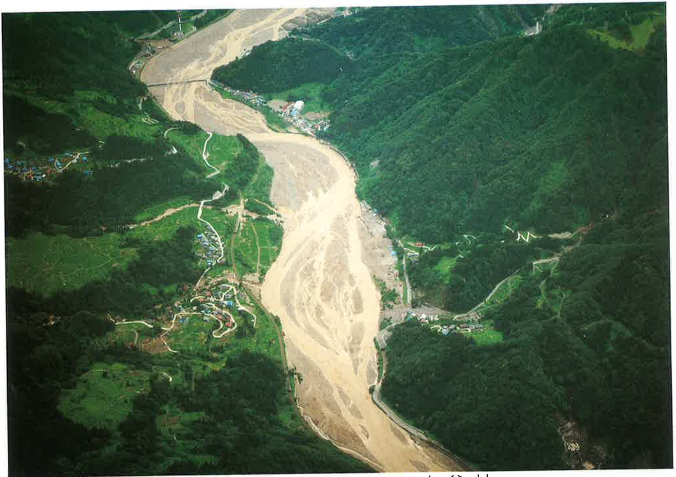
土石流が国道148号、村道等へ氾濫、姫川本川は土砂で満杯
