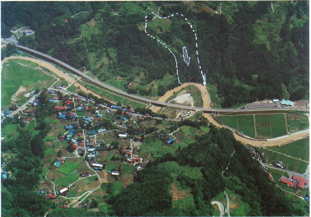
成山地区で地すべり発生、土尻川に土砂を押し出す
