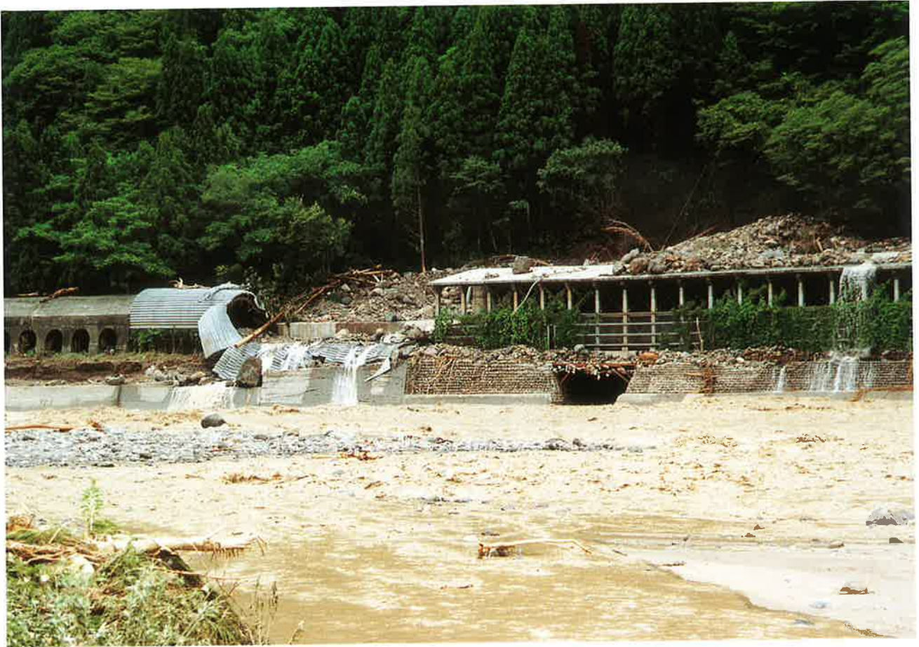
土石流によりJR大糸線損壊
