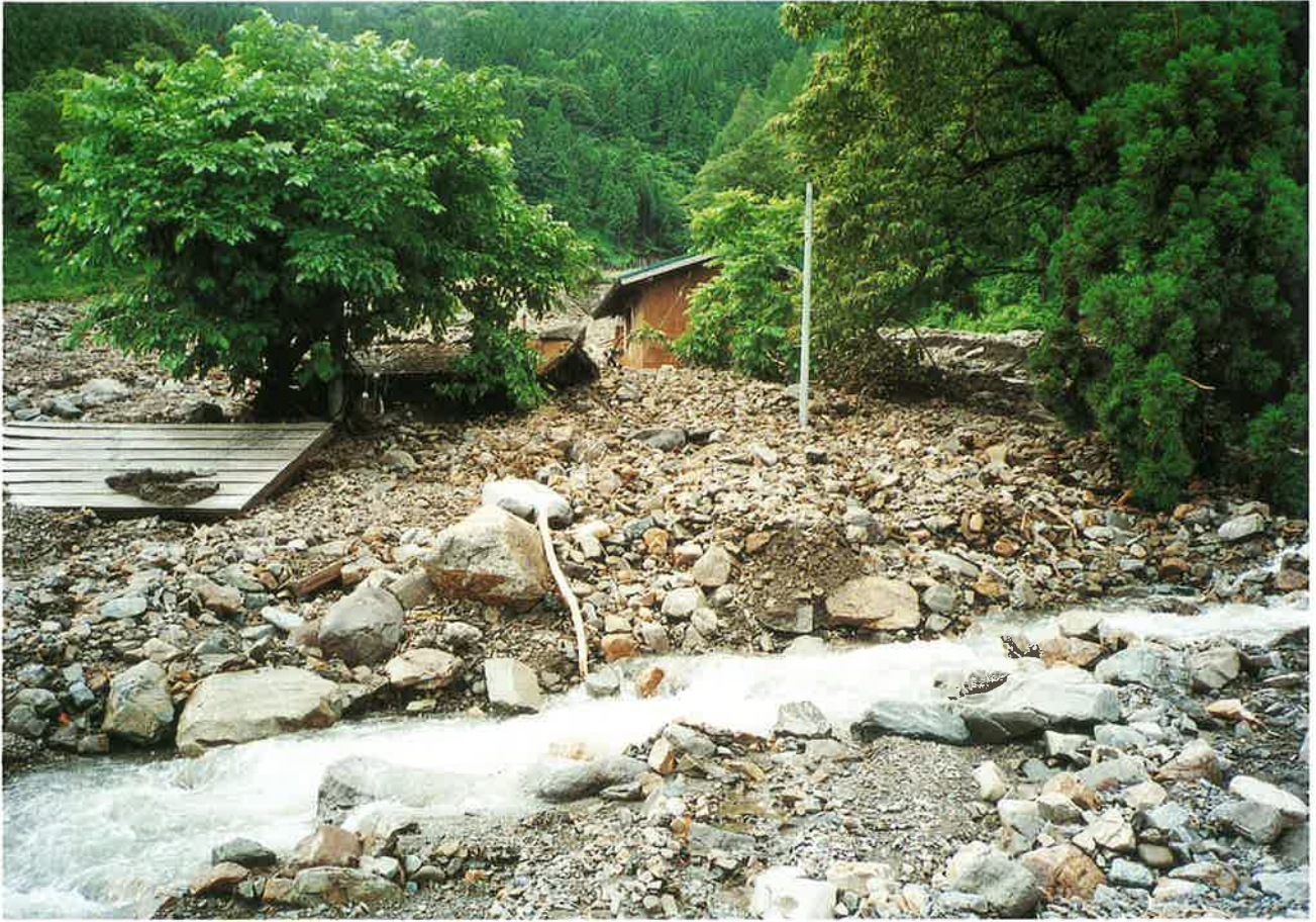
土石流により下流家屋全壊
