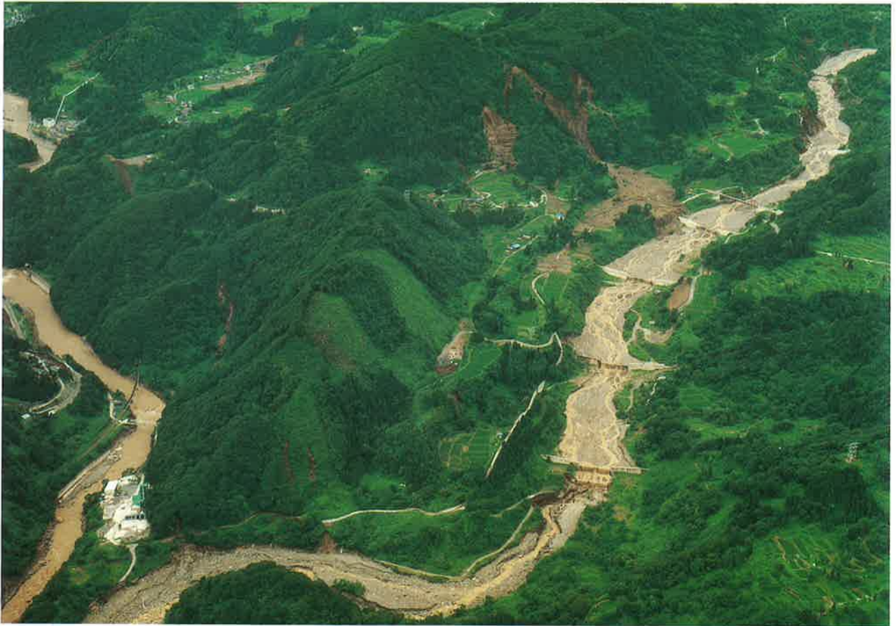
浦川土砂流出状況、左は姫川本川
