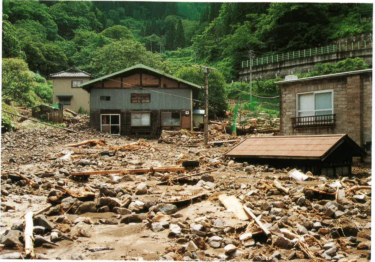
土石流により家屋埋没
