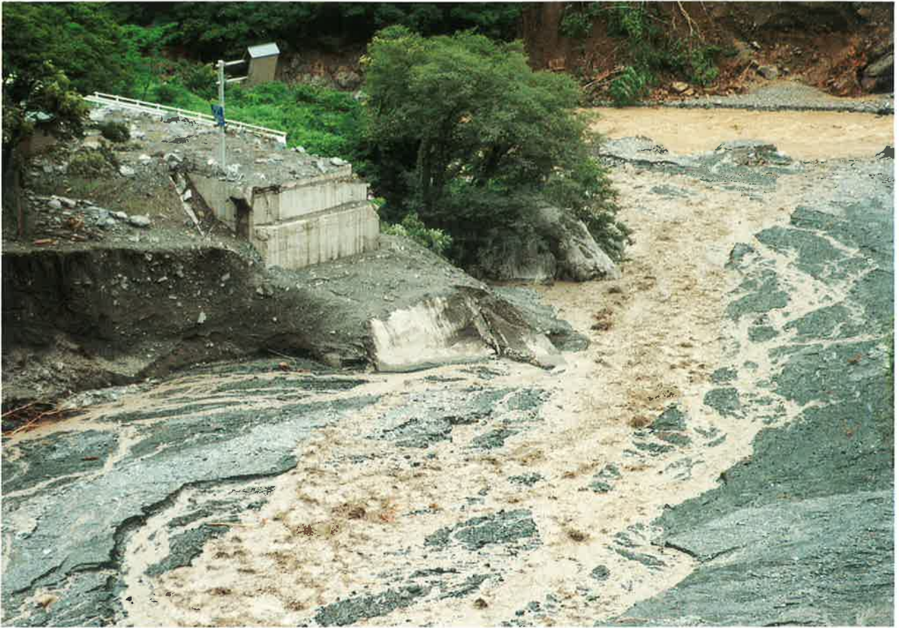
土石流で国道148号国界橋流失
