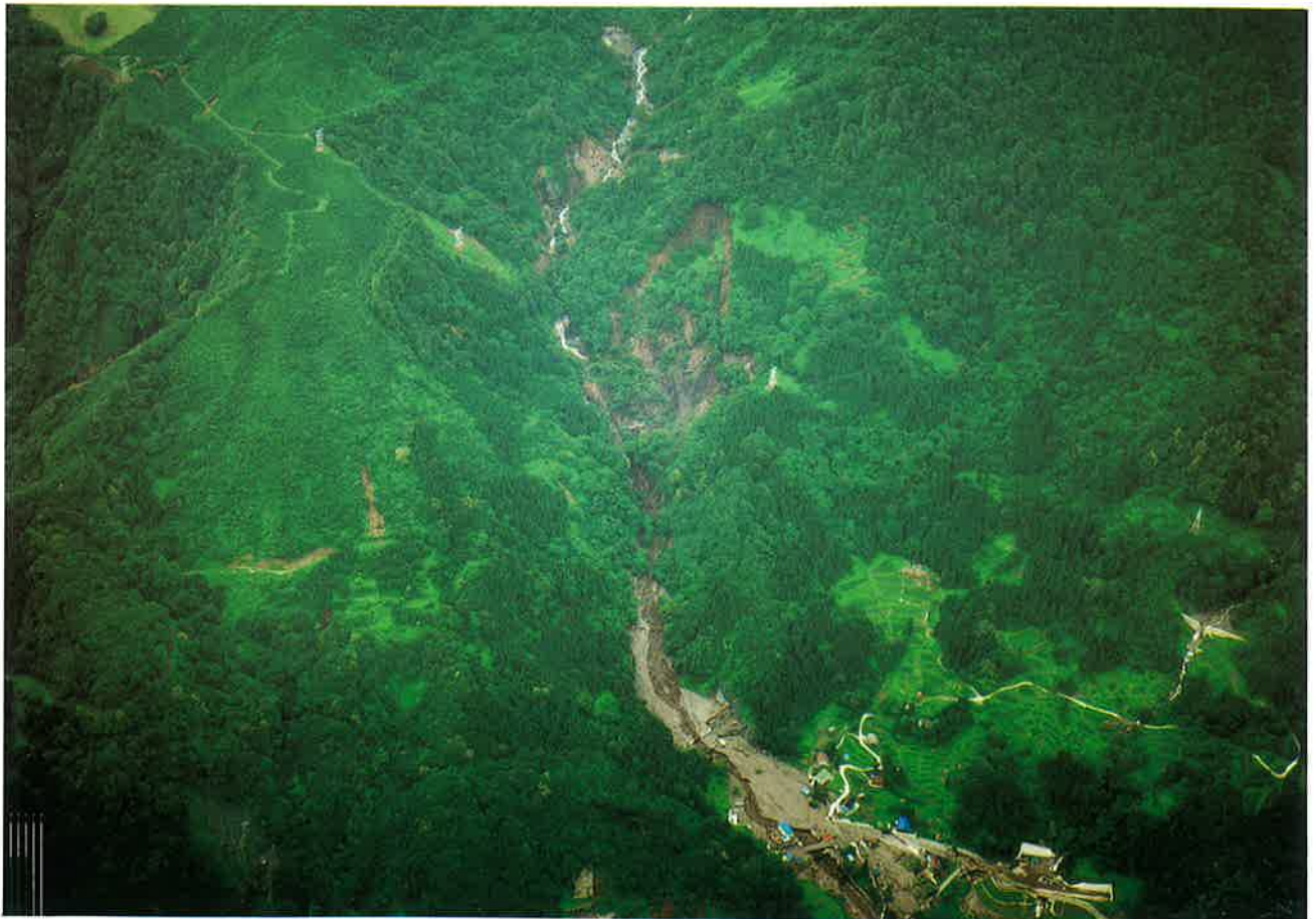
山腹崩壊、土石流発生
