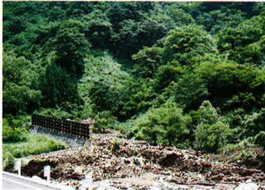
▲中谷川へ土石流が流出
