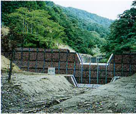
▲黒木沢鋼製枠ダム完成
