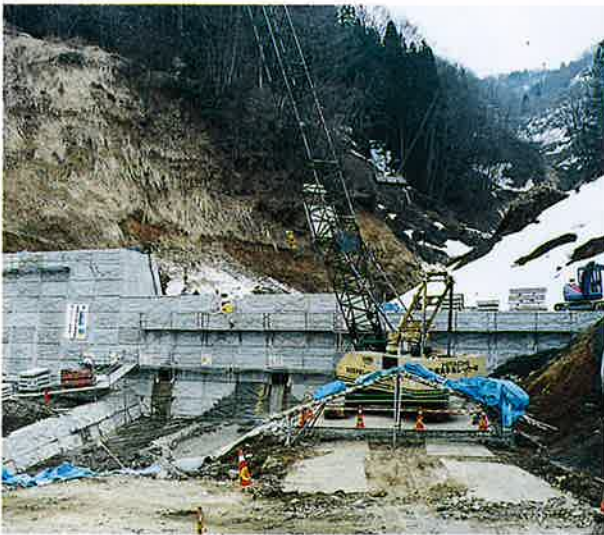
▲施工中の第7号コンクリートダム
