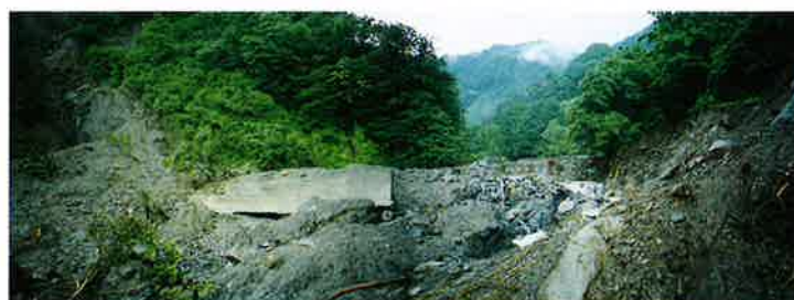
破壊された土沢川5号堰堤
