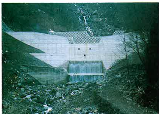
▲コンクリートダム完成
