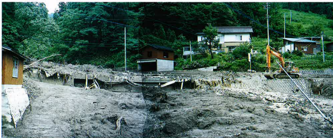
▼土石流により被災した県道川尻小谷糸魚川線
