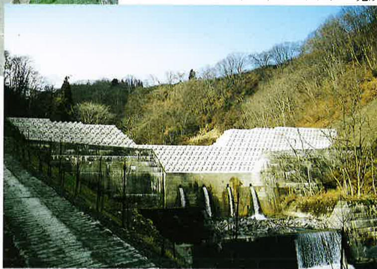
▼コンクリートブロックダム完成
