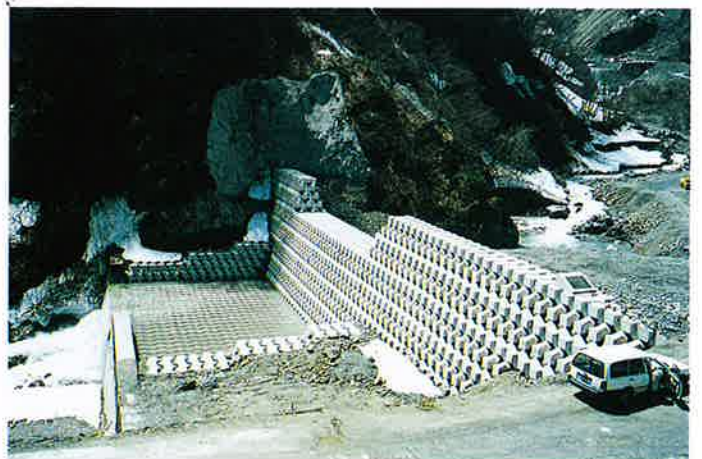
▲2号ブロックダム完成
