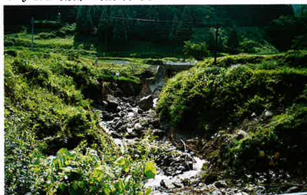
▼JR上流部の流失状況
