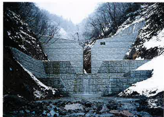
▲コンクリートスリットダム完成
