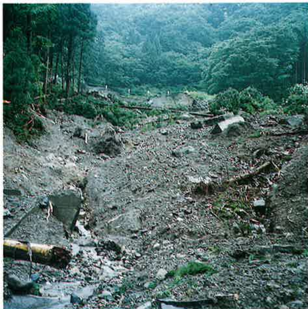
▼山腹崩壊状況
