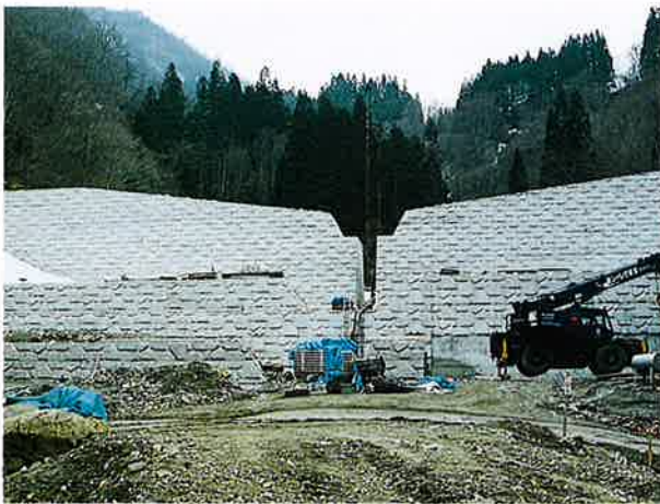
▲コンクリートスリットダム完成
