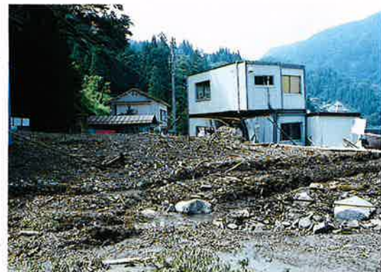
▲国道及び家屋破損
