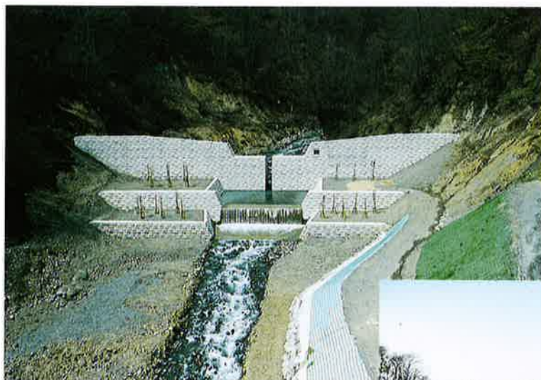
▲コンクリートスリットダム完成
