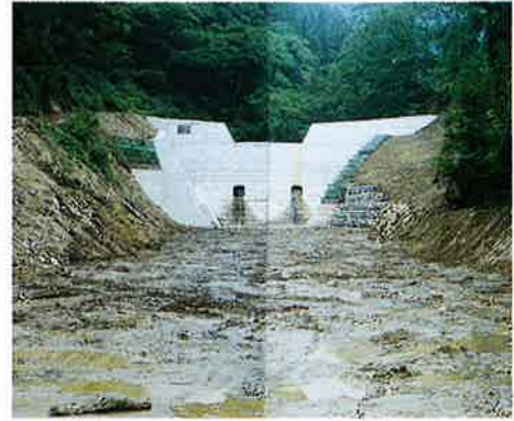
▲稲葉沢コンクリートダム完成
