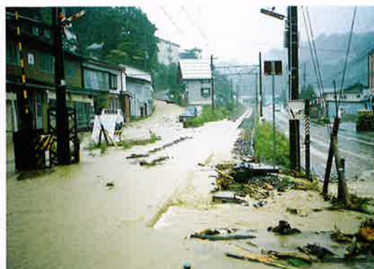
▲南小谷駅構内に流入した土砂
