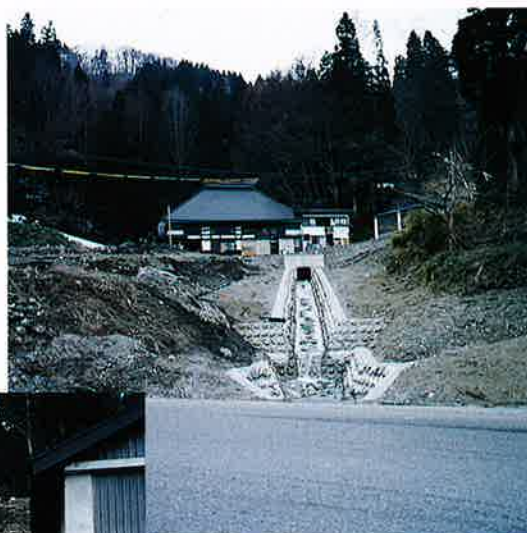
▲流路工 下流部完成状況
