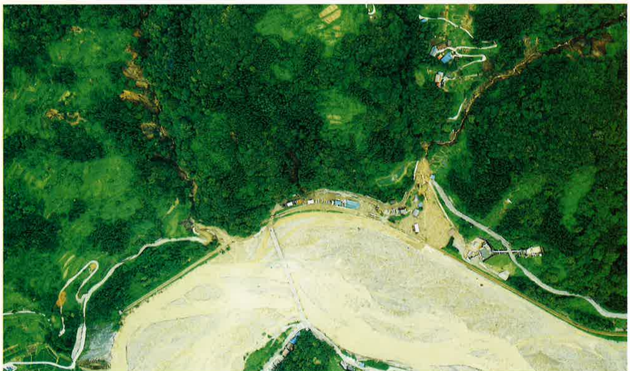
(被災後 平成7年7月)
