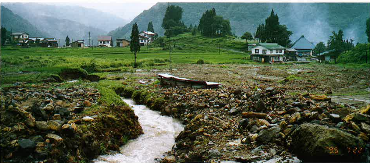
▲上流池原地区の埋没した水田
