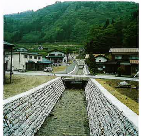
▼玉石積流路工
