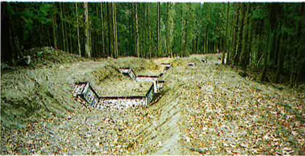
▲ビヤクボ沢 谷止工完成
