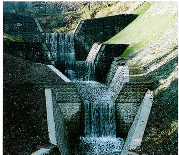
▲淀沢鋼製枠ダム
