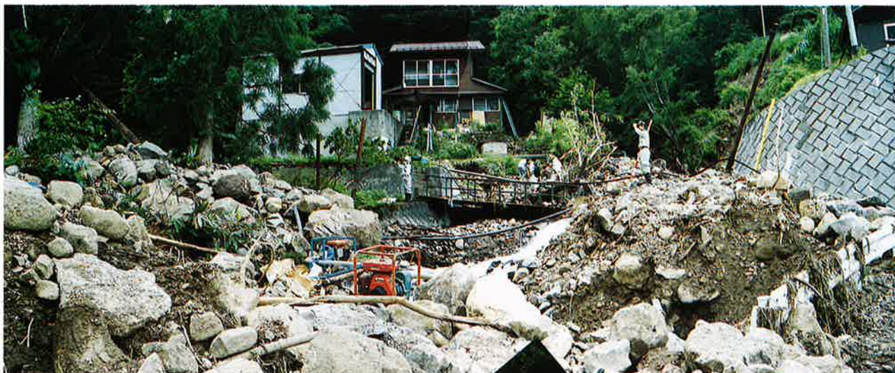
▲日影沢合流付近の土石流
