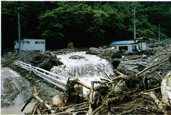
▲村道橋より上流被災状況
