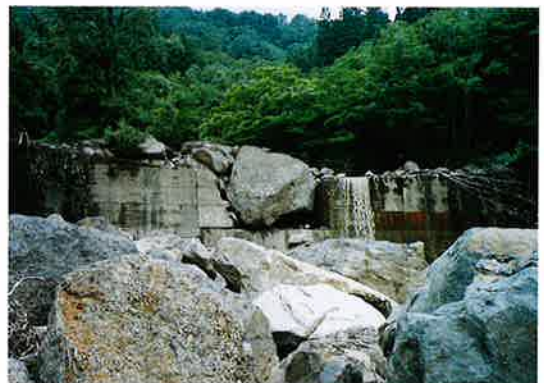
▲戸石沢 土石流により巨石が既設ダム水通しを直撃
