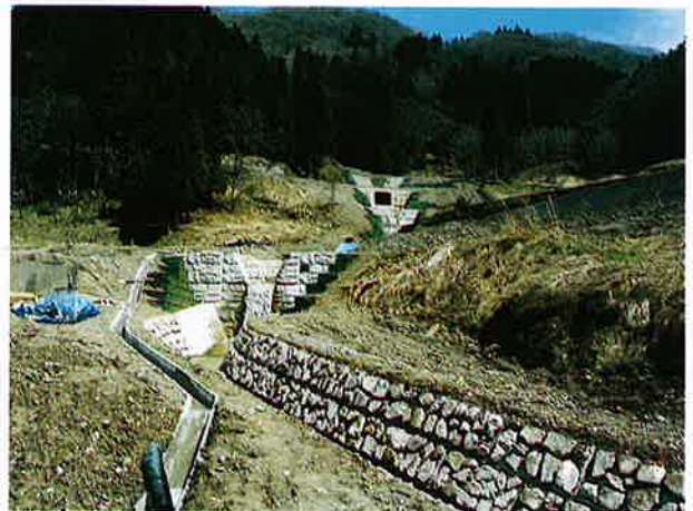
▲支川蟹沢流路工完成
