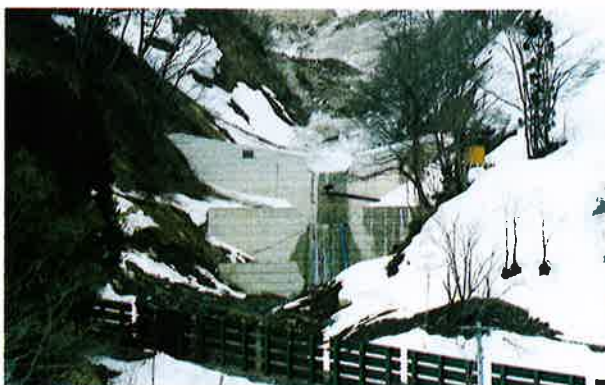
▲コンクリートダム完成
