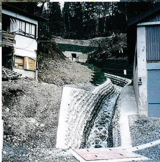
▲流路工 中流部完成状況
