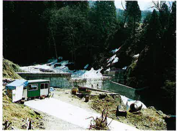
▲白井沢コンクリートダム完成(暫定)
