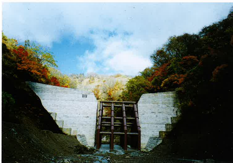
▲ 鋼製格子形ダム完成
