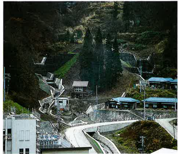
▲日影沢.淀沢合流付近の完成状況
