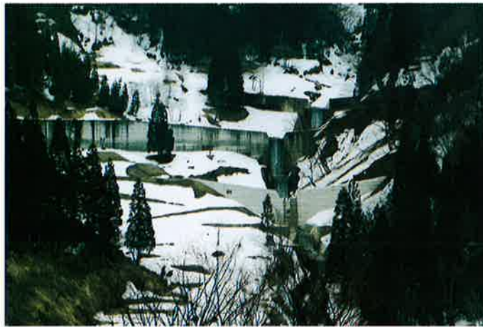
▲戸石沢コンクリートダム完成
