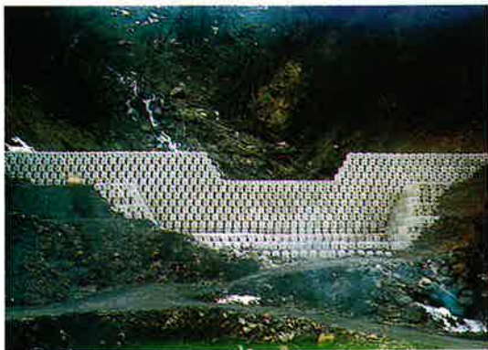
▲ブロックダム完成
