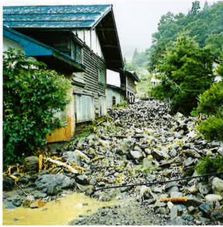
▼土石流が河道埋塞人家に流入
