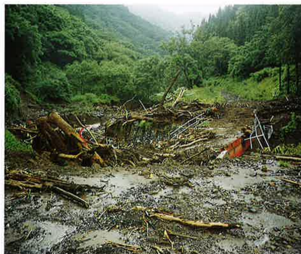
▲土石流により埋没した橋梁
