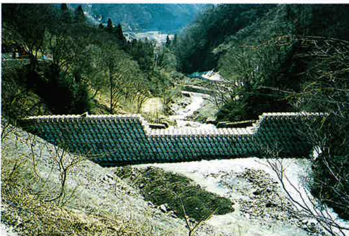
▲1号ブロックダム完成
