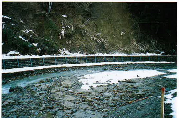
▲山腹崩壊部の護岸工
