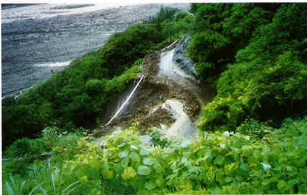
▲小山沢国道148号沿い氾濫状況
