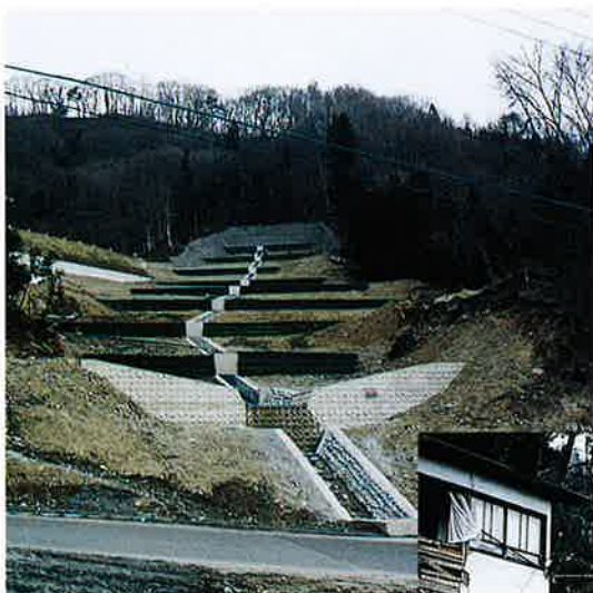
▲山腹工完成状況
