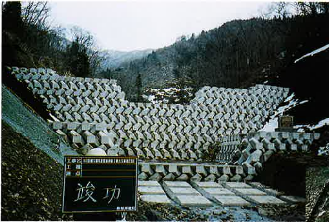
▲支流小日向沢に設置した コンクリートブロックダム
