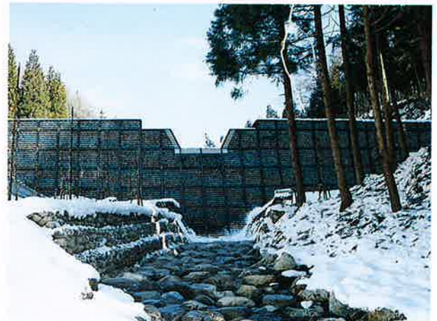
▲鋼製枠ダム完成
