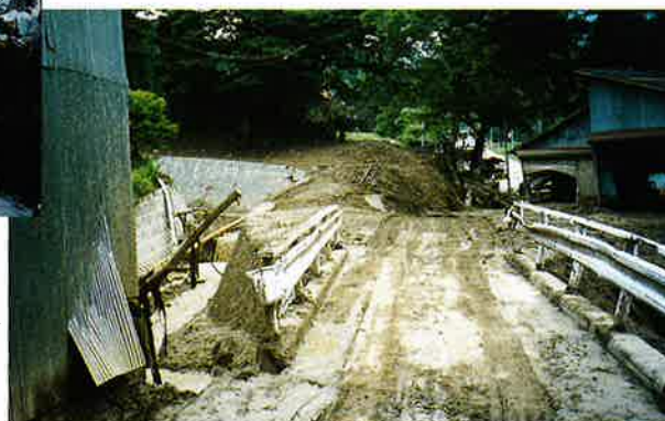
林道橋を乗り越えた土石流 ▶
