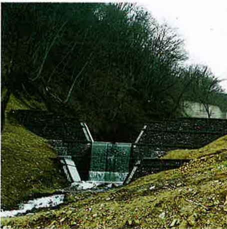
▼上流鋼製枠ダム
