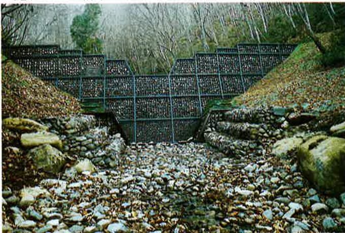
▼完成した小清水沢鋼製枠ダム
