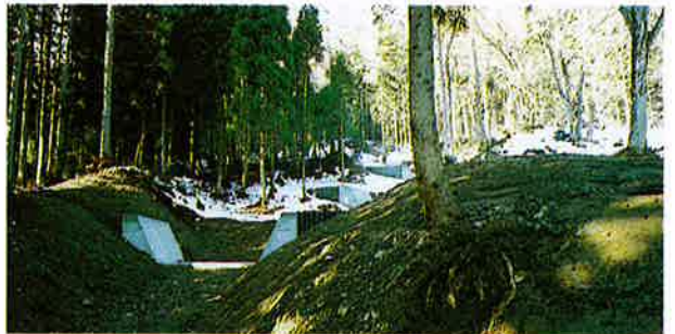
▲北山沢 谷止工完成
