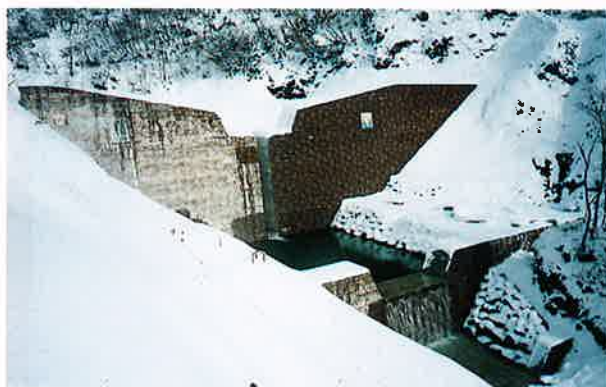
▲コンクリートスリットダム完成
