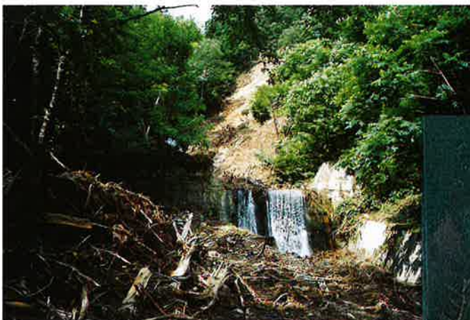
◀ 既設砂防ダム袖を乗り越えた土石流
