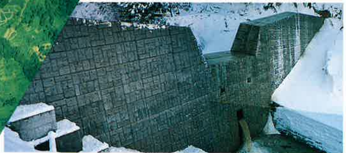
▲山口上砂防ダム完成
