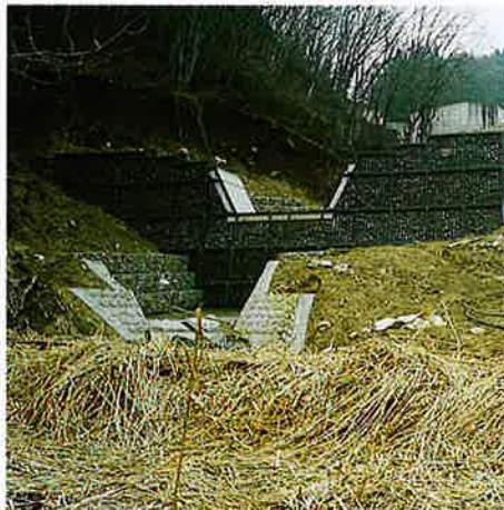
▼流路工直上流鋼製枠ダム
