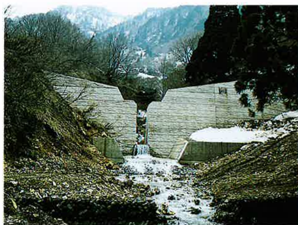
▲コンクリートスリットダム完成
