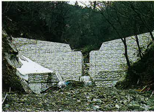
▲上流コンクリートスリットダム完成
