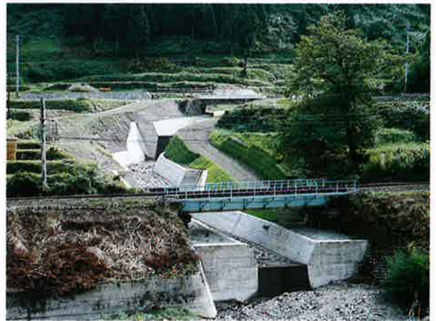
▲完成した下流流路工
