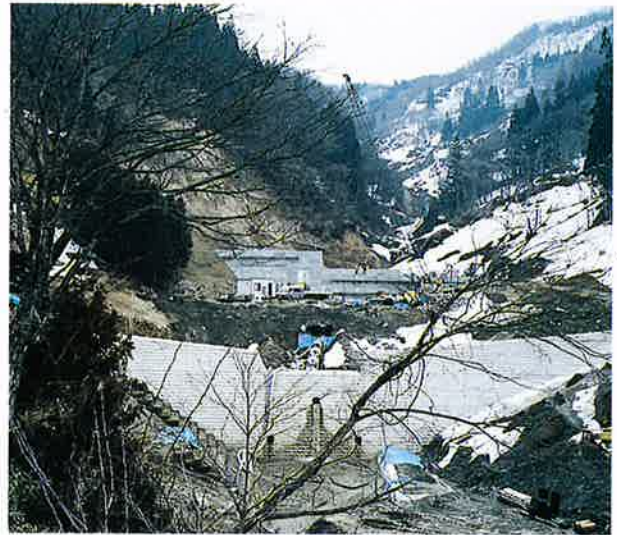
▲前処理を残して完成した第6号コンクリートダム
