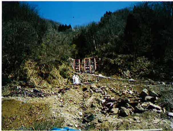
▲支川水頭沢スリットダム完成
