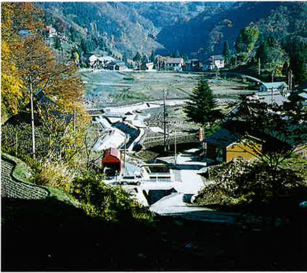
▲最上流よりの復旧状況
