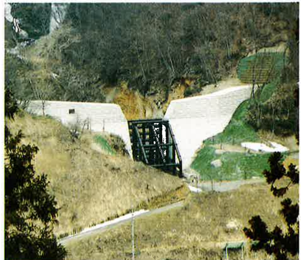
▲格子形鋼製ダム完成 下流部巨石護岸
