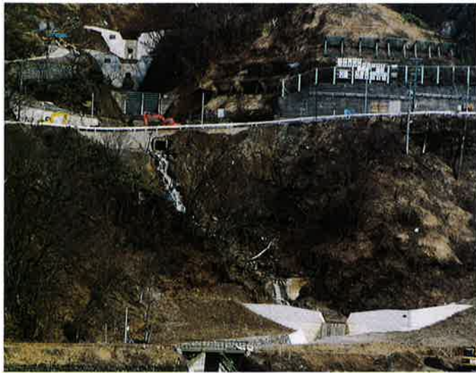
▲小山沢国道上下流ダム完成
