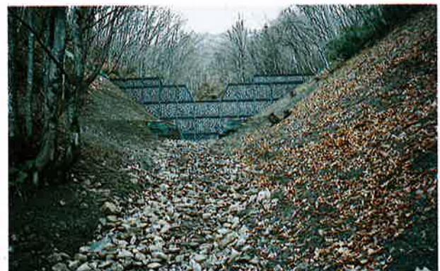
▲完成した清水沢鋼製枠ダム
