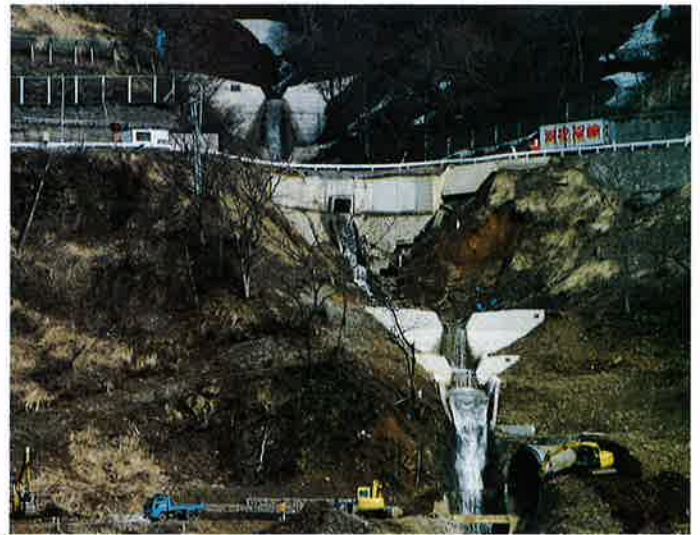
▲社沢国道上流ダム及び下流床固工
