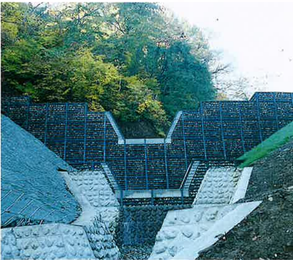
▲日影沢鋼製枠ダム
