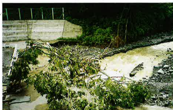
▲下流部氾濫状況
