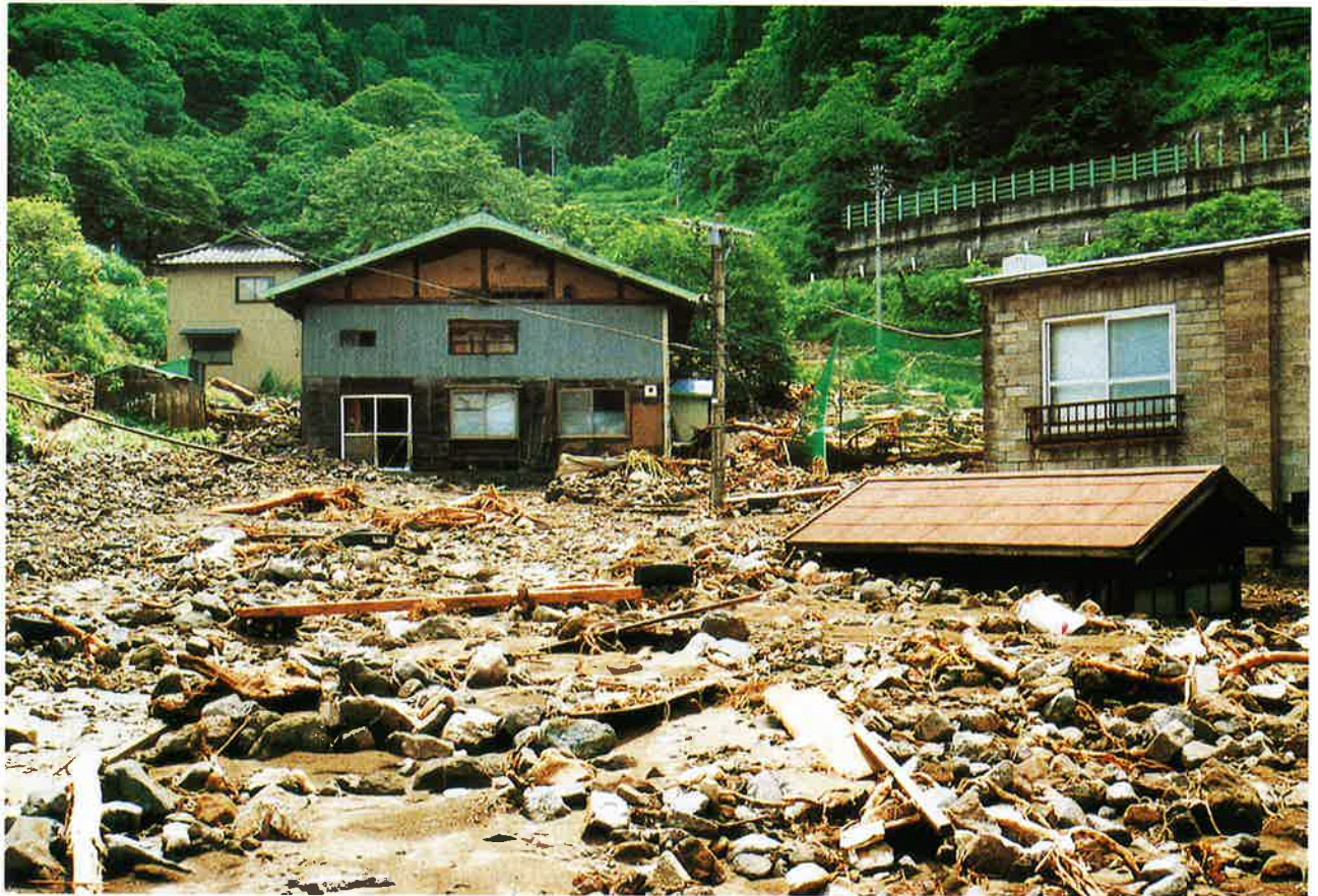
土石流により家屋埋没
