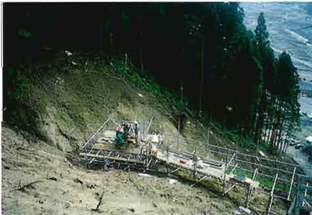
横ボーリング工施工状況
