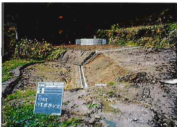
完成した集水井
