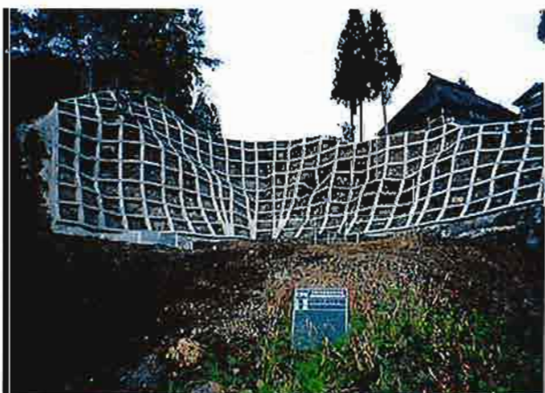
完成した法枠工
