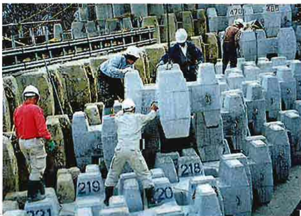
ブロック積ダム高上げ工施工中
