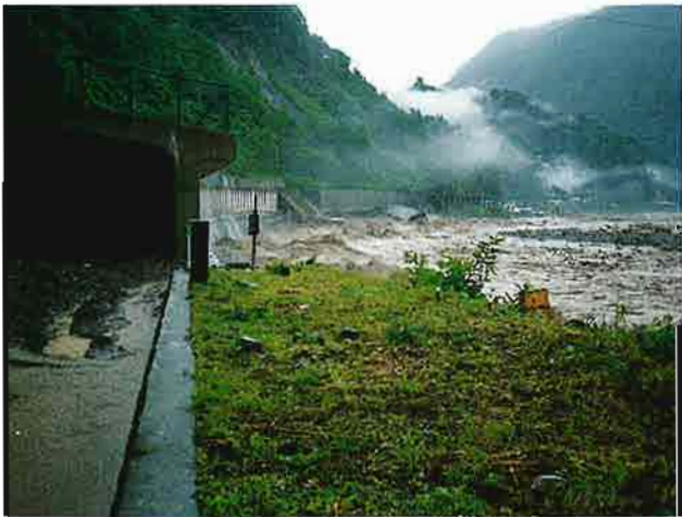
小谷村 北小谷 (下寺洞門被災直前)
