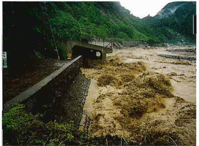
小谷村 北小谷 (下寺洞門被災直後)
