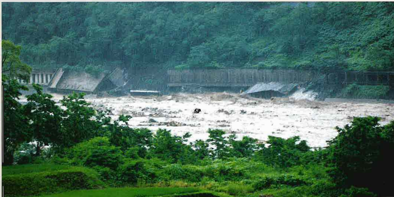
小谷村 北小谷 下寺洞門
