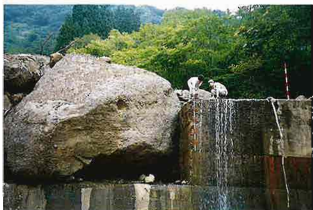
災害査定の準備（大きな岩が砂防ダムに流入）
