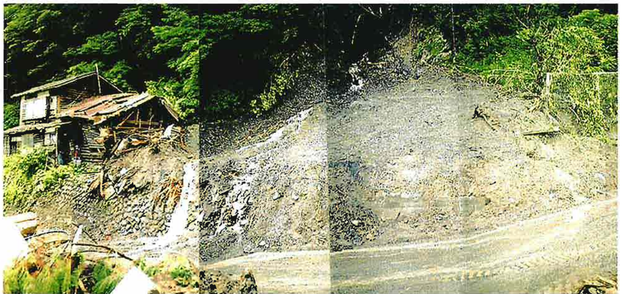
崩壊地末端部 沢より押し出した土砂により民家半壊。国道部に堆積した土砂は排除されている。
