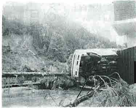
白馬ハイランドホテルの裏山が崩れ、一部崩壊
