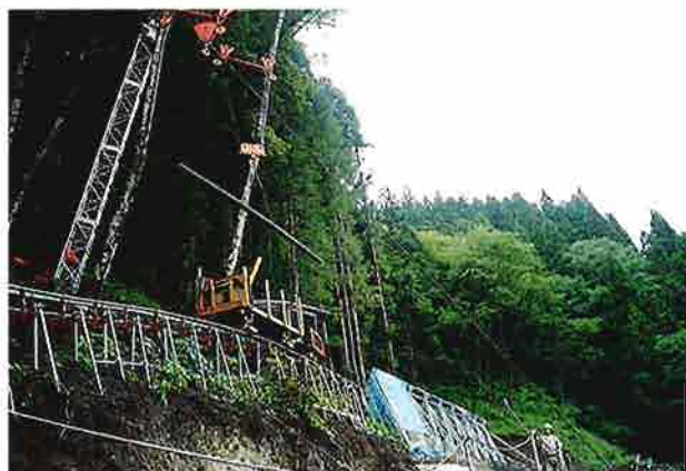
資材運搬 急斜面地の上部に索道やモノレールを利用して、効率的に資材を運搬する。
