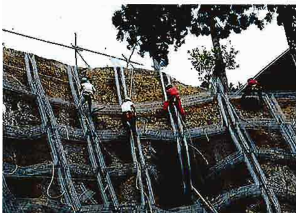
ロックボルト付吹付枠工施工状況 上部滑落崖施工。
