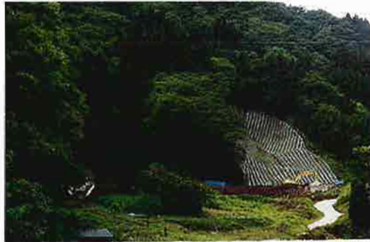
七滝沢 小谷村 下里瀬第3工区
