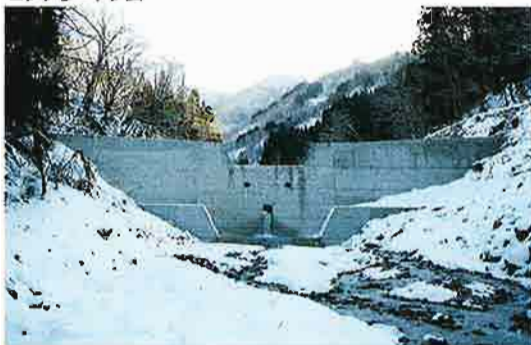
濁沢 小谷村 深原第2工区
