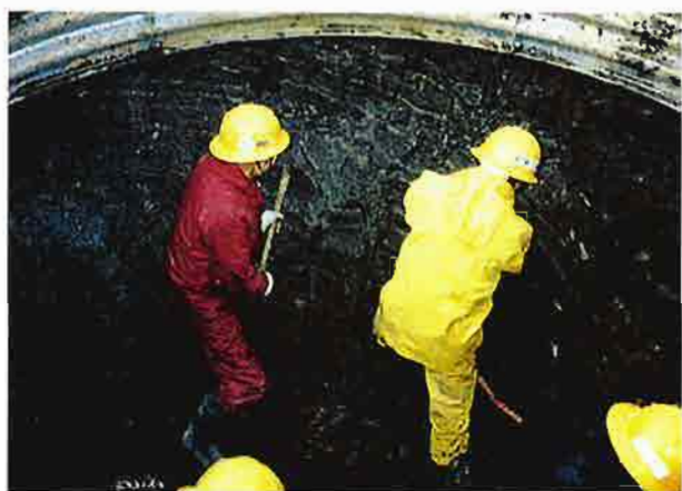
集水井工掘削状況 16~33mの井戸を人力により掘削する。
