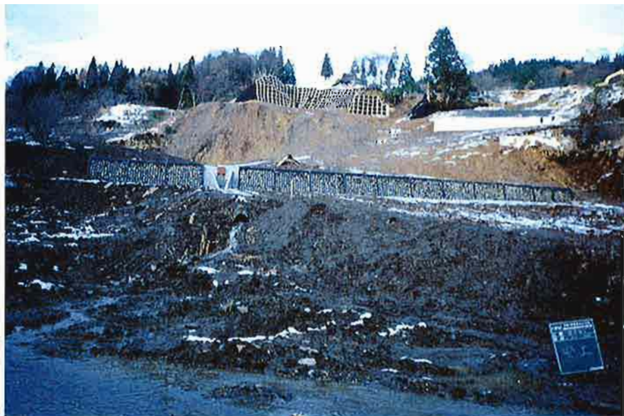
対策工の進む地すべり地内
