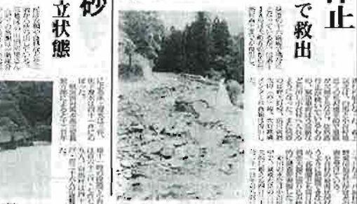
崩壊した道路、小谷村の被害状況
