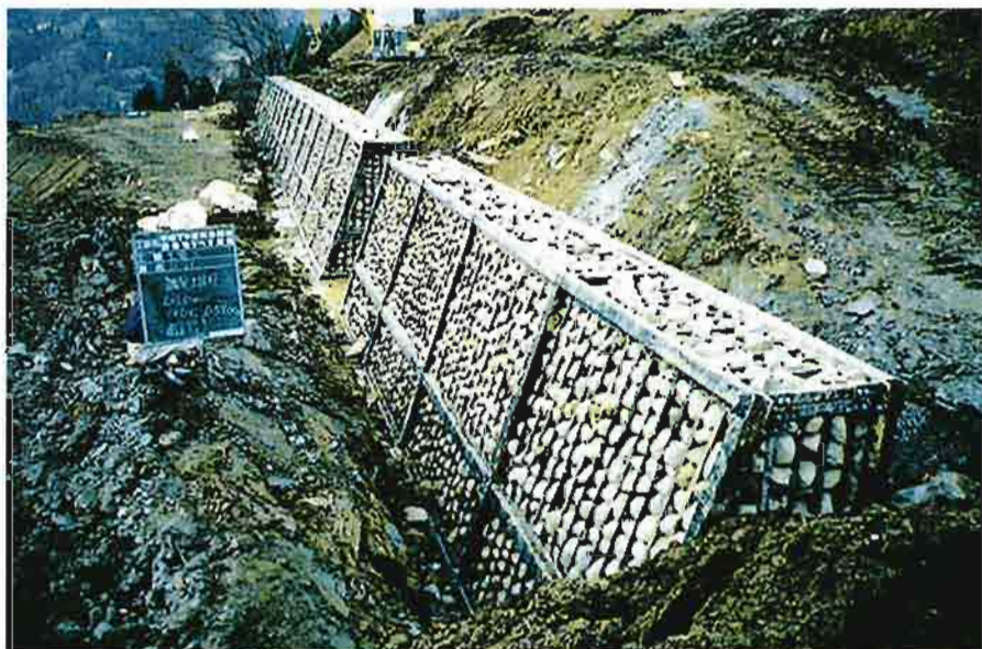
ほぼ完成した土留工
