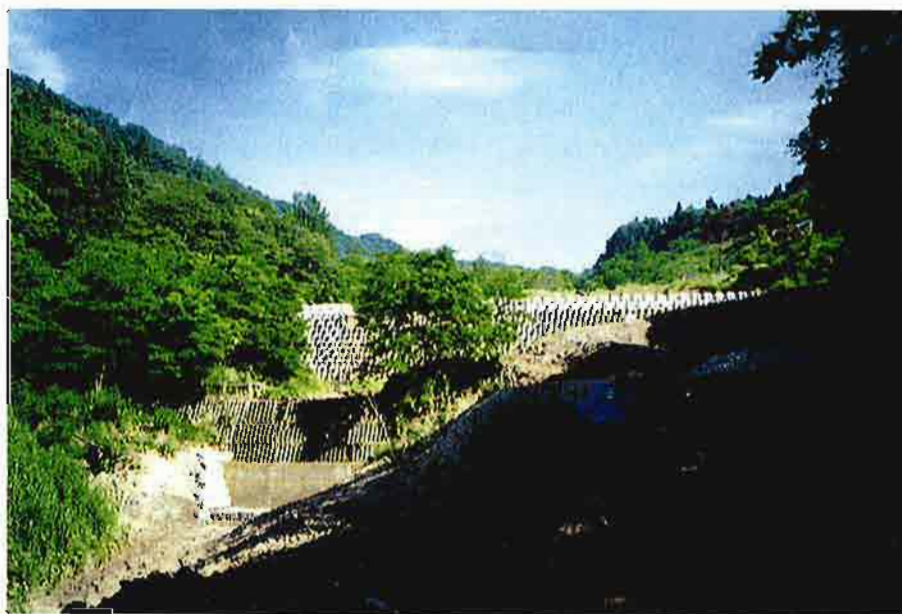
ブロック積砂防ダム
