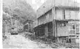
豪雨災害で通行不能となっていた国道148号の入口まで通行可能に。豪雨災害で通行不能となっていた国道148号の入口まで通行可能に。
