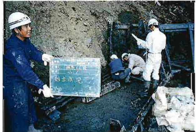
鋼製枠堰堤施工状況
