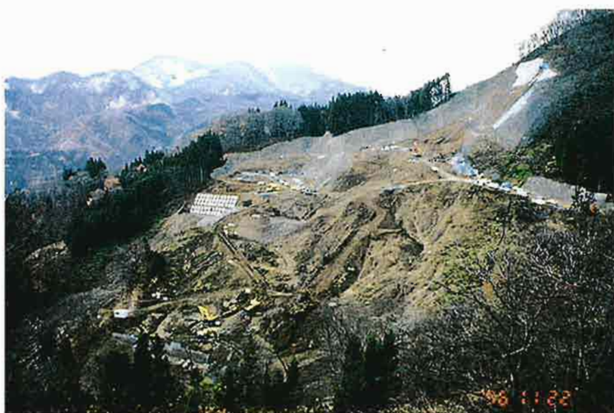
対策工の進む地すべり地内
