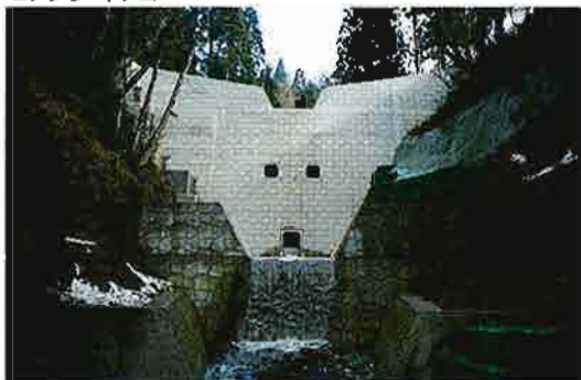
光明沢 小谷村 光明第2工区
