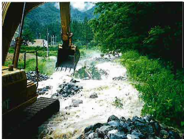
白馬村 佐野 (国道148号線上流) 鳴沢川
