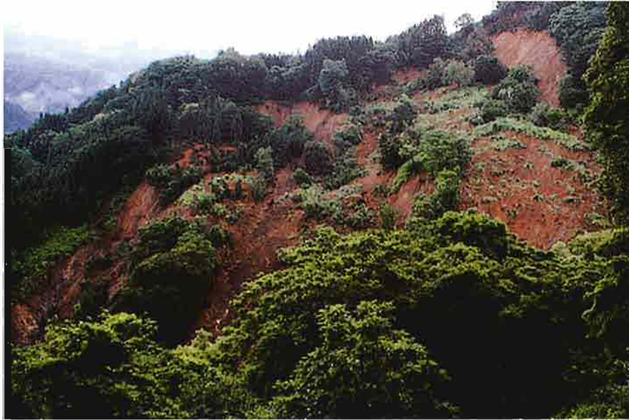
対岸より望む地すべり地内
