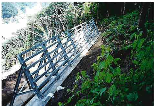
完成した落石防護柵
