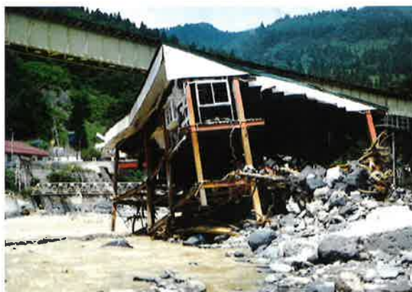
流出して鉄道橋に引っかかった自宅
