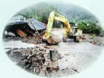
塩沢の土砂除去作業
