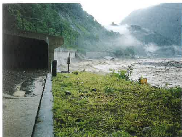
小谷村 北小谷 (下寺洞門被災直前)
