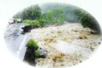
白馬村楠川護岸決壊と県道千国北城線
