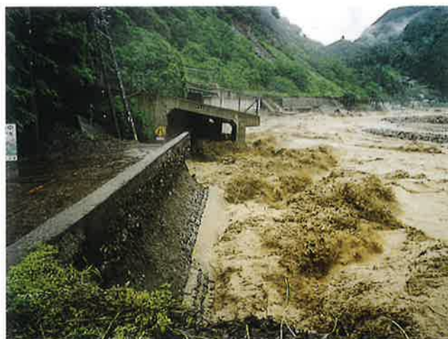
小谷村 北小谷 (下寺洞門被災直後)
