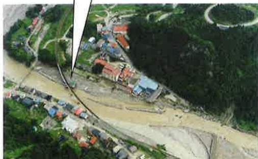
流出した自宅
