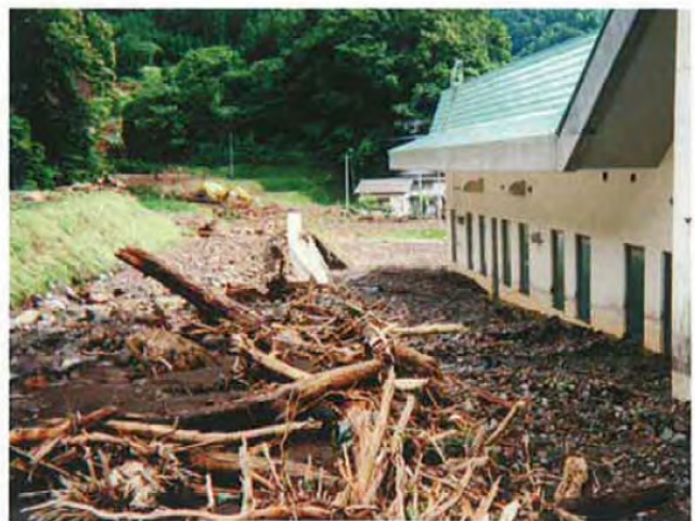
小谷村下里瀬、福祉センター被災
