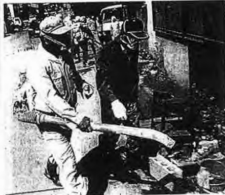
小谷に災害 救助法適用 大糸線は、大糸川沿いにあり、全半壊の家屋は74棟に達している。大糸線は、大糸川沿いにあり、全半壊の家屋は74棟に達している。
