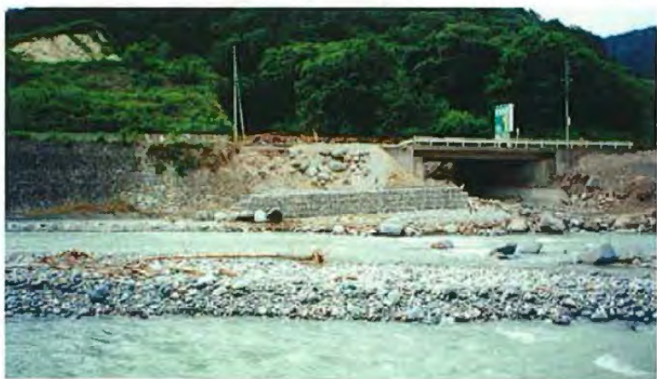
8/3、応急工事が完了(7/14、AM3:00~車両は通行可能となる)
