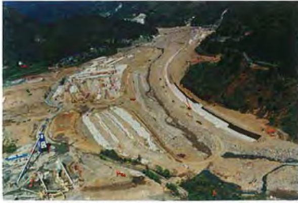
H8.11、巨大なブロック製作ヤードとなった来馬河原と生コンプラント (左下)
