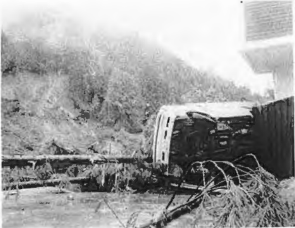
白馬ハイランドホテルの裏山が崩れ建物の一部埋没
