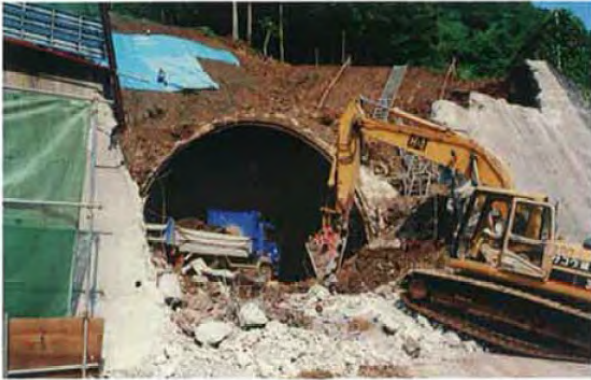
7/13、(国)148号、北小谷への路線確保の為、建設中の平倉トンネルを解放。
