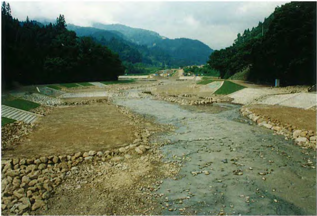
H9.8、多自然型復旧により完成した中谷川。(中土小学校前)
