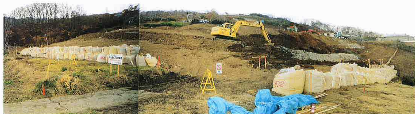
地すべり末端部の対策工事状況（平成12年1月）
