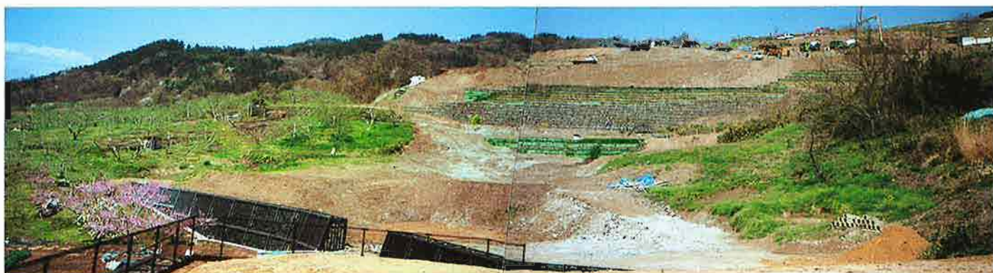
押さえ盛土工概成時（平成12年5月）
