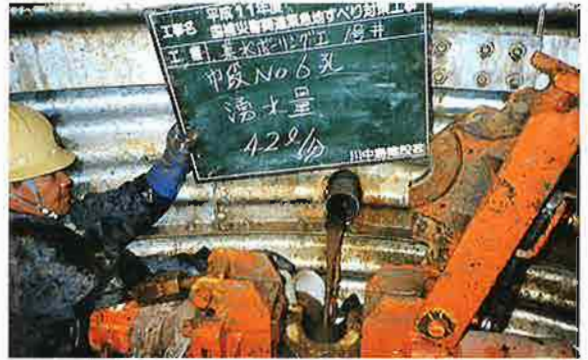
1号集水井と集水ボーリングからの出水状況
