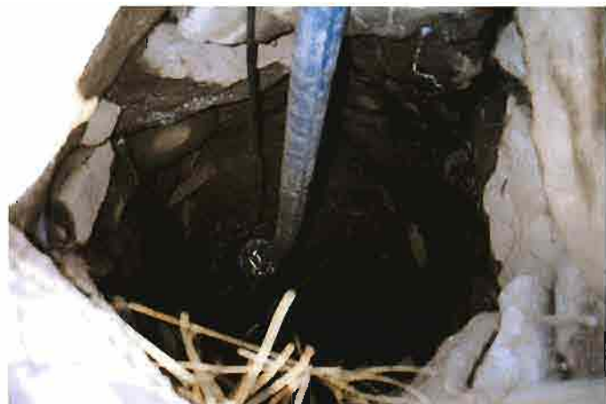
井戸内部（汲み上げ後）
