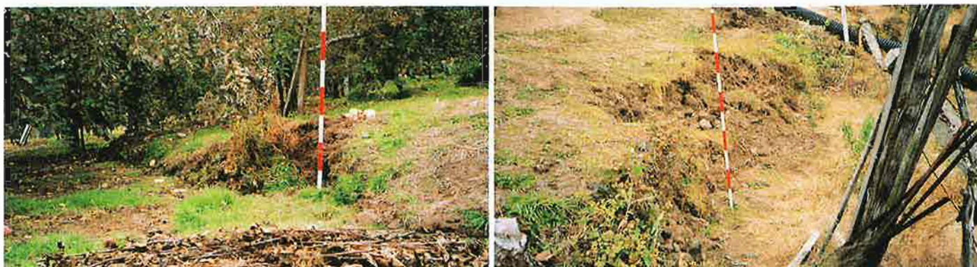
平成11年12月1日の段階で、地すべりブロック末端部に明瞭な土塊の押し出しが生じる。
