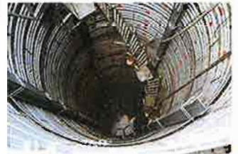
1号集水井と集水ボーリングからの出水状況
