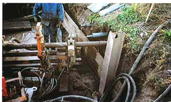
横ボーリング工
