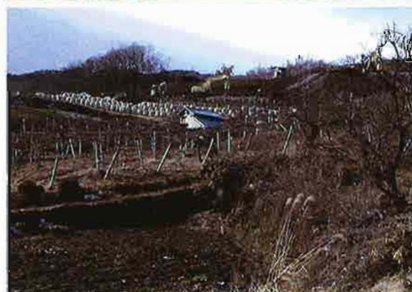
押さえ盛土工施工状況
