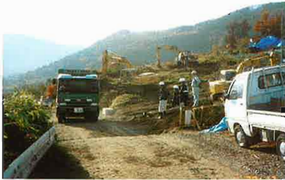
排土工1号車（平成11年12月4日）
