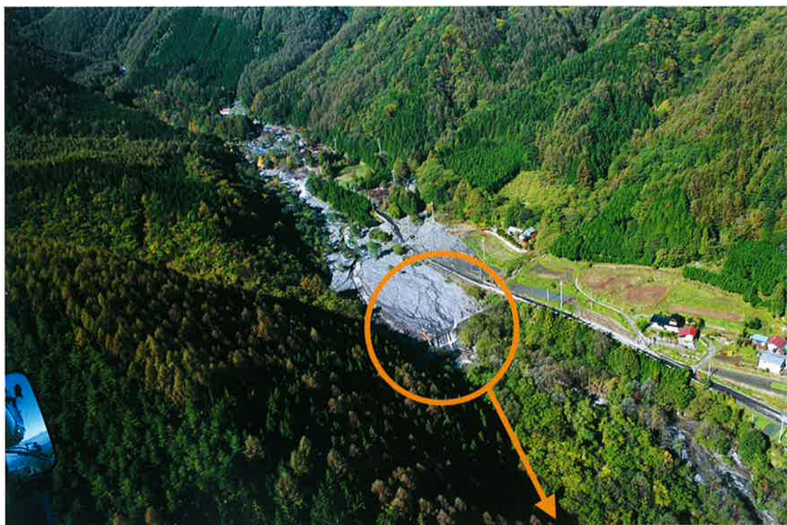
内の萱上砂防えん堤 約5,000m 3 の流出土砂を捕捉
