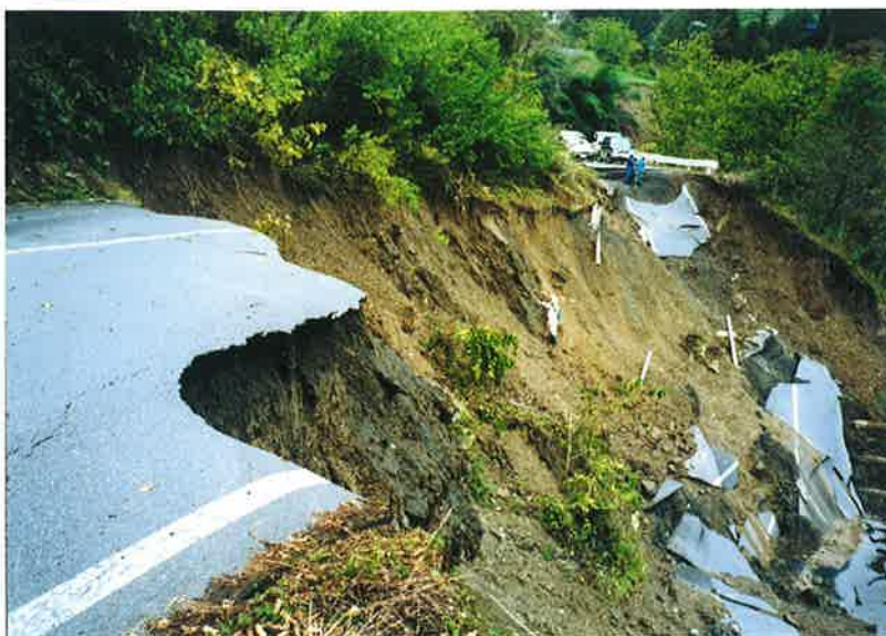
地すべりにより民家軒先が崩壊
