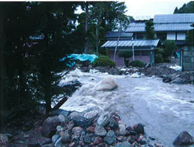
新引沢 土石流が発生し土砂と水があふれている状況
