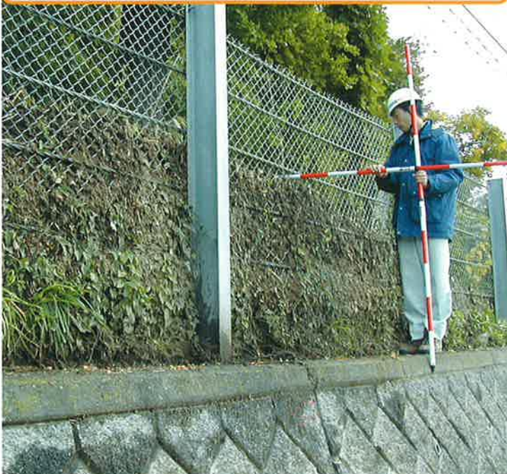
既設擁壁のポケットに堆積した土砂
