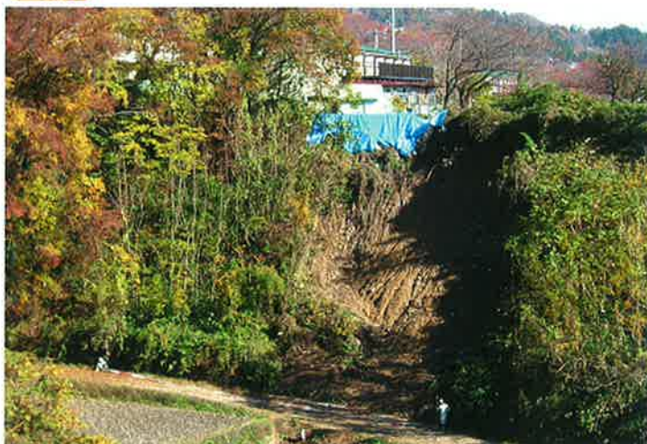
小市団地下 民家の軒先の土砂が崩壊
