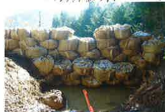
⑦ 大型土のう設置
