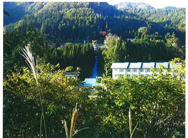
御影堂（全景）保育所の裏が高さ約20mの急傾斜地が崩壊
