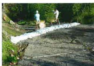
⑧ 土のう設置
