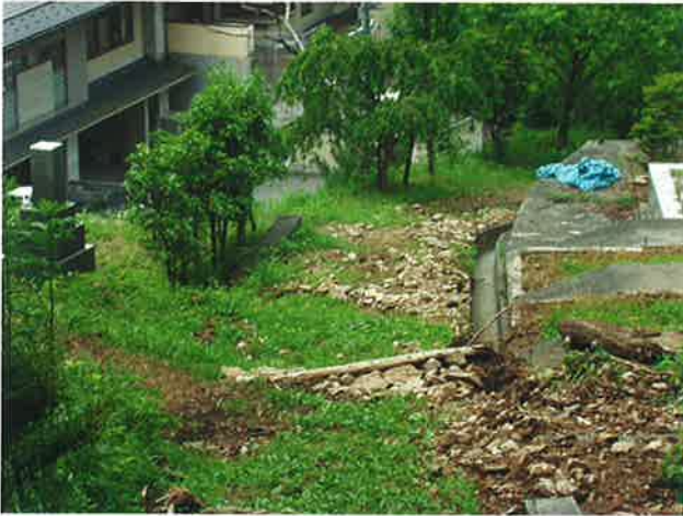
大畑 土砂が流出した状況
