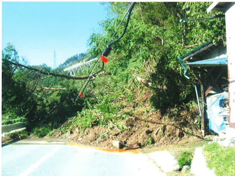
がけ崩れにより民家と県道が被災
