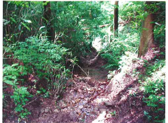
大畑 上部の崩壊状況
