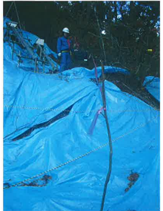
地すべり斜面へのシート張り
