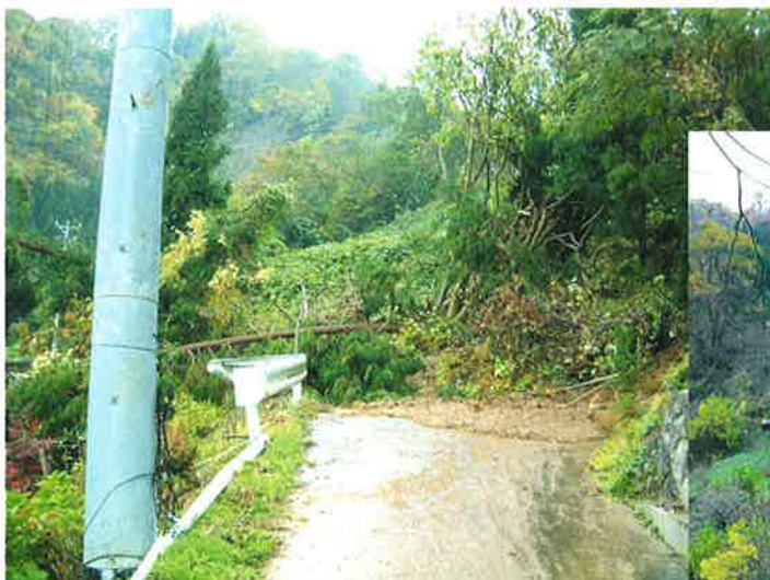
民家横で地すべりが発生
