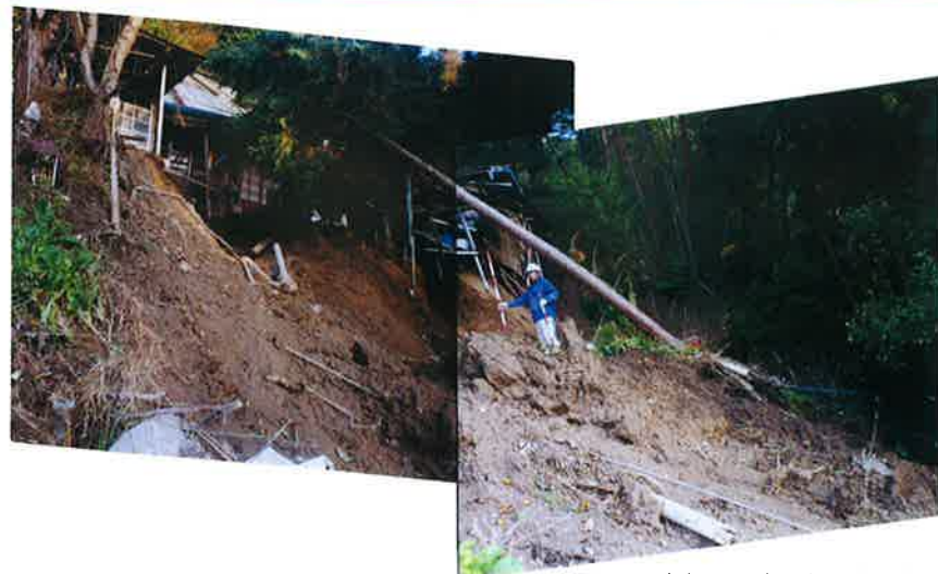
庄部 民家の軒先が崩壊
