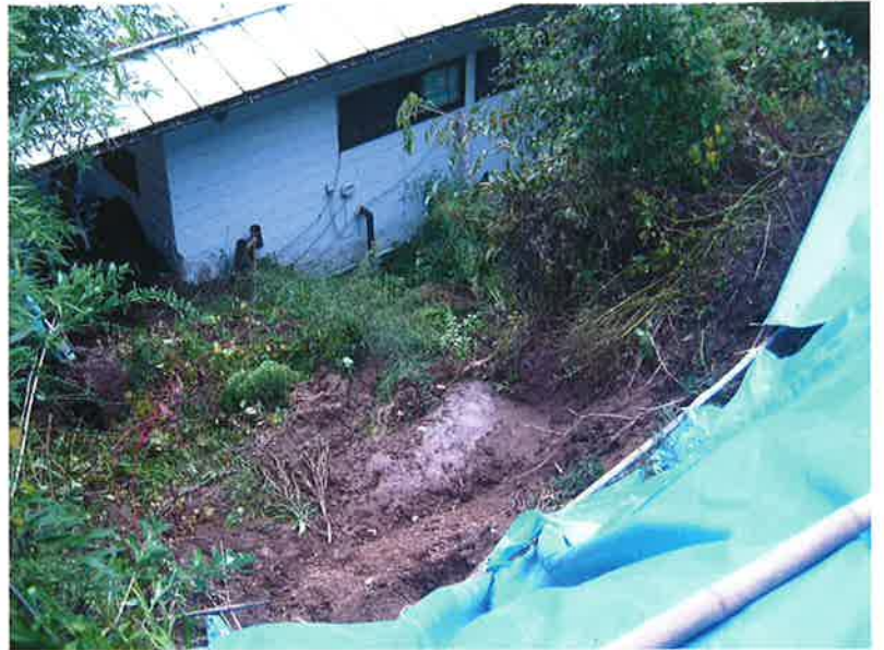
高さ約8mの急斜面が崩壊
