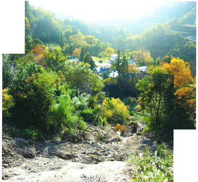
集落近くが地すべりにより崩壊
