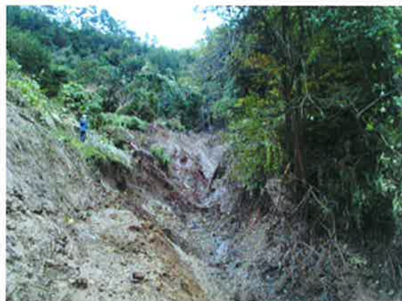
明河沢 土石流の上流部の崩壊状況
