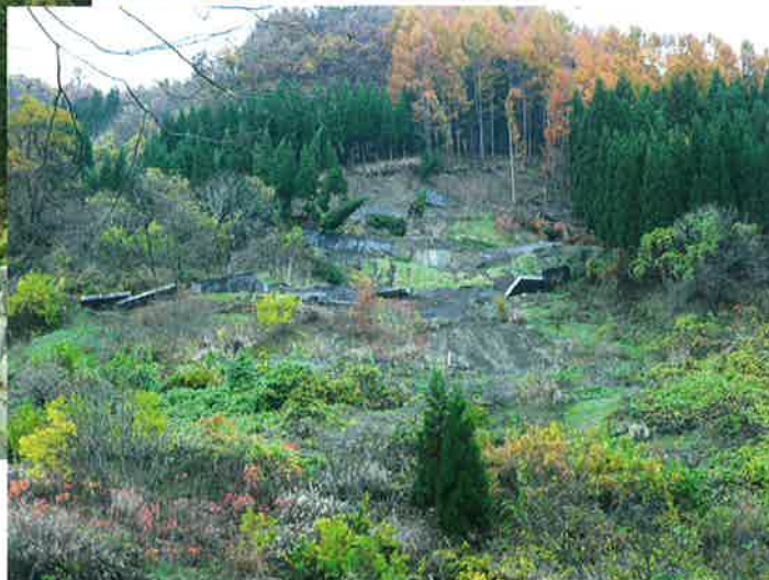
地すべりにより村道が崩壊
