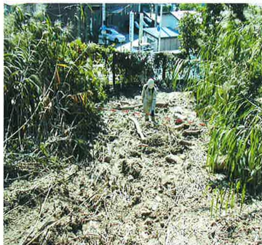
小市西 がけ崩れにより土砂が流出
