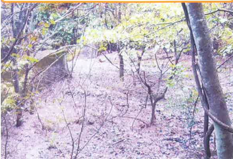
コンクリートえん堤 H=5.0m L=37.6m
