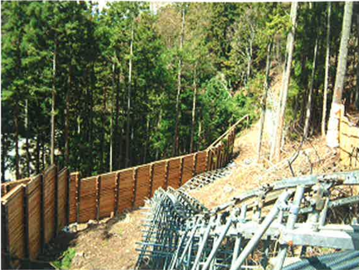
斜面下方に設置した仮設土留工
