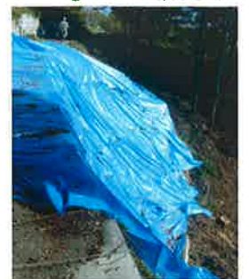
⑥ シート張り状況
