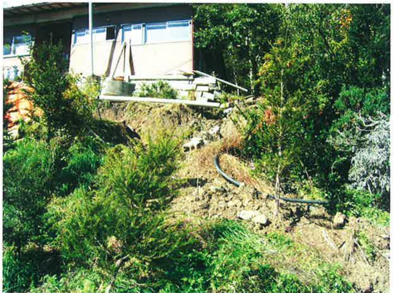
地すべりにより民家軒先が崩壊
