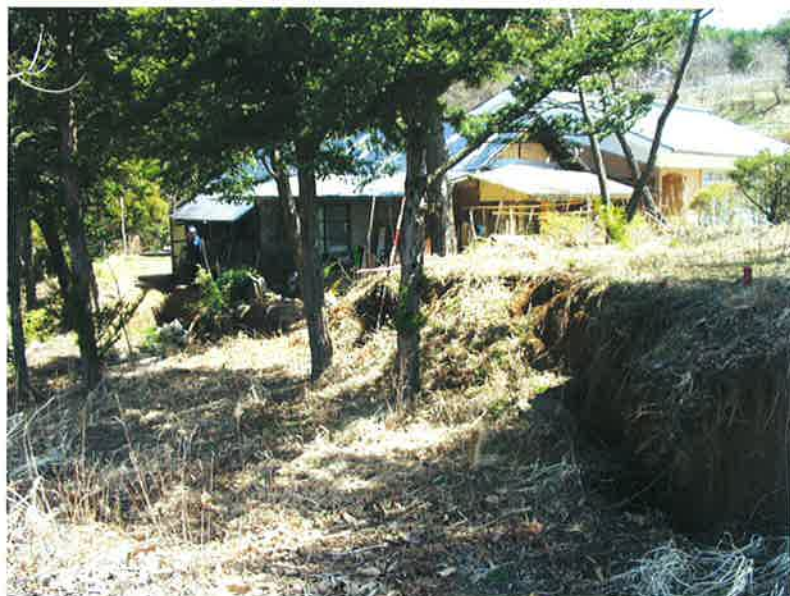
地すべりにより民家近くが崩壊
