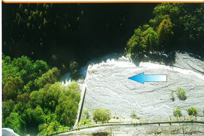
内の萱上砂防えん堤／コンクリートえん堤 H=5.0m L=40.6m
