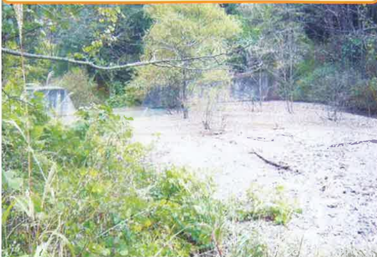
コンクリートえん堤 H=5.0m L=40.6m
