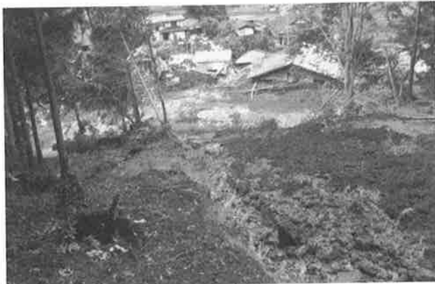
写真-1 土砂災害発生現場
