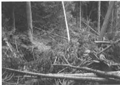
写真-31 地すべり末端部
