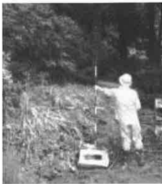
写真-5 小崩壊末端の押し出し
