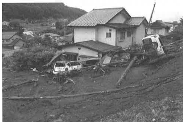
写真-11 被災写真
