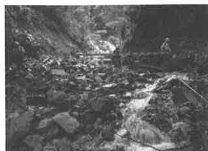
写真-35 溪岸侵食
