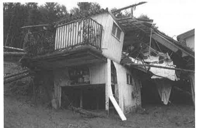
写真-12 被災写真
