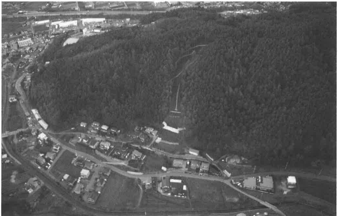
写真-17 赤羽の応急対策工完了
