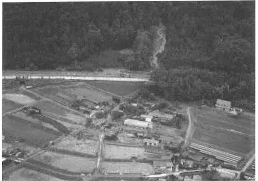
写真-33 土砂の氾濫状況
