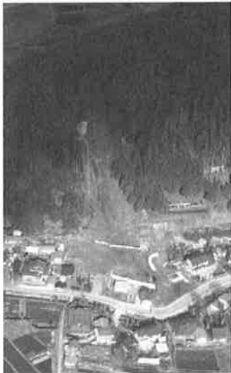
写真-8 応急工事完成
