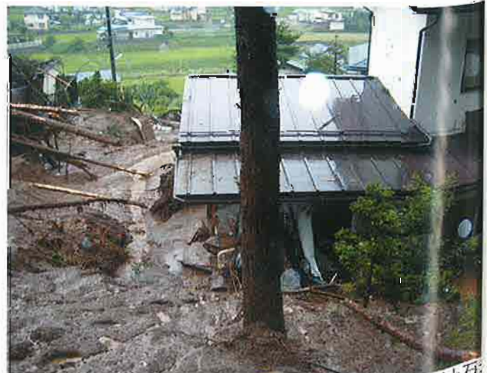
住宅へ流れ込んだ土石
