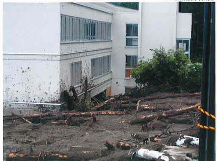
上の原小学校校舎への土砂・流木流入状況
