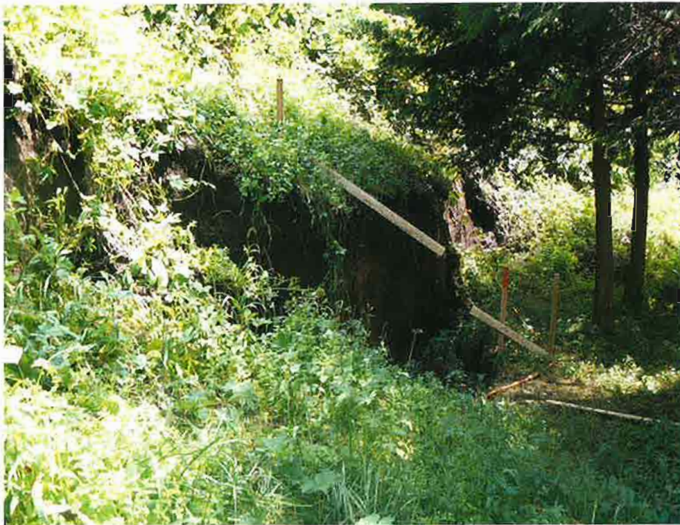
地すべりにより発生した亀裂
