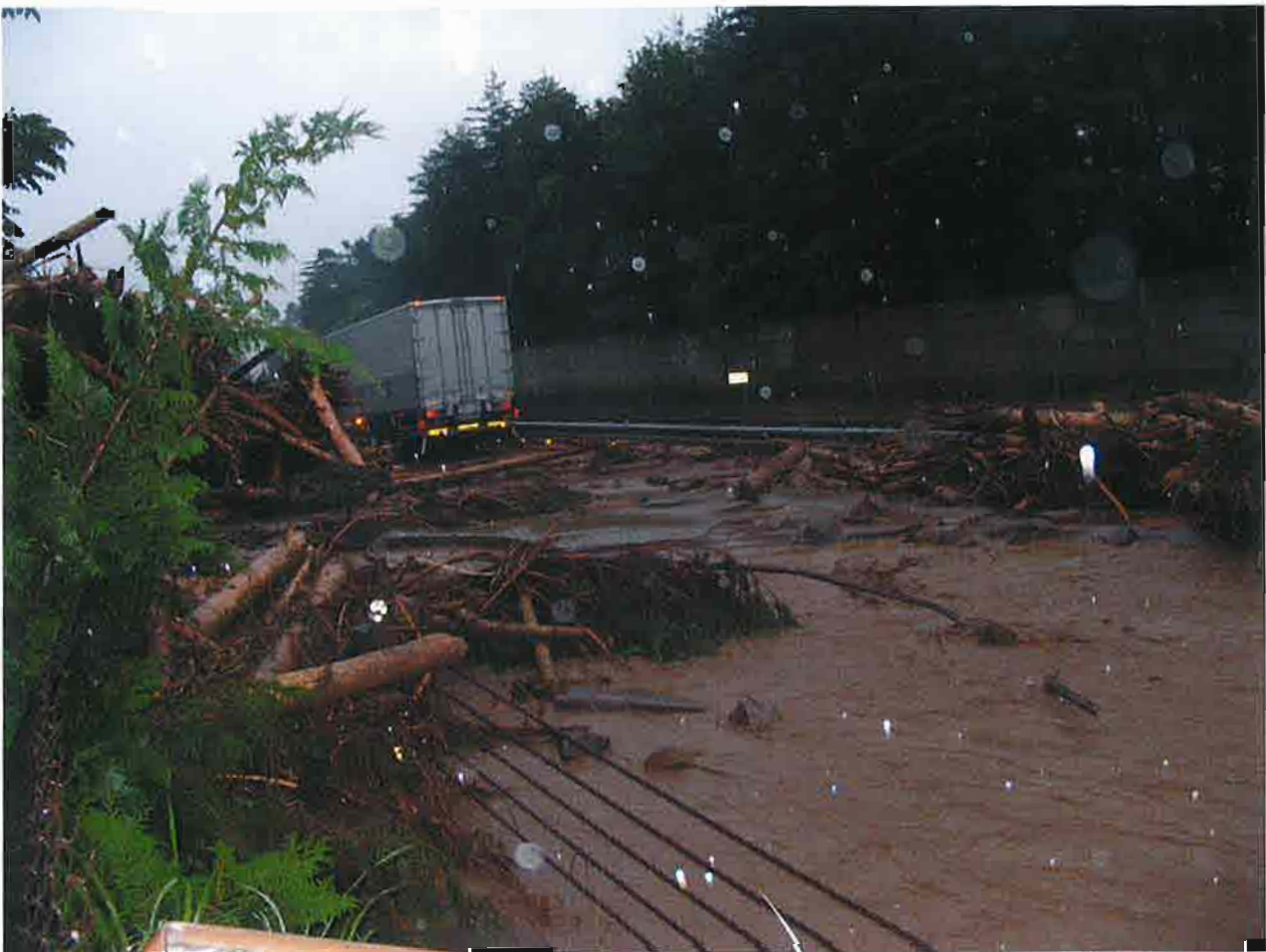
前沢川(西春近)中央自動車道
