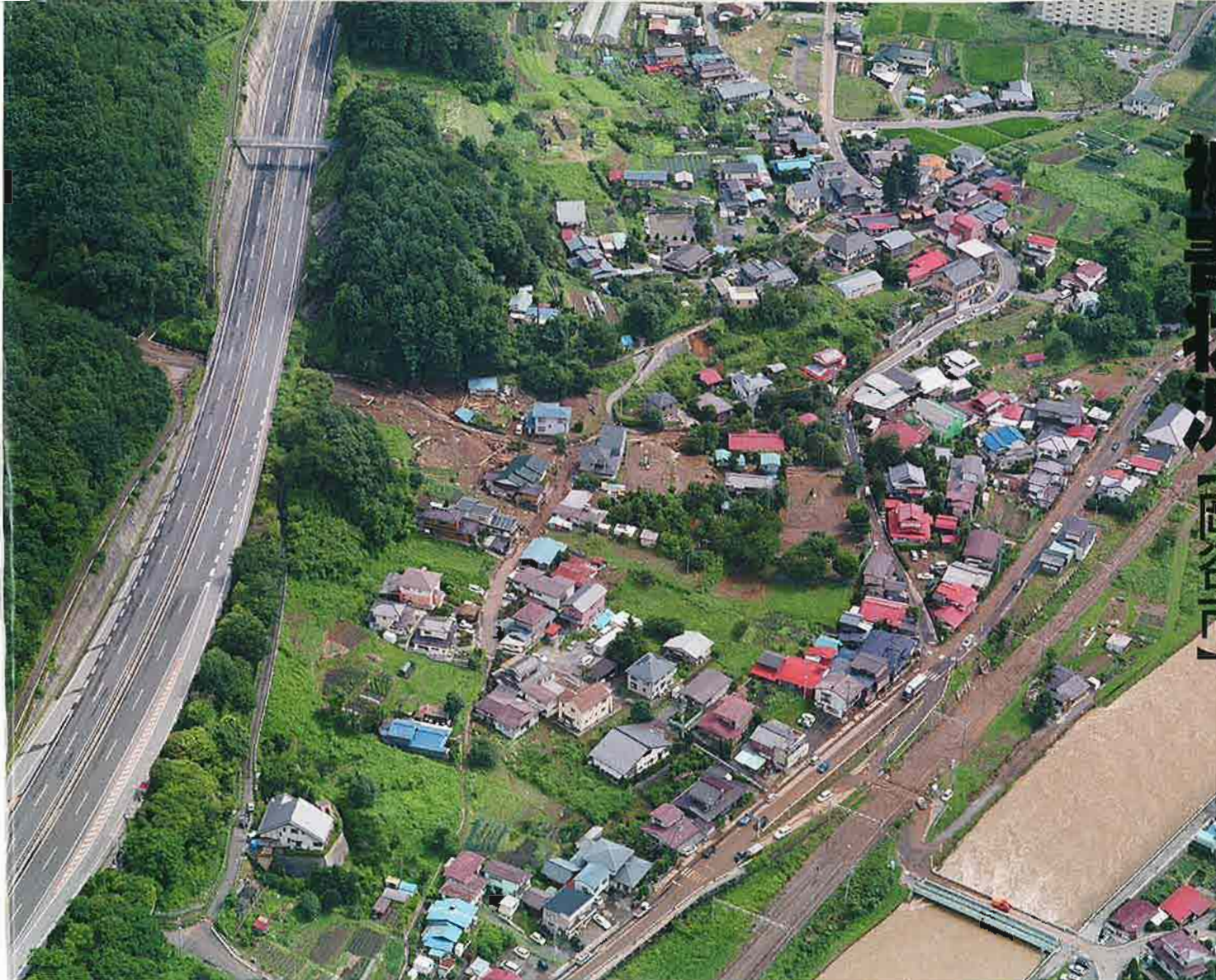
的場川(川岸駒沢) 土石流発生状況
