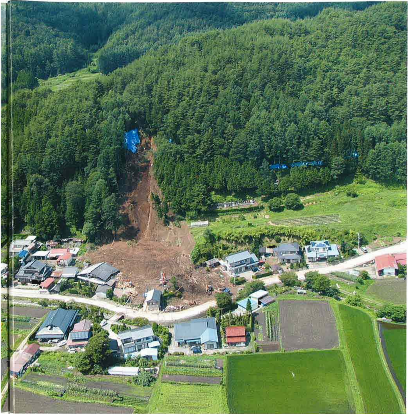
土砂崩れによる被害状況
