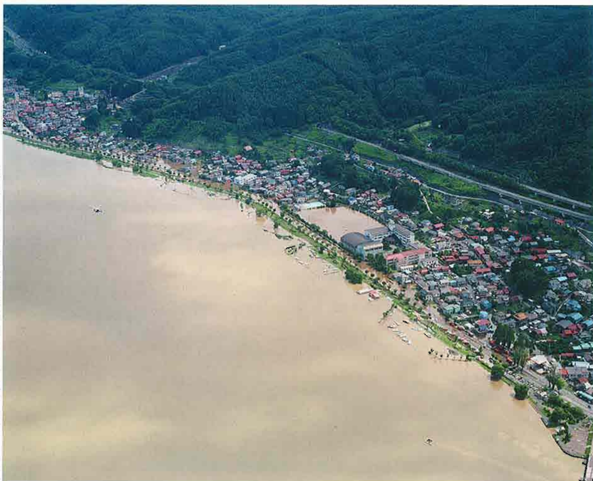
湊地区浸水状況（小田井沢川等からの土石流に伴う浸水）
