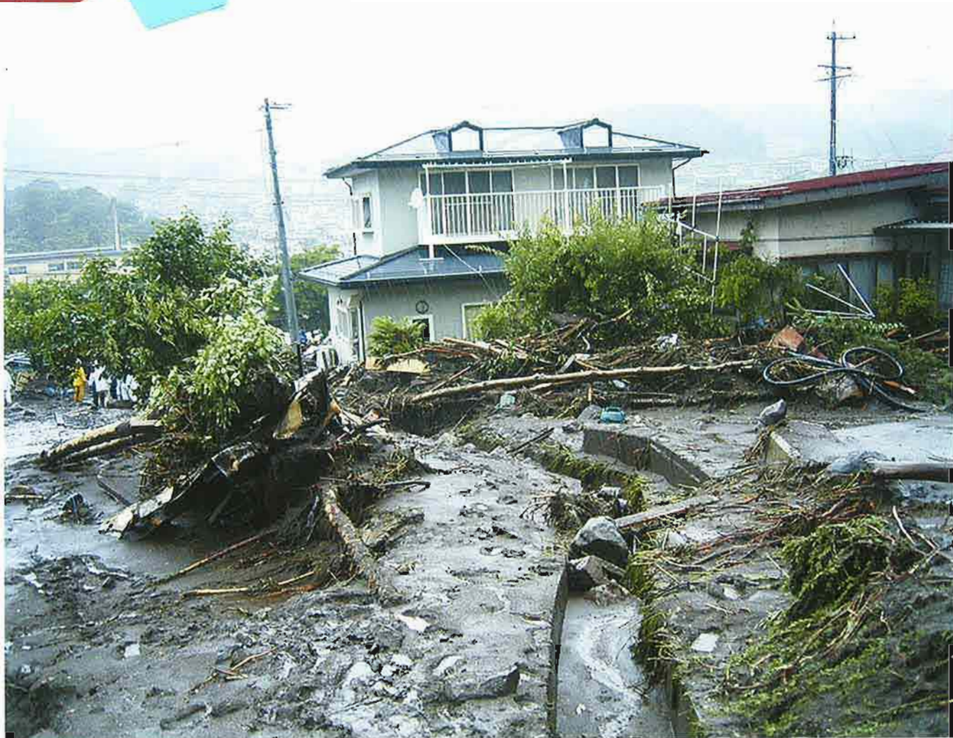
住宅へ押し寄せた土石流
