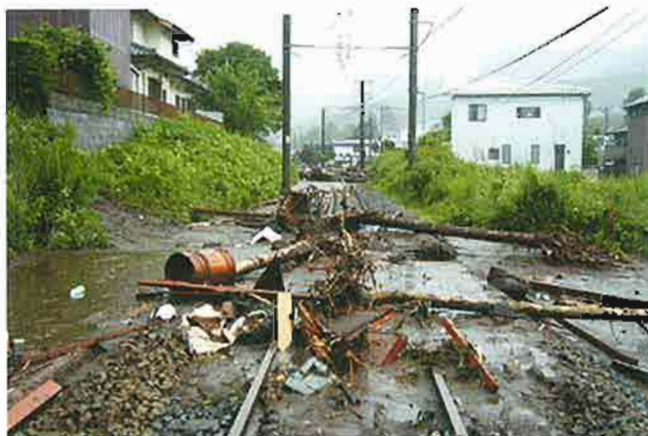
JR中央東線への土砂流出状況
