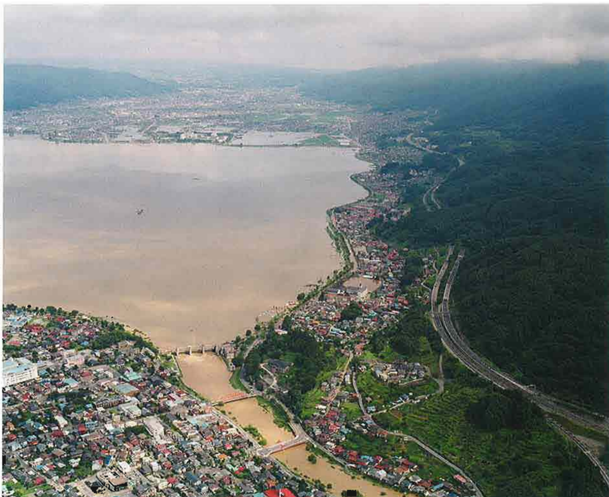
釜口水門上空から諏訪市湖南方面を望む。右手前が湊地区
