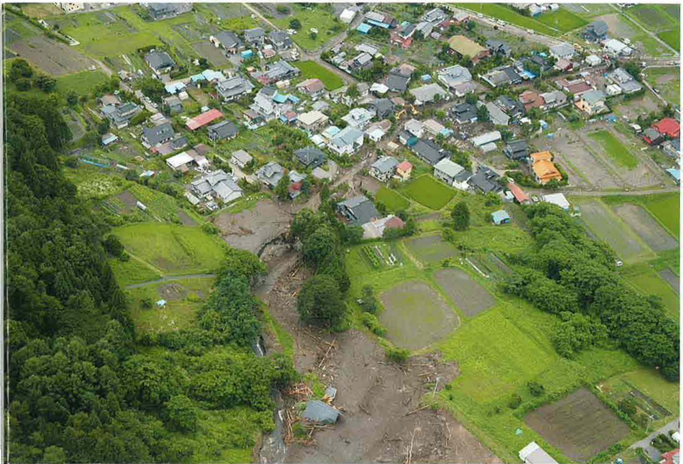
中の沢(中村)土石流発生状況
