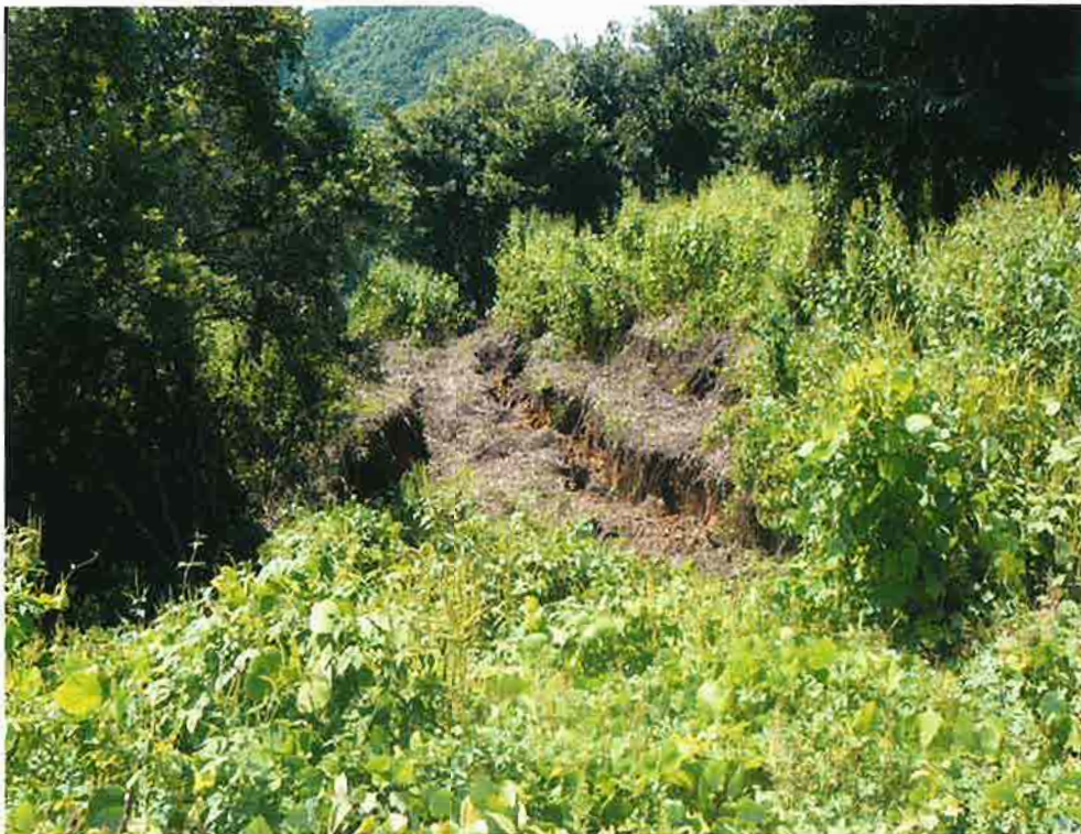
地すべりにより発生した亀裂
