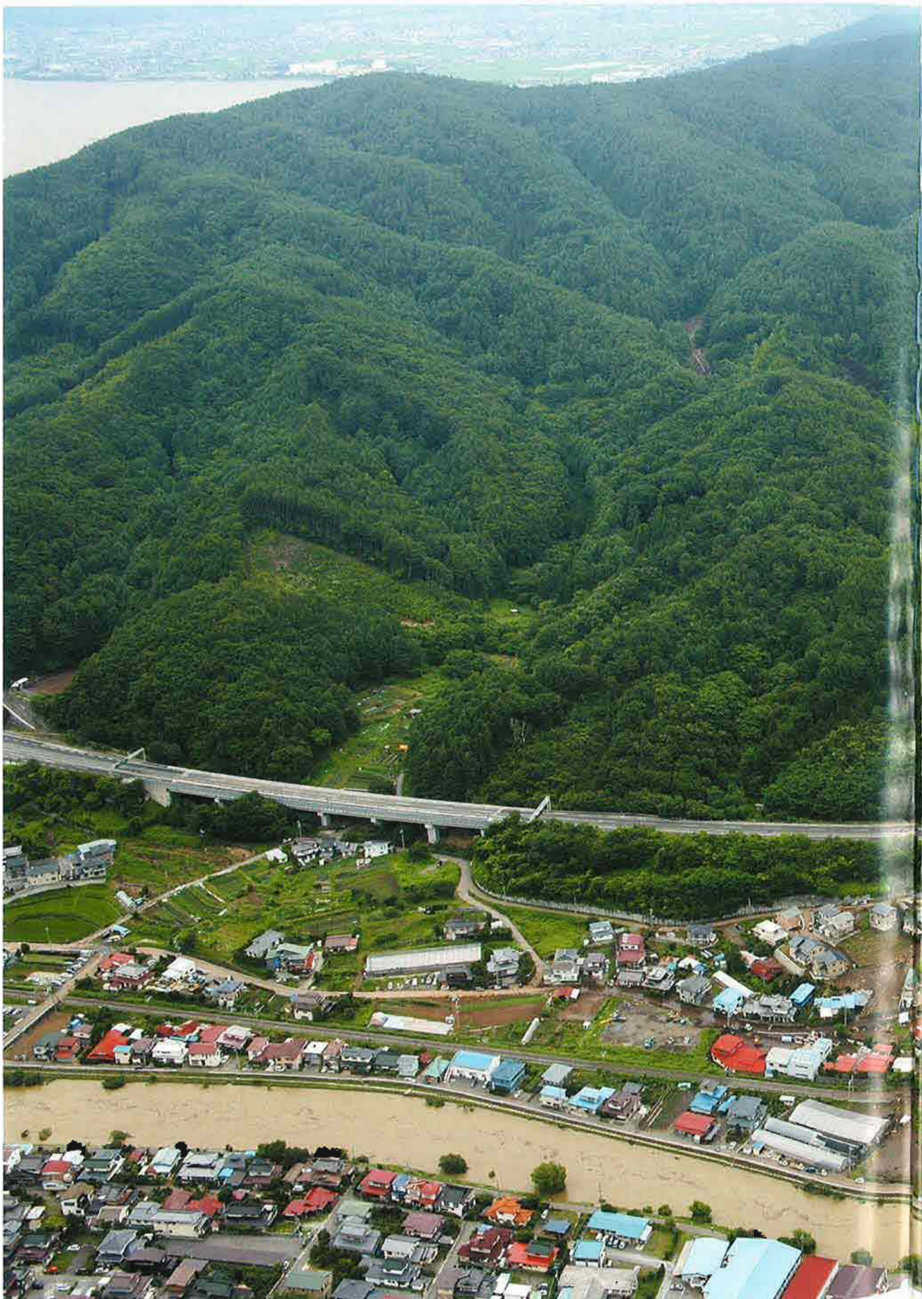
手前は諏訪湖から流下する天竜川。土石流が発生した山裾に中央自動車道、被災集落内をJR中央東線が通過している。
