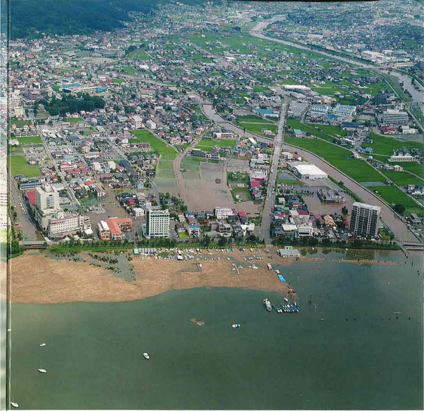
島崎地区浸水状況 (湖に浮かぶのは葦や流木)
