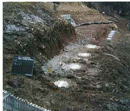
鋼管杭設置
