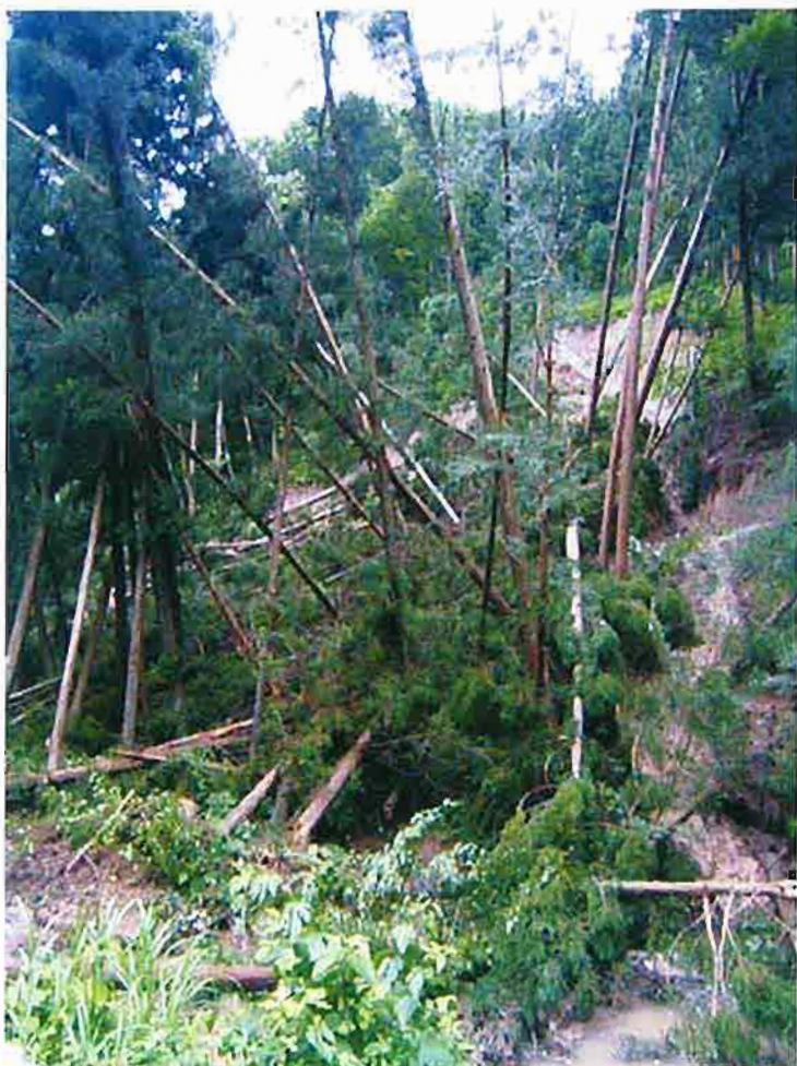
大町市(上箆) 地すべり発生状況
