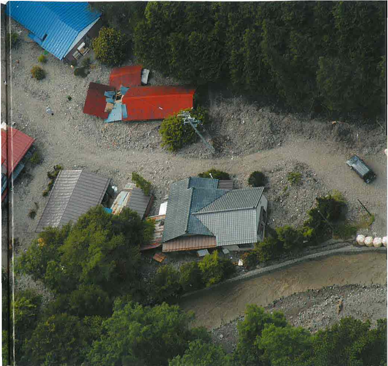
土石流による被害状況
