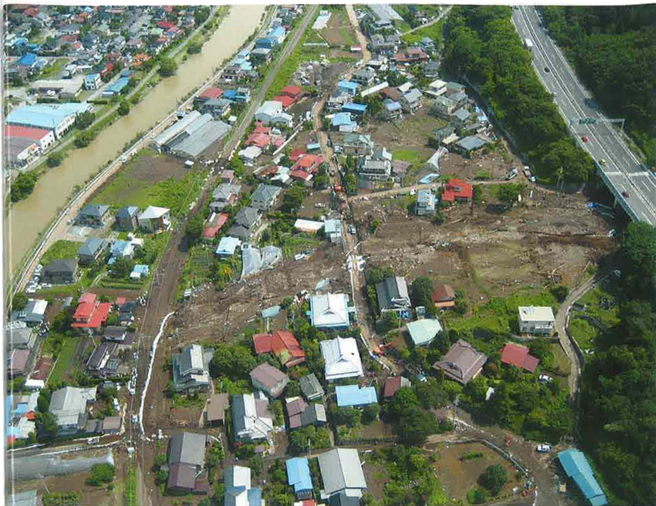
土石流による被害状況
