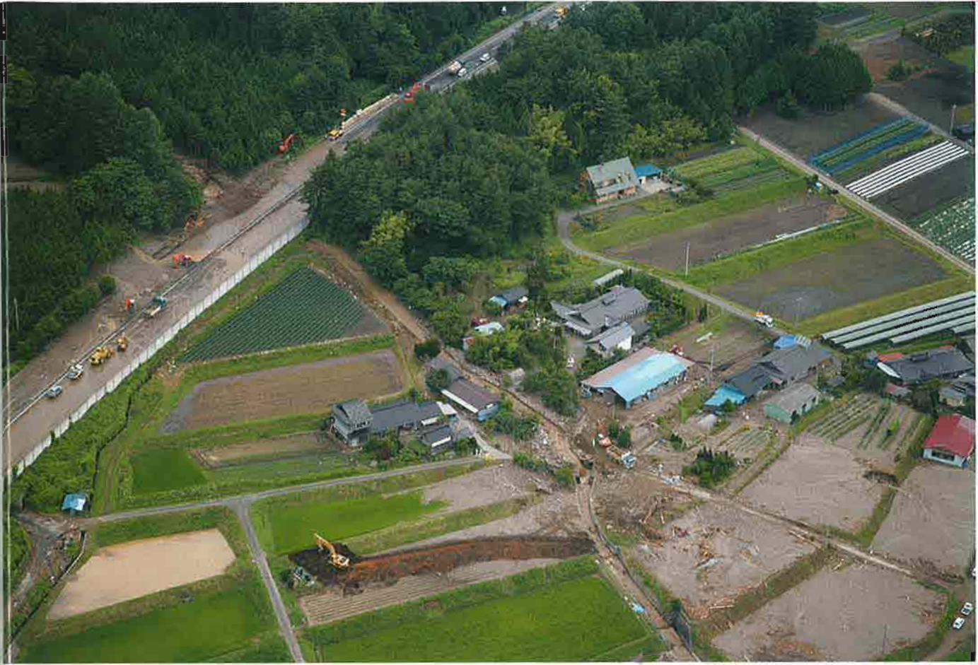
前沢川(西春近)土石流発生状況
