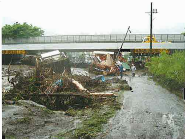
中央自動車道の橋脚に流木が衝突
