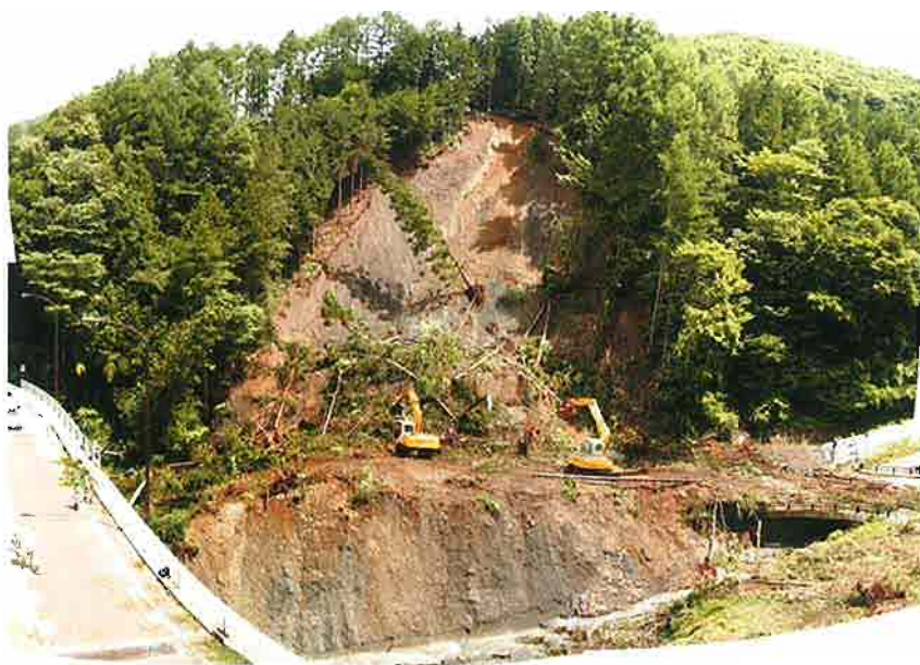
(国)361号 木曾町神谷 (伊那木曾連絡道路)
