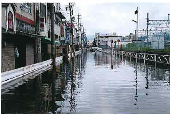
(国)20号 上諏訪駅付近浸水状況
