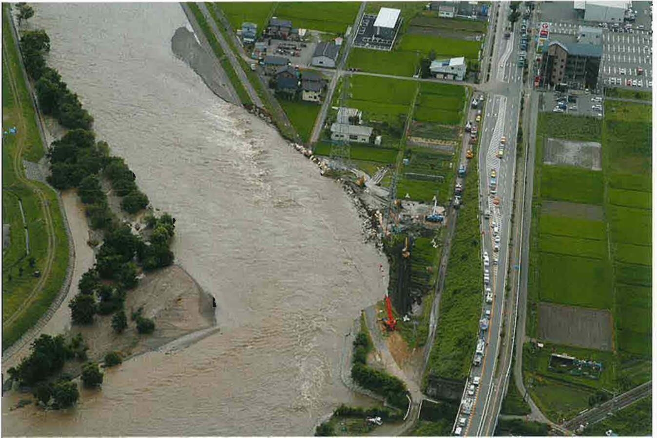
天竜川(松島北島)堤防決壊状況
