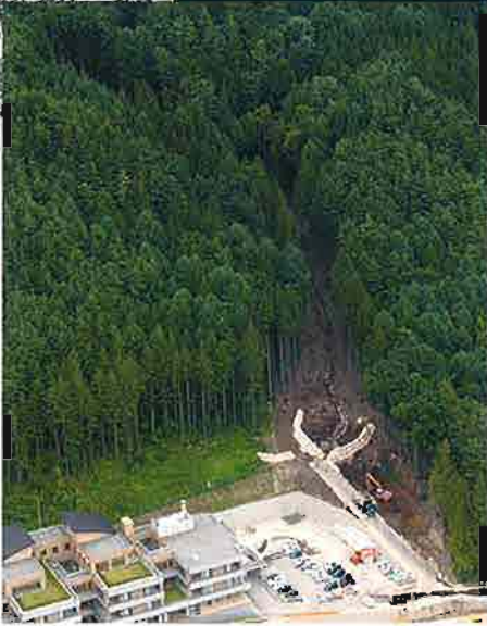
横河川左支川応急工事 施工状況(大型土のう工)
