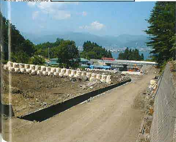
小田井沢川応急工事 施工状況(大型土のう工)
