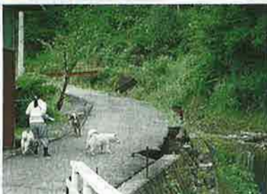
避難先から一時帰宅し、揺岸の崩れた川沿いの道路で犬の散歩＝20日午前10時半、木曾町日鏡
