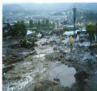
被災状況(D)
