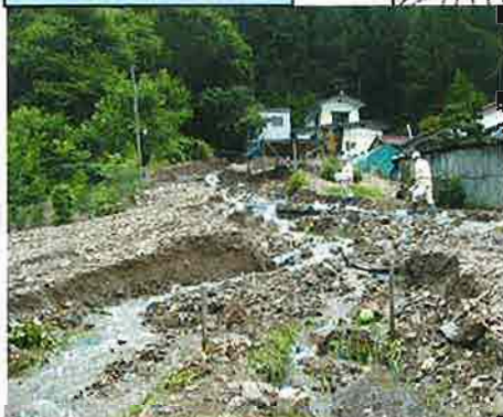
下雨沢 集落内に流出した土砂
