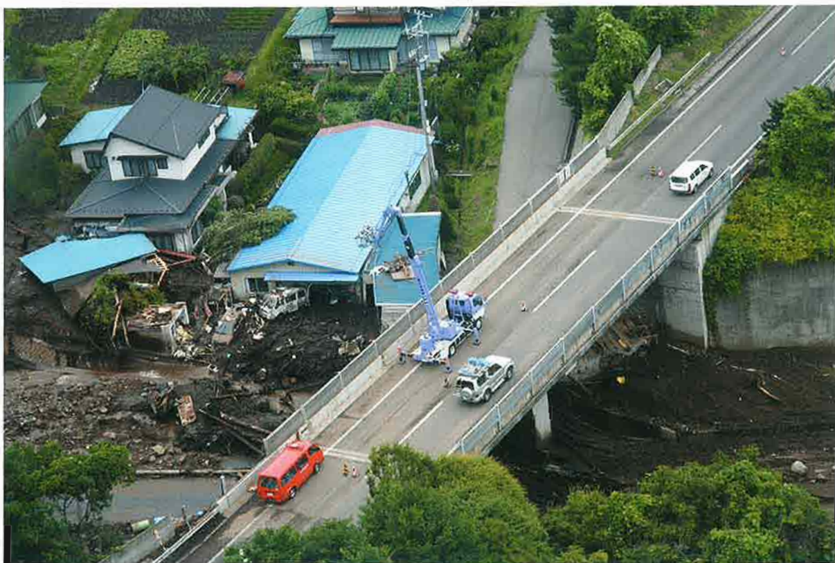
中央自動車道上に配備された照明車(岡谷市湊3丁目)
