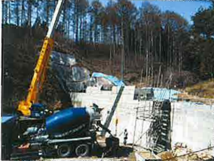
待張川砂防えん堤施工状況
