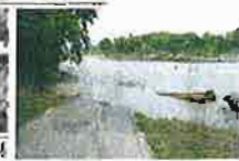
三輪川沿いにサイクリングロードが一部流失。伊那市三輪川沿い。
