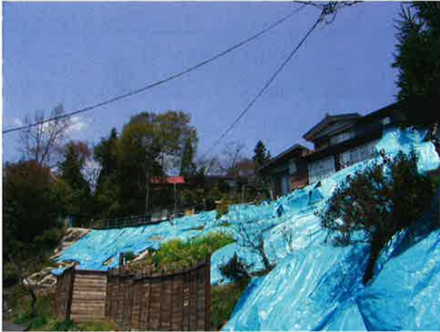
人家前の斜面が崩壊
