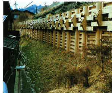
対策後の上島地区
