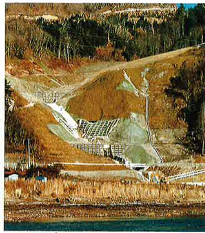
対策後の滝越地区
