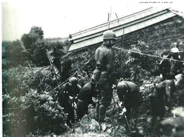
地すべりにより倒壊した家屋。
