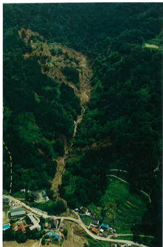
小谷村 じょう 城地すべり (県道、河川に土砂流出)
