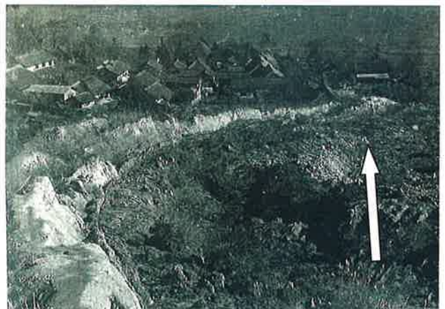
山新田集落へ押し出す地すべり土塊 (昭和23年)
