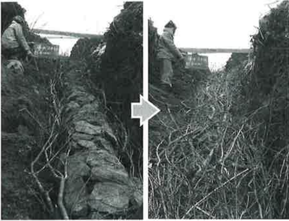
粗朶の巻かれた蛇籠暗渠工 (S39 慶師砂防 旧大岡村) 同箇所での施工状況 (蛇籠の周りに粗朶を巻く前と後)
