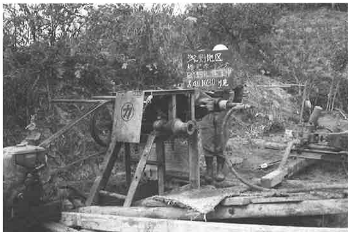
横ボーリング施工状況 (S38 浅野 長野市)
