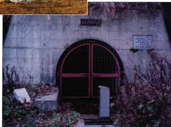
完成した排水トンネル
