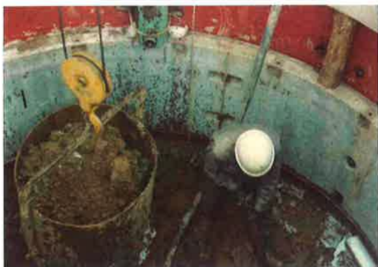
RCセグメント集水井 掘削工 (S57 茶臼山 長野市)
