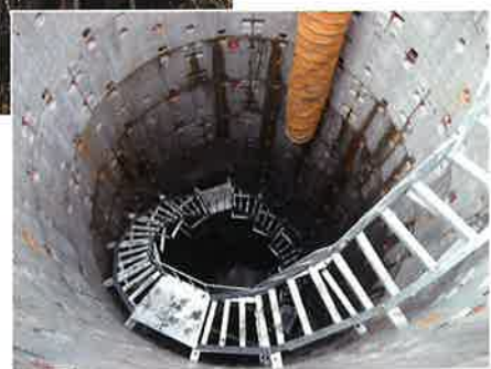
完成した集水井
