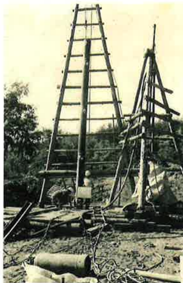
鋼管杭打ち（S46 茶臼山 長野市）
