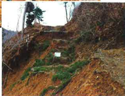
被災した町道
