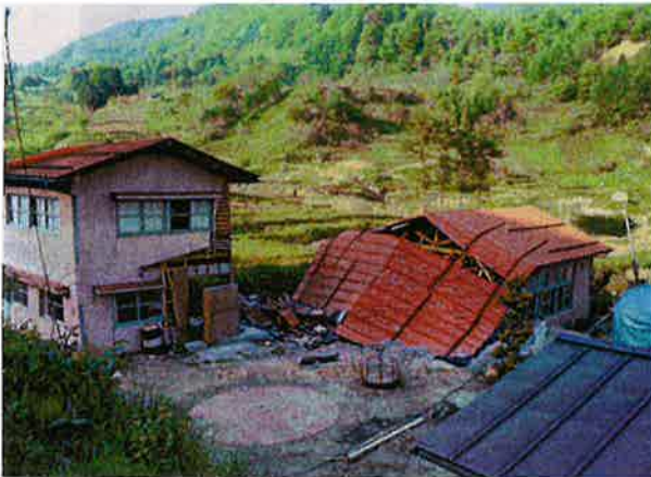
破壊された稲丘東区農業振興センター
