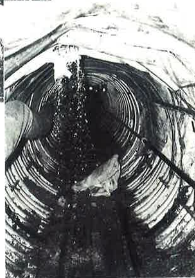
施工中の1号排水トンネル工 （昭和50年頃）
