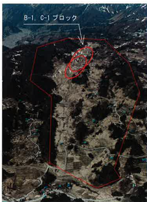
地すべり地全景
