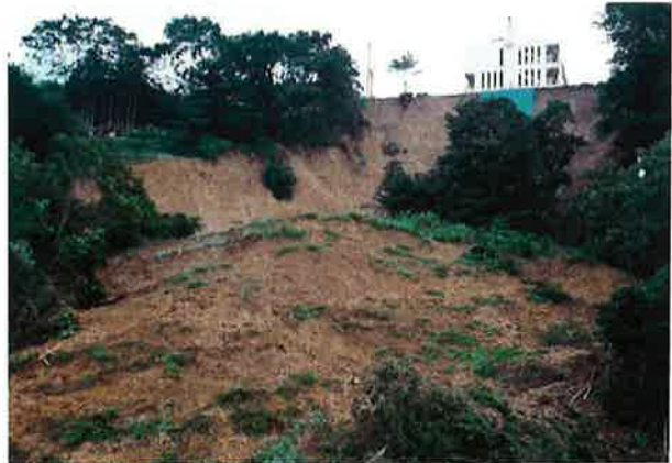
滑落崖の状況
