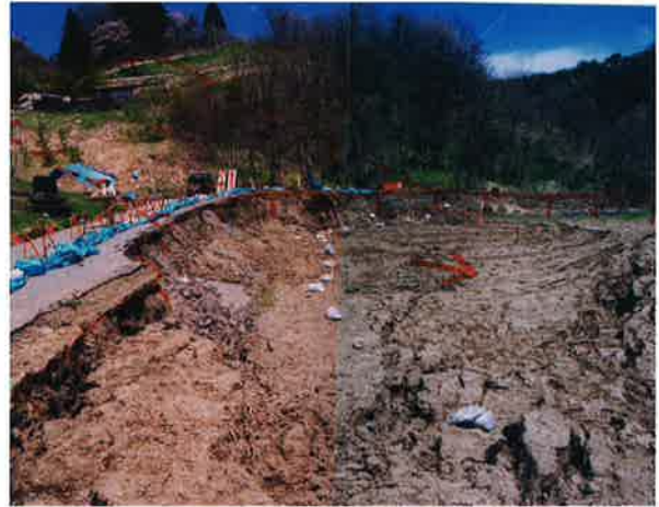
地すべりにより村道が被災
