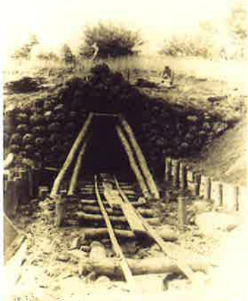
排水トンネル施工状況 (S25 茶臼山 長野市)
