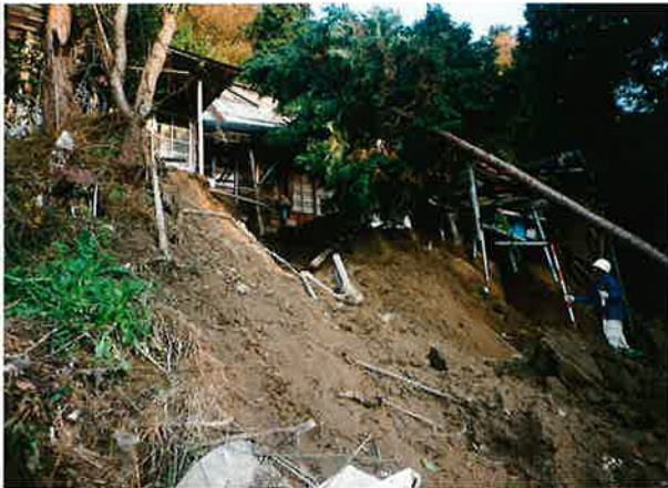
台風 23 号により人家前の斜面が崩壊
