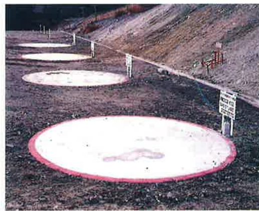
シャフト工（S60 地附山 長野市）
