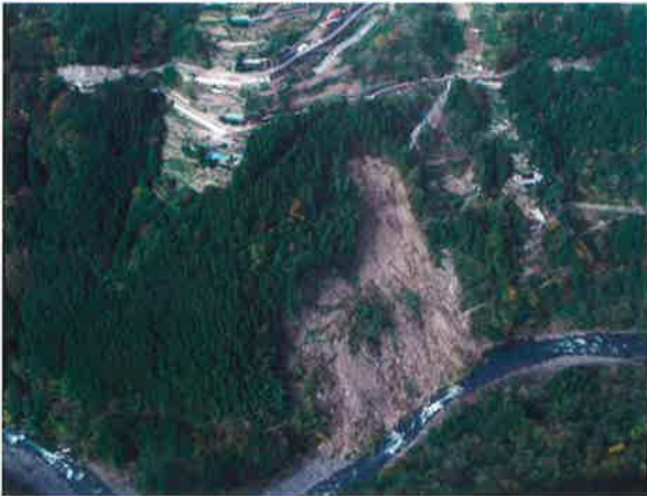
崩壊性の地すべり
