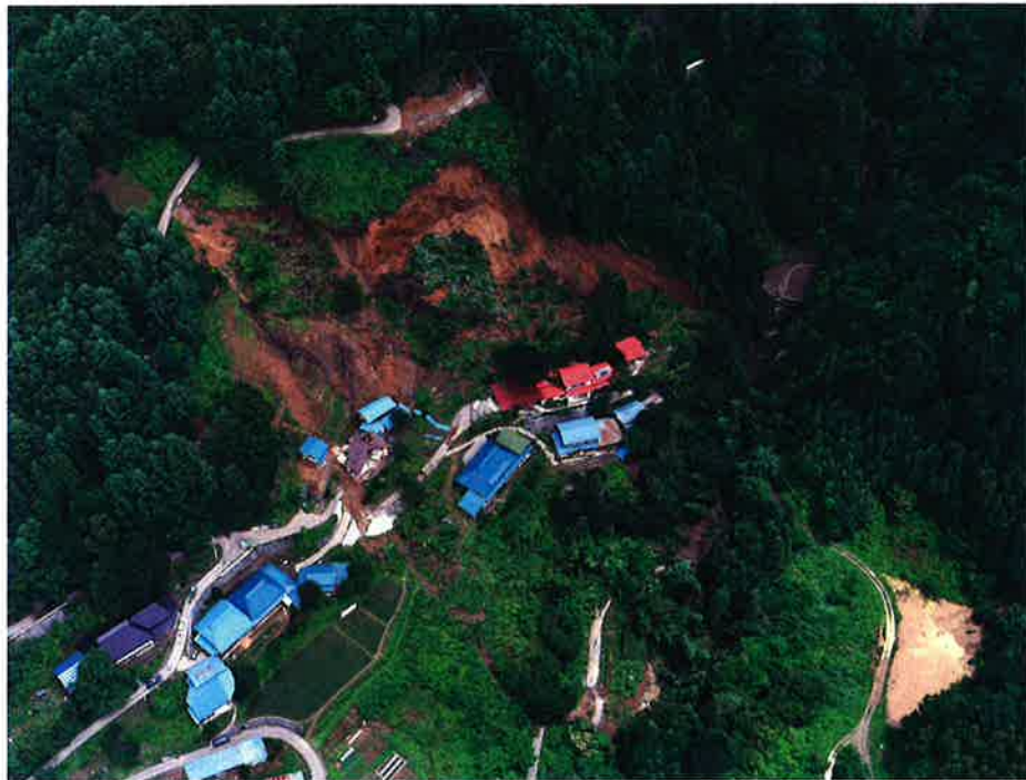
小川村 中牧地すべり (家屋に被害発生)
