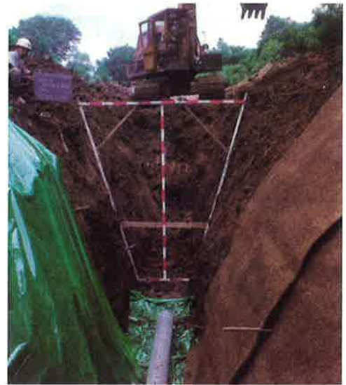
遮水工：写真左がビニールシート、右はフィルター材、左からの地下水を遮断する（年代不明 清水山 小谷村）
