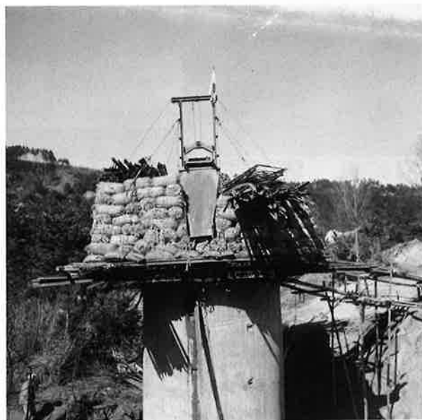
荷重による沈下
