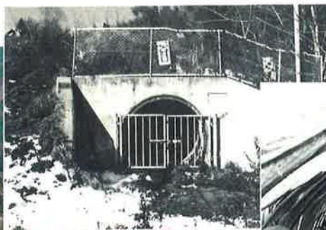
1号排水トンネル工
