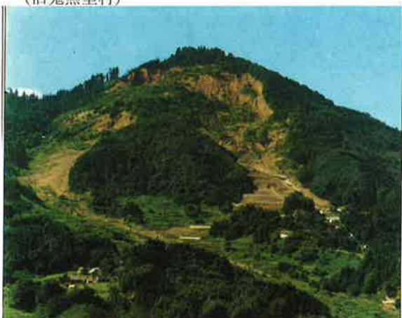
山頂付近で大崩落発生
