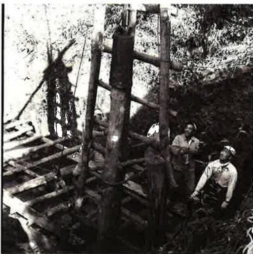
丸太杭打ち（S38 浅野 長野市）
