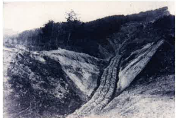
蛇籠水路工施工状況
