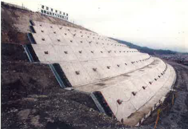
アンカー工 (S60 地附山 長野市)
