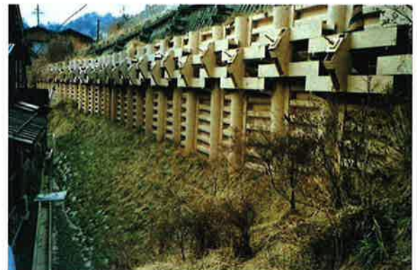
アンカー付杭工 (S59 上島 王滝村)
