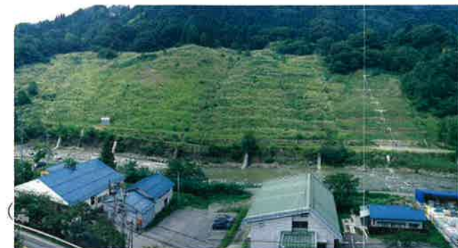
復旧状況 (H5年)
