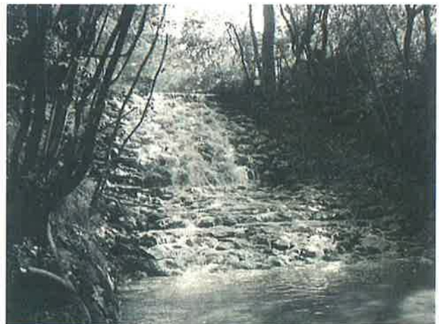
明治時代に施工された石張えん堤（山布施沢 長野市）
