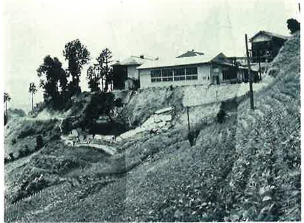
地すべりにより危機に瀕した小学校
