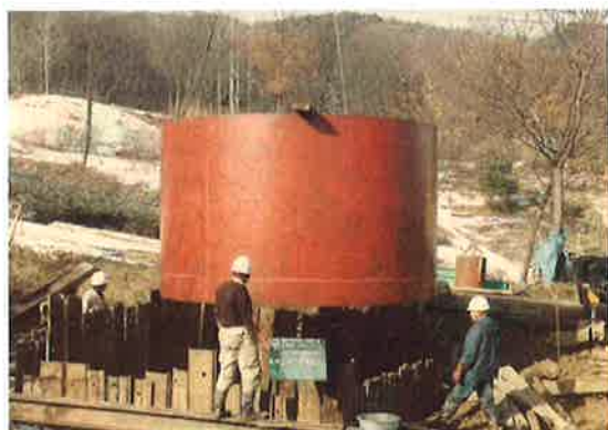
RCセグメント集水井 沓据付工 (S57 茶臼山 長野市)
