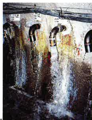
排水トンネル 工内の排水 状況
