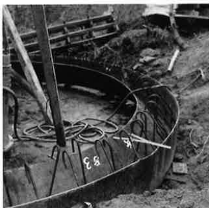
沓の据え付け
