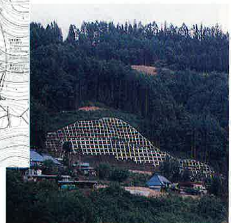
完成後の状況
