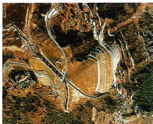
対策後の松越地区
