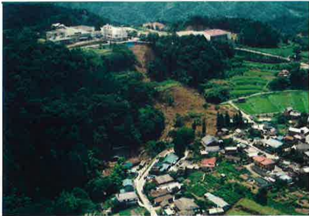
斜面下の水田、町道、橋梁等が被災
