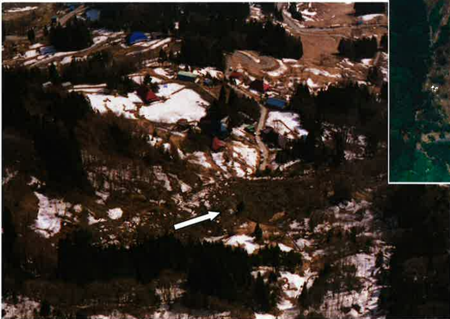
平成6年 地すべり発生状況
