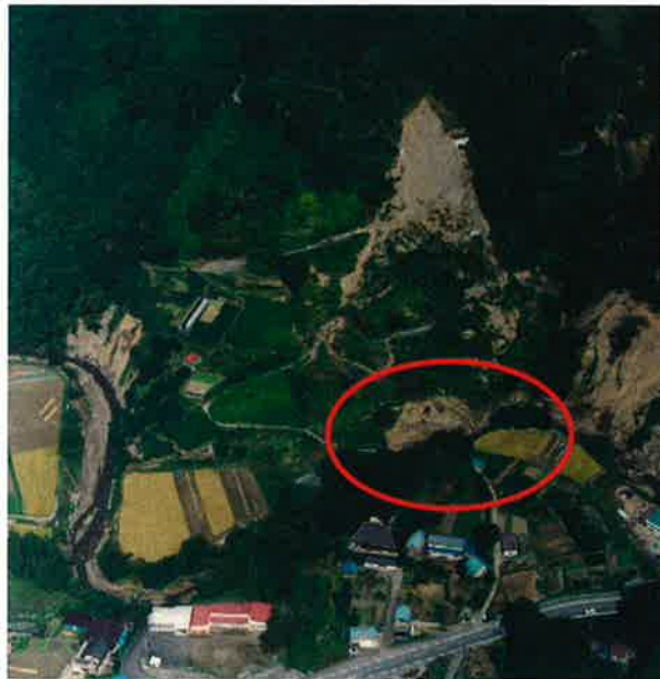
小川村 ふるやま 吉山地すべり (○印が地すべりにより土尻川に土砂が流出した箇所)
