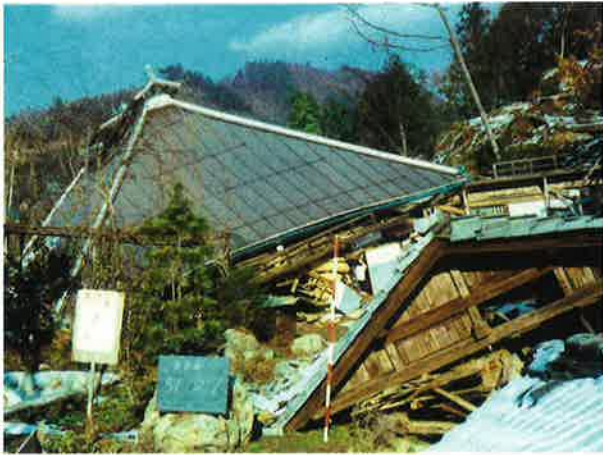
地すべりにより倒壊した家屋
