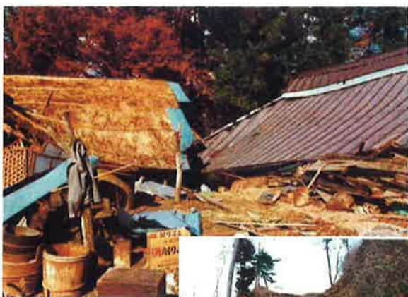
倒壊した家屋
