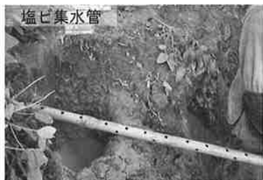
横ボーリング施工状況 (S38 浅野 長野市)
