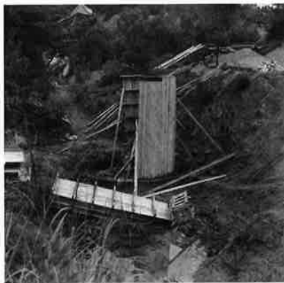
筒内型枠設置
