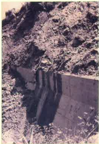
埋没した岡田えん堤 (昭和25年6月)
