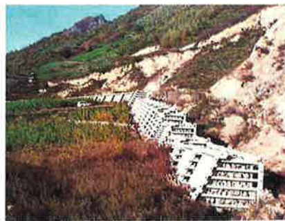
滑落崖に施工された井桁ブロック
