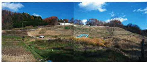
完成した押え盛土
