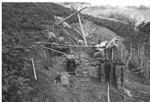
横ボーリング施工状況 (S39 追平 中条村)
