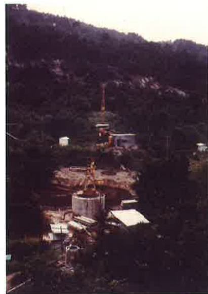
ニューマチックケーソン施工状況 (S44 茶臼山 長野市)
