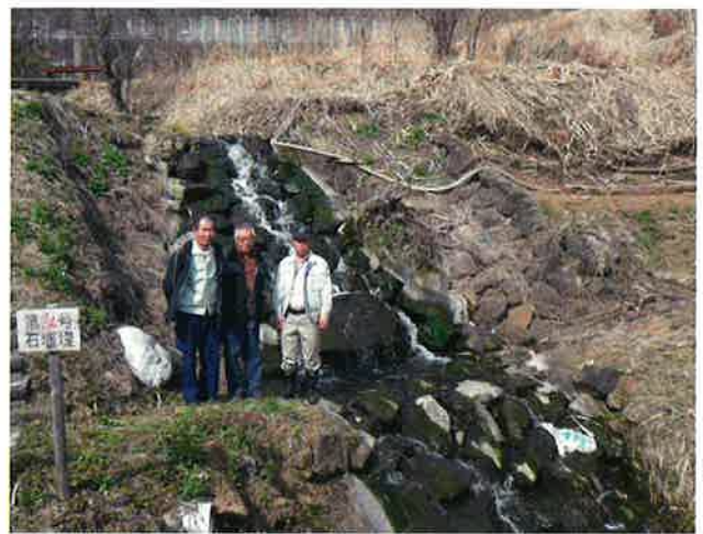
明治時代に施工された石張えん堤と現在の砂防惣代 (H20 薬師沢 小川村)
