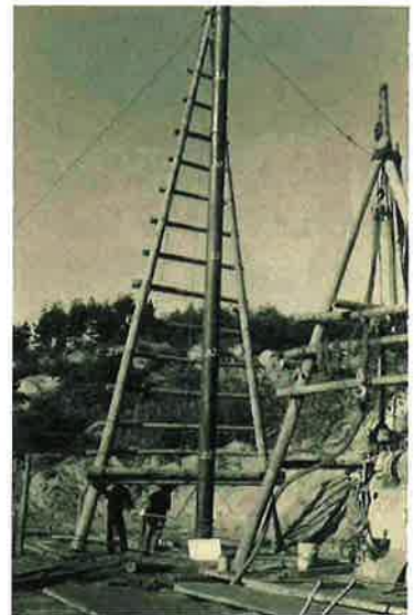
鋼管杭打ち（S46 茶臼山 長野市）
