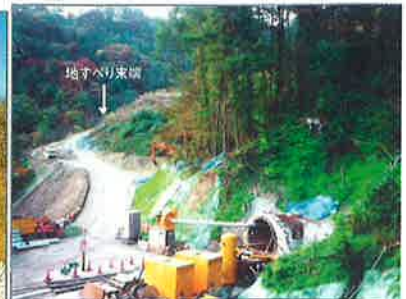
施工中の 2 号排水トンネル工 (平成 10 年)
