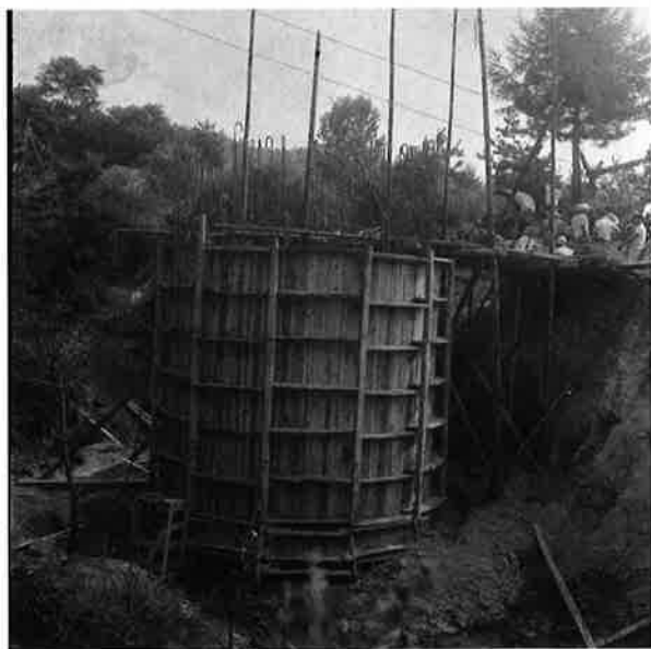
コンクリート打設
