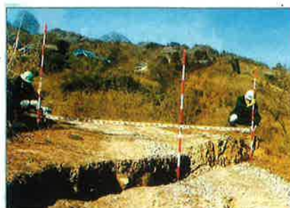
発生した段差
