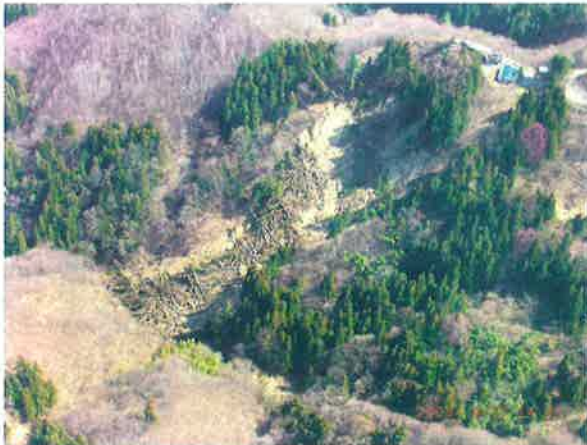
台風 23 号により家屋付近で地すべり発生
