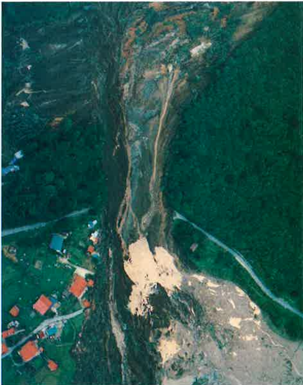
地すべり土塊が王滝ダムへ流入（滝越）
