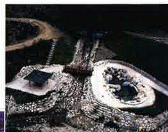
地下水排除工 の排水を利用 した親水施設
