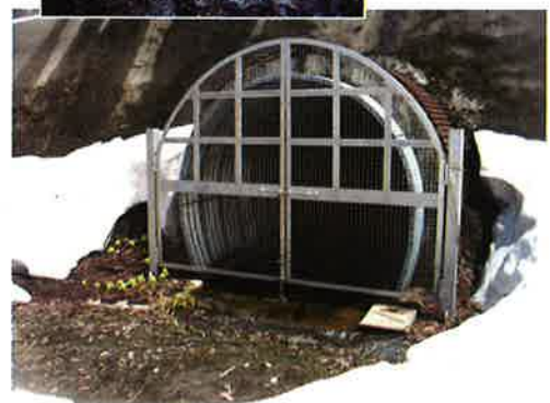
排水トンネル工
