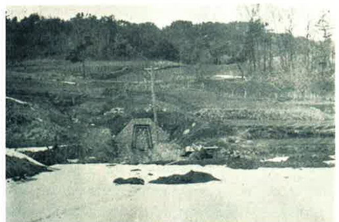
コンクリートによる巻き立てをせず玉石で充填された排水トンネル (S25 茶臼山 長野市)
