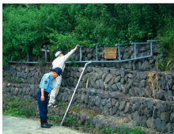
施設の点検 土砂災害防止月間などに、地元・警察・砂防ボランティア協会などによる施設点検を行っています。
