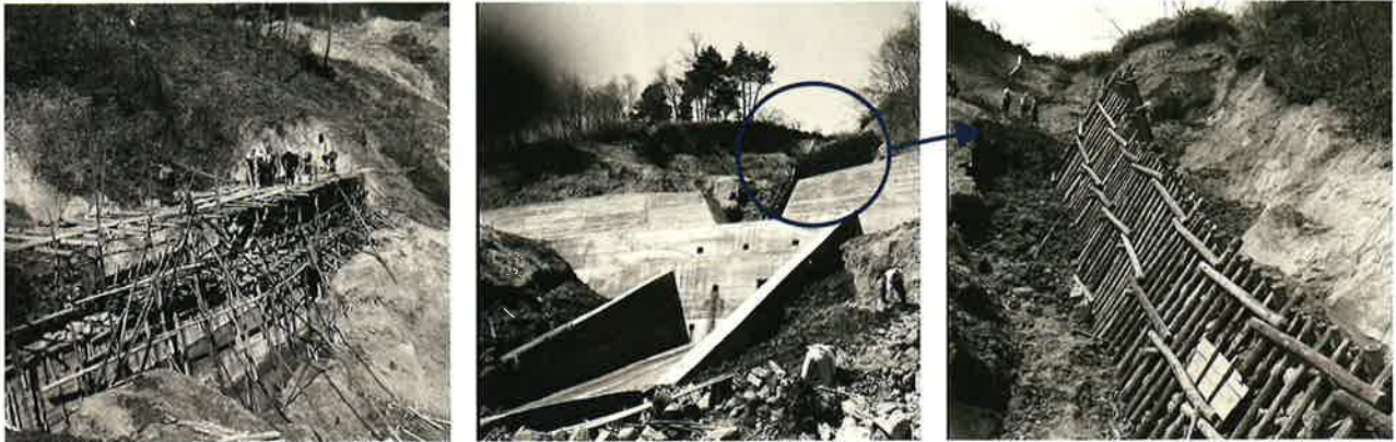
砂防事業による地すべり対策（S27 茶臼山 長野市） 左：えん堤施工状況 中央：えん堤全景（上流には暗渠工） 右：えん堤上流に施工された木枠の暗渠工
