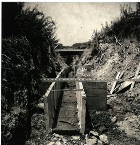
上：コンクリートU型排水路（S38 茶臼山 長野市）
