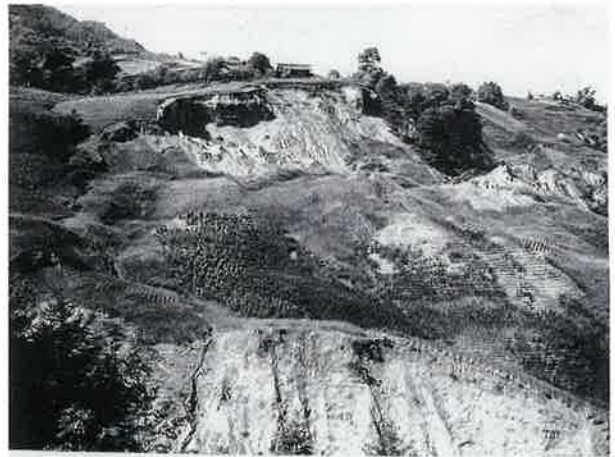
地すべりによる崩壊状況
