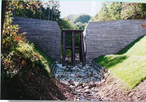
丸切沢（美麻村） 溪流の連続性を確保し、生態系に配慮したえん堤工です。 また、前面に木材を使用し、景観にも配慮しています。
