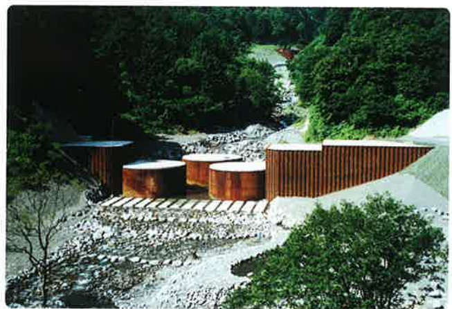
(鋼製セル) (土沢川 小谷村下寺)
