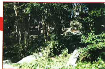
新町地区（松本市 四賀） 現場吹付け法砕工法で、樹木の配置や密度、根茎の範囲を現地に合せ、枠間隔を広くし、既存木を残した整備を行っています。
