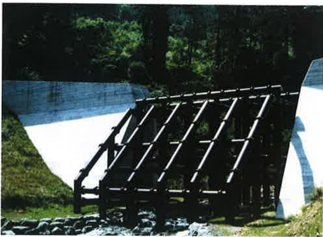
(鋼製スリット) (大崩川 茅野市大池)
