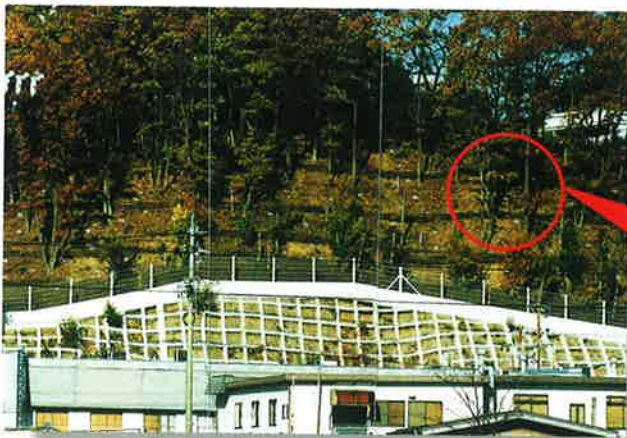
丸切沢（美麻村） 溪流の連続性を確保し、生態系に配慮したえん堤工です。 また、前面に木材を使用し、景観にも配慮しています。
