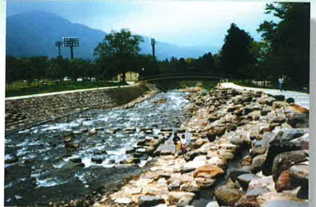
馬曲川（木島平村） 溪床溪岸に巨石を配置し、親水性を高めています。
