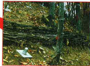
下川手地区（伊那市） 補強土工法で、鉄筋を斜面に挿入し、地山を補強することにより、伐採のない整備を行っています。
