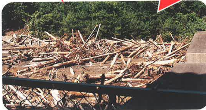
土石流と流木を止めた
