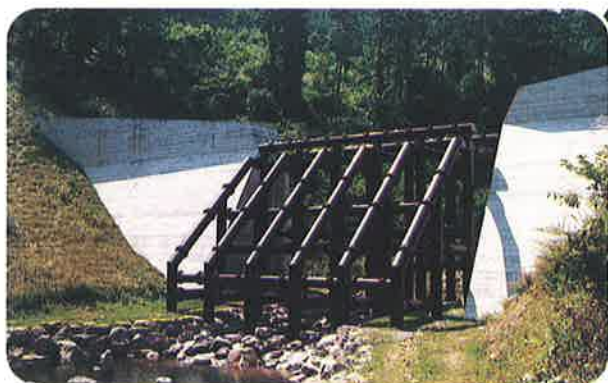
鋼製スリットダム
