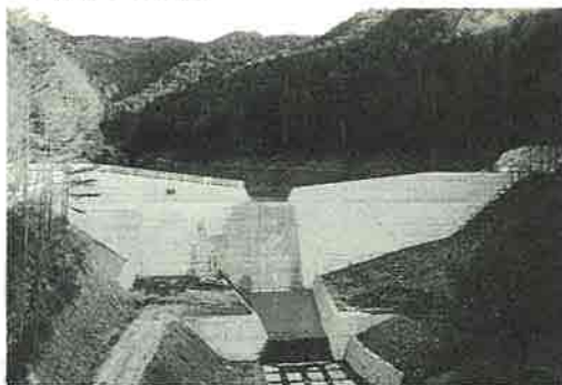
村制施行100周年の年に完成した記念すべき砂防ダム
