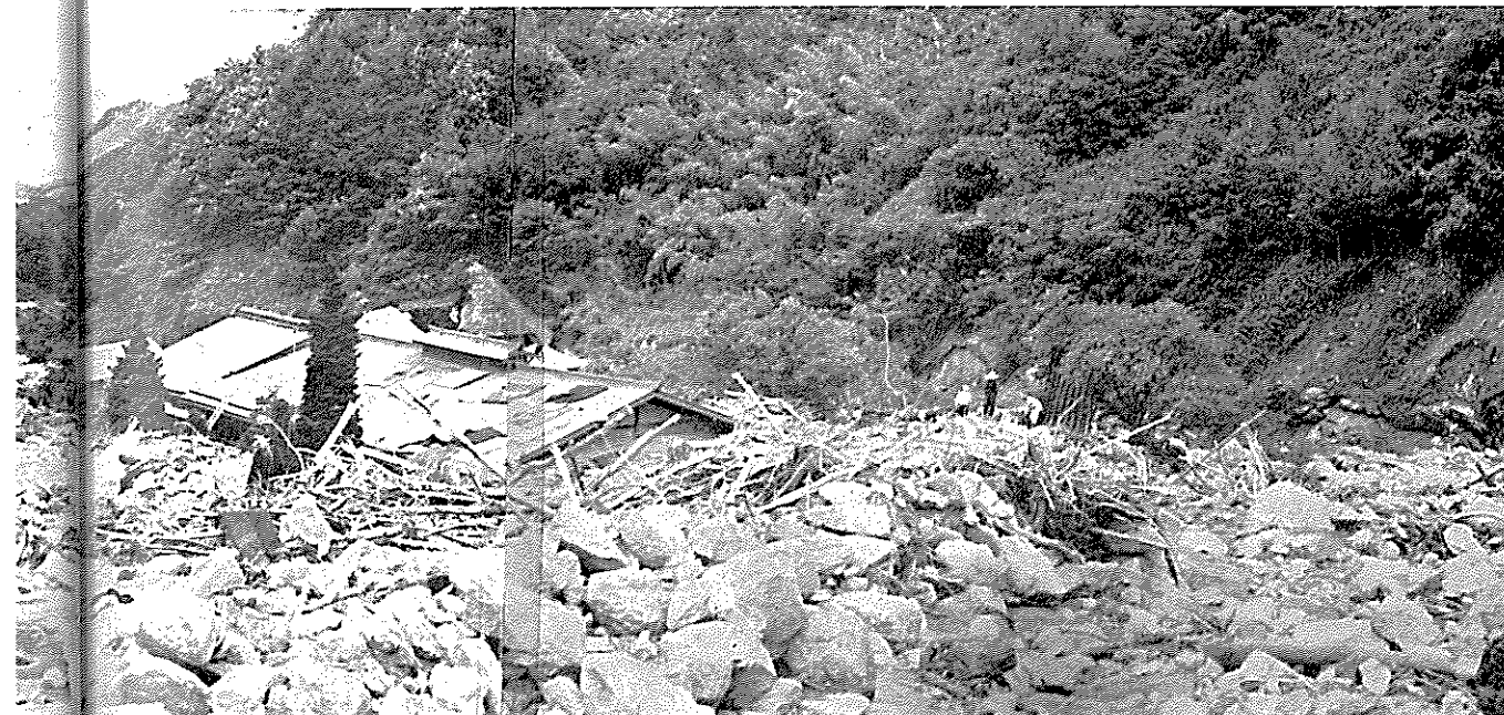
↑土石流に埋まった民家 (駒ヶ根市中沢上割)
