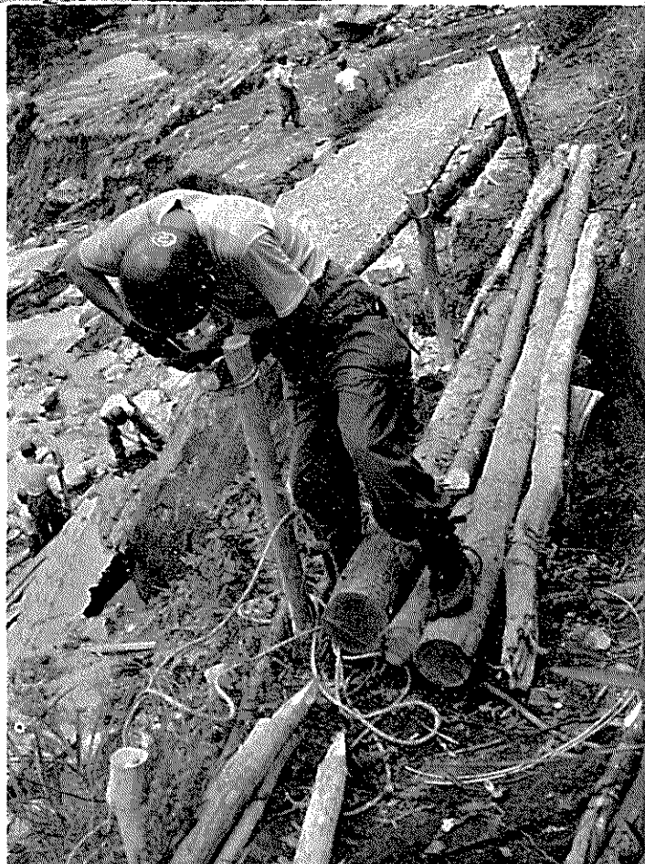
陸上自衛隊田部隊による道路応急工事 (駒ヶ根市四徳線地籍)
