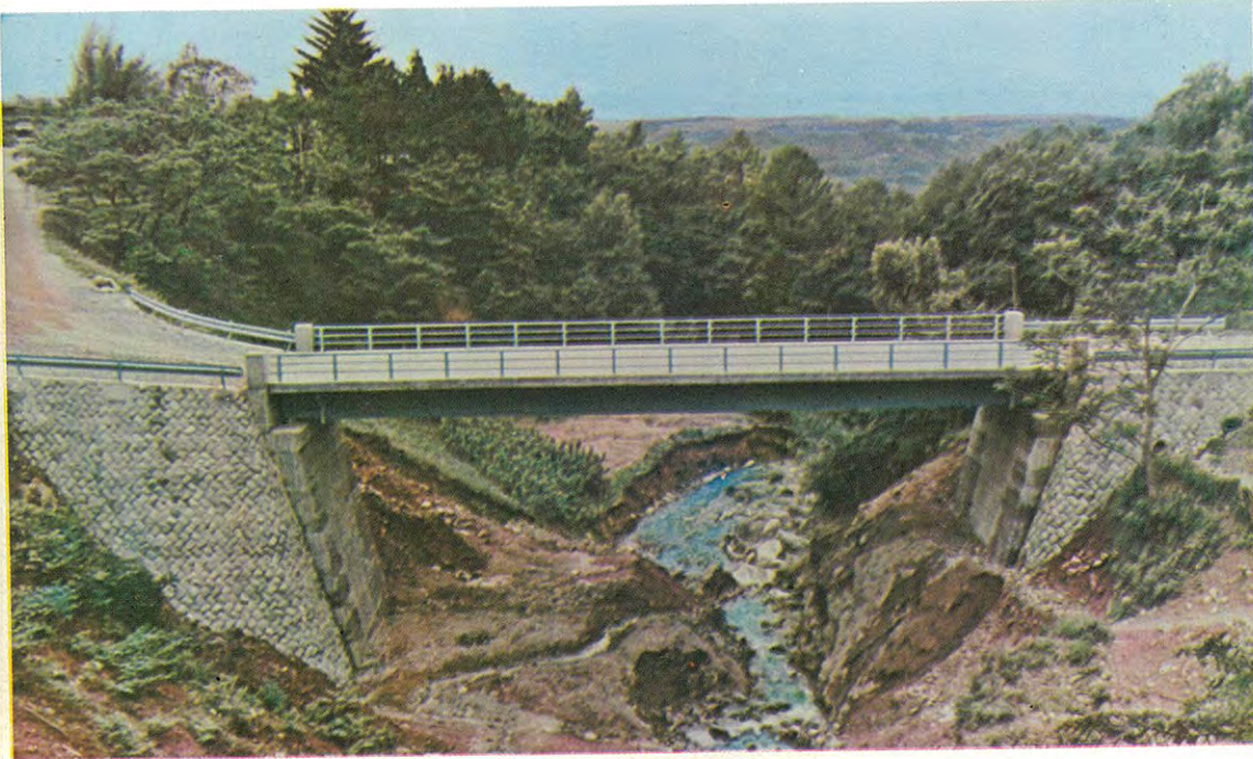
伊那生田飯田線 上伊那郡中川村赤坂橋 工事費 8,233千円 橋長 23.0m 幅員 5.5m
