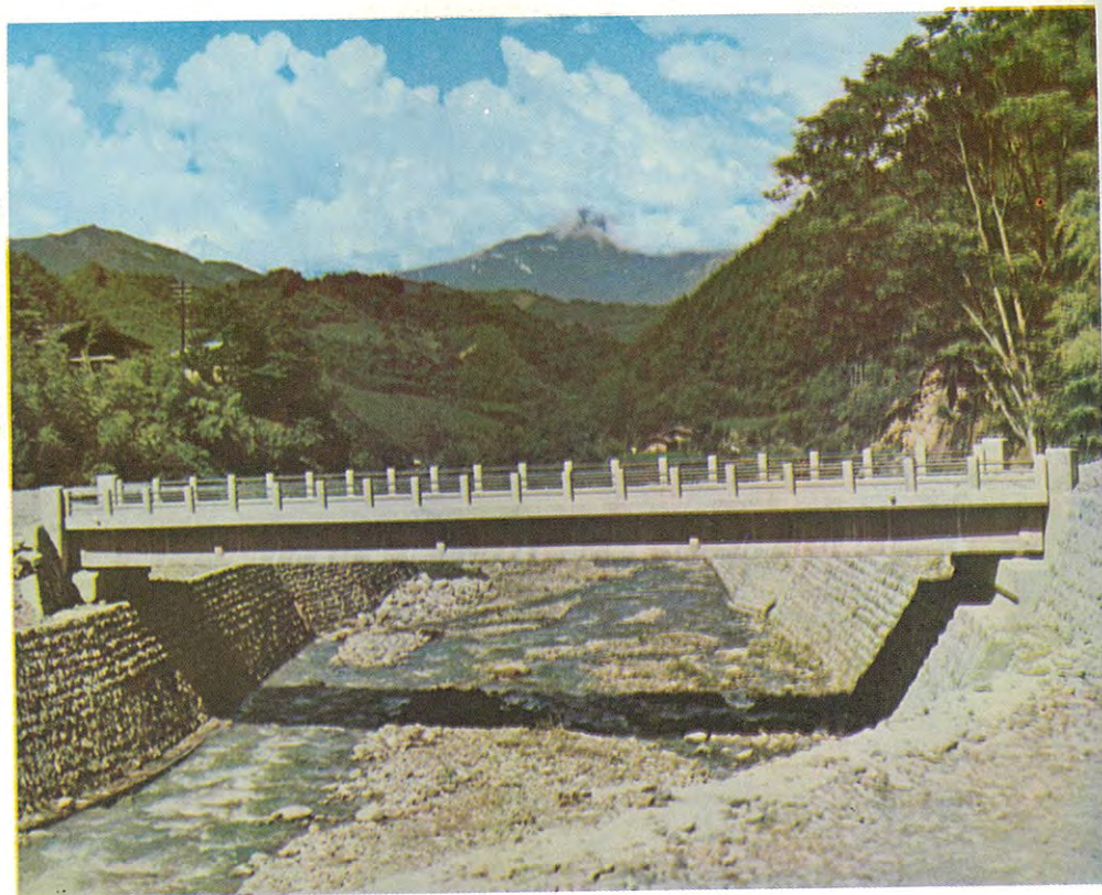
所宮川 上伊那郡駒ヶ根市 中沢6号 決定工費 179.646千円 流路工 長1,615m 法長1.5~3.9m 落差工 20基 帯工 31基 橋りょう 21ヶ所 (西伊那沢落合橋)
