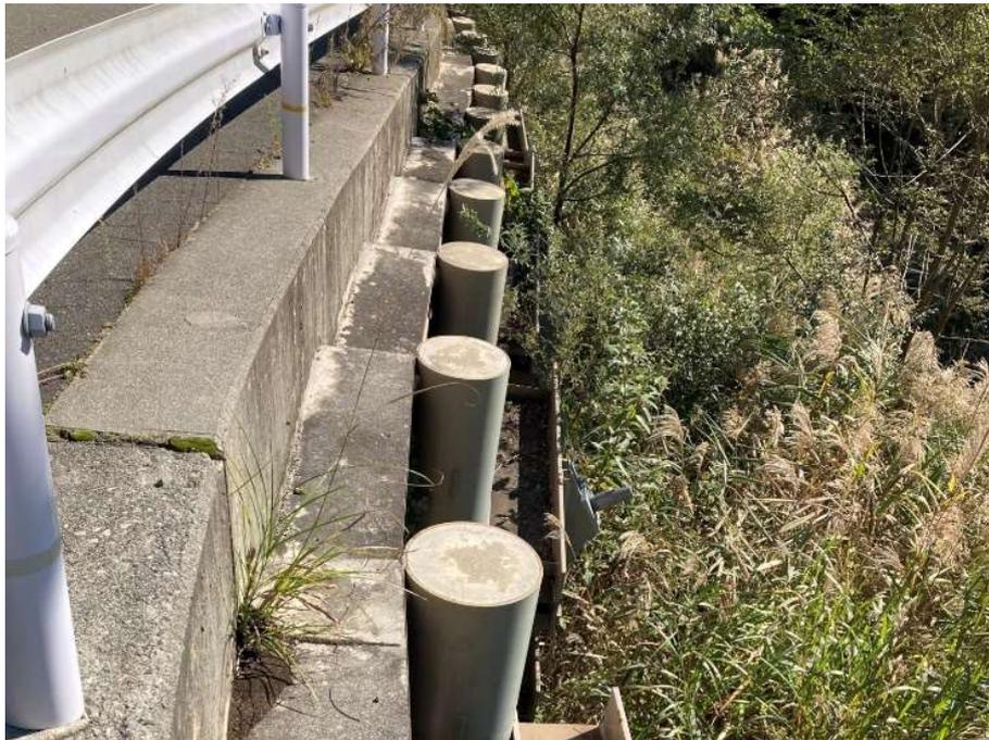
清水山の村道の側面には、巨大なアンカー工を見ることができます。「アンカー工」は土塊の下部面を固い層に埋め込んでワイヤーで固定することで、力で地すべりの動きを止める対策工の一つです。
