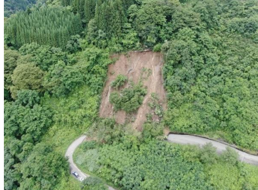
【被害状況等】村道埋塞、1世帯自主避難
