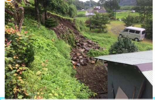
【被害状況等】石積み崩落
