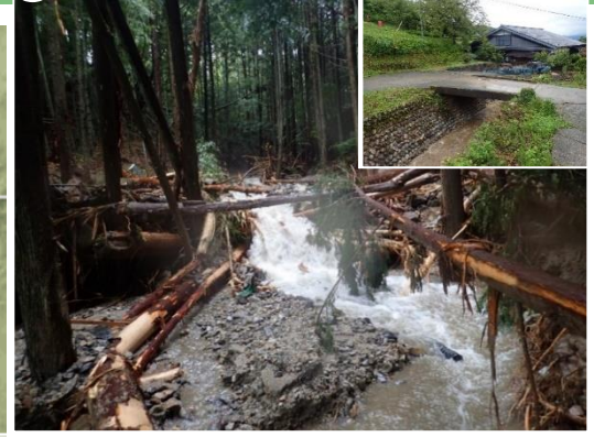
【被害状況等】人的被害なし、3世帯自主避難
