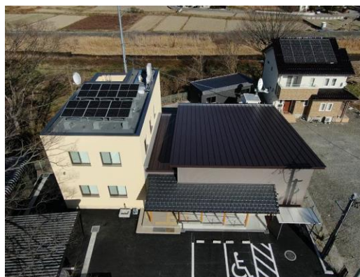
(耐震改修後の事務所全景)
