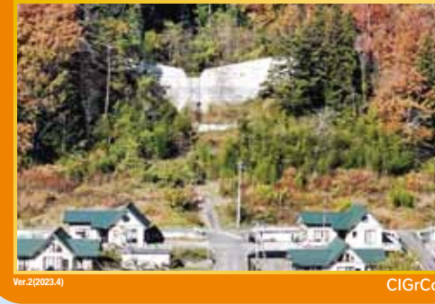
生坂村 白岐沢砂防堰堤
