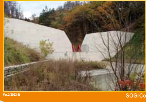
安曇野市 小橋沢砂防堰堤
