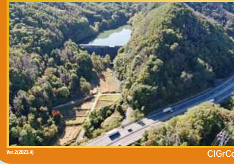
麻績村 室沢砂防堰堤
