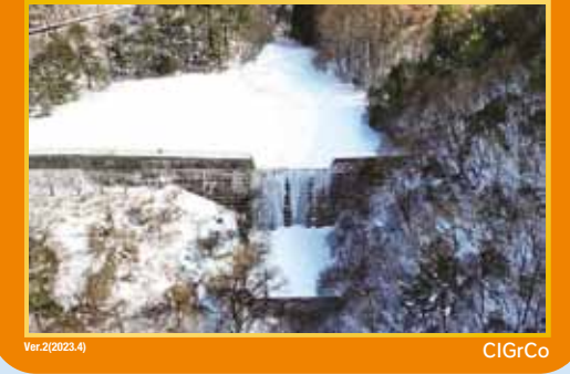
筑北村 永井砂防堰堤
