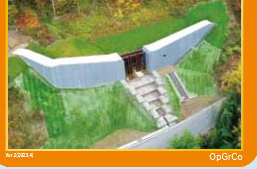
池田町 北湯沢砂防堰堤
