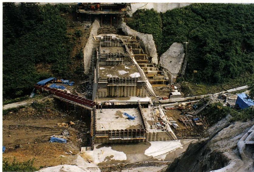
施工中 平成元年8月
