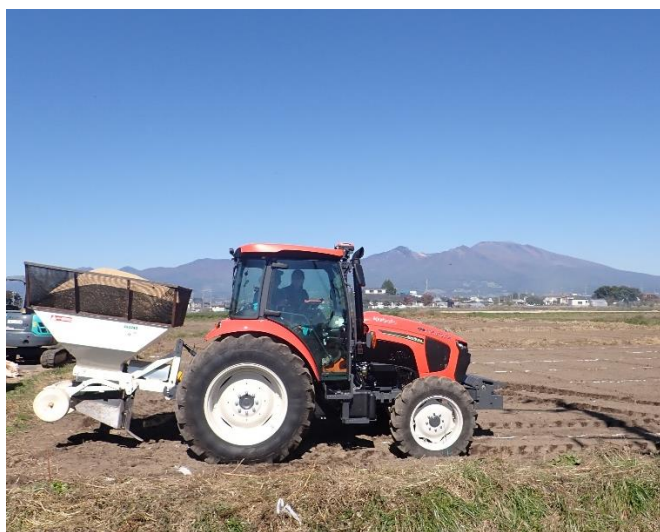
もみ殻暗渠施工機「もみサブロー」
