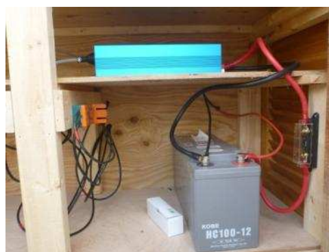
右側が固定式の充電システム パネル2枚とバッテリー1台
