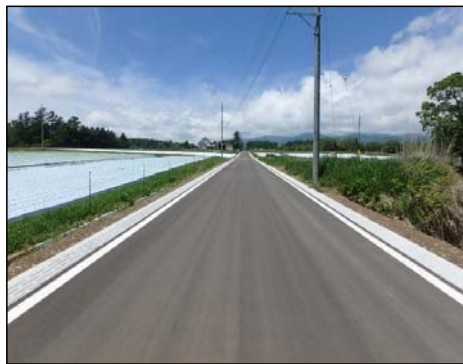
農道改良工事 南牧村：南牧野辺山地区
