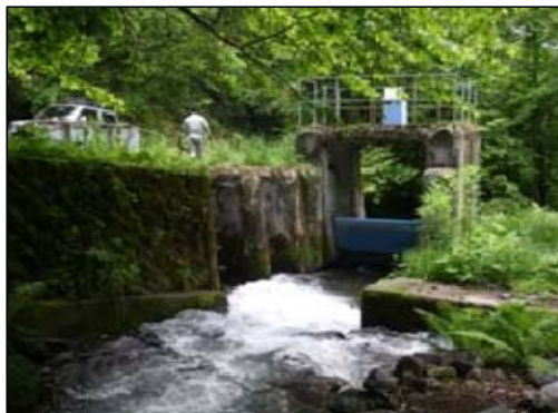
万仁田頭首工改修工事 立科町：立科幹線地区
