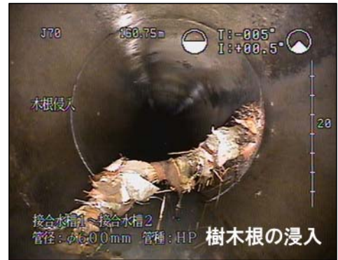
管路の更新事業 立科町：立科3号幹線地区
