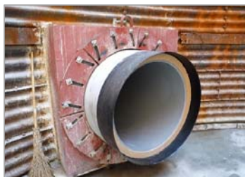
整備した基幹的農業水利施設（水路トンネル） (御代田町：大久保地区)
