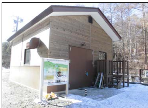
陣内森林公園発電所
