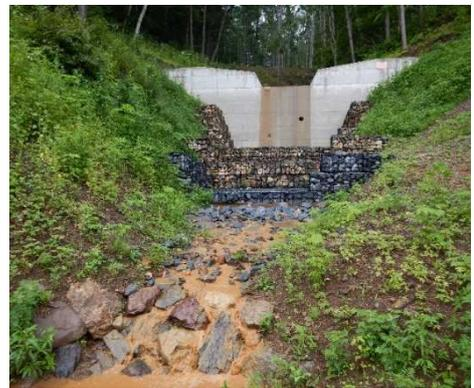
豪雨による土砂流出や流木の発生により、林道の路体が流失し下部の擁壁も洗堀を受けました。そのため、路体や林道施設の復旧および擁壁の保護を目的に、盛土工や緑化工、重力式擁壁の設置等を実施し通行が可能となりました。
