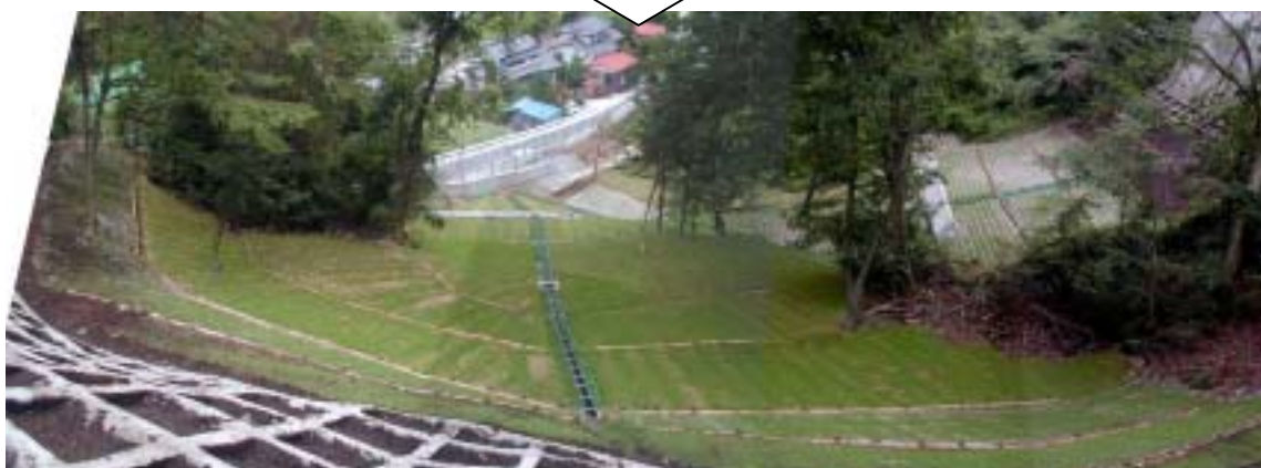
土留工、法枠工、筋工、伏工、水路工等で復旧 H20.8.26 撮影
