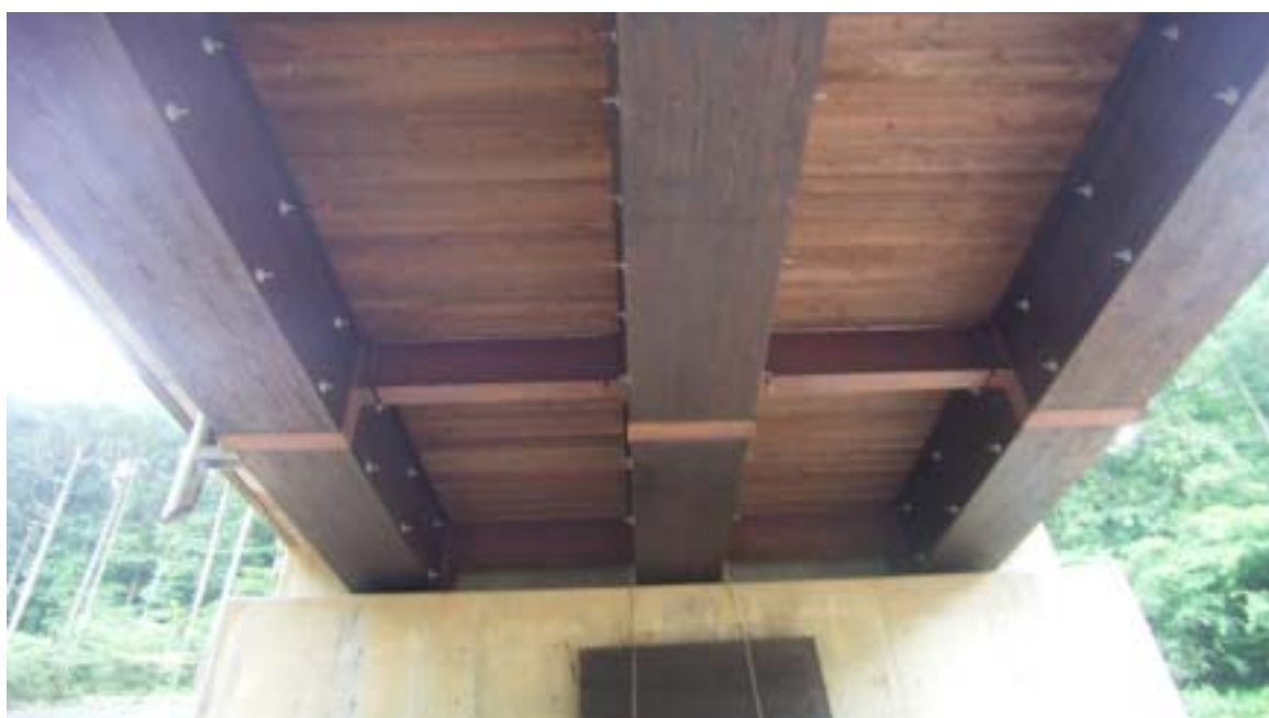
上：完成した木造橋「谷川橋」 下：谷川橋を下から見たところ。三本のカラマツ集製材が橋を支えています。
