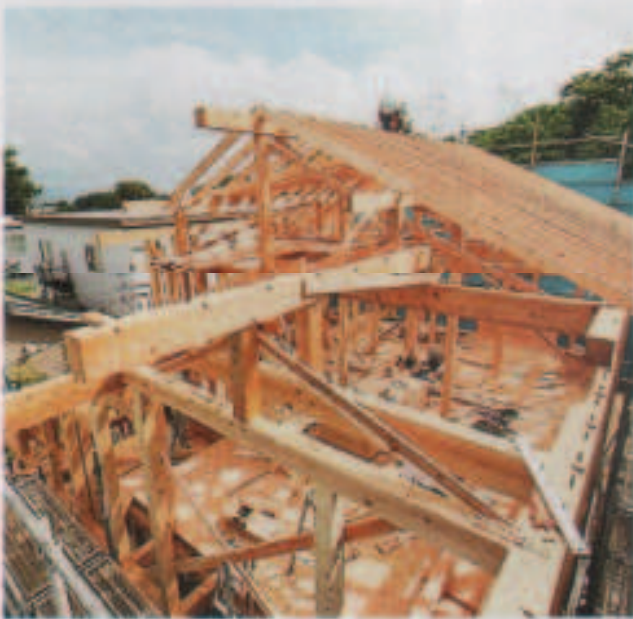
【施工中】 構造材：カラマツ等
