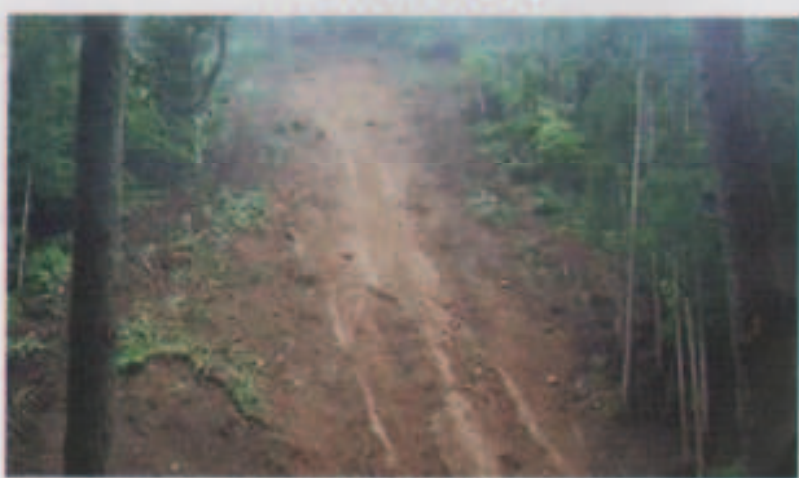
山腹崩壊被害
