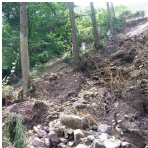
崩壊した山腹
