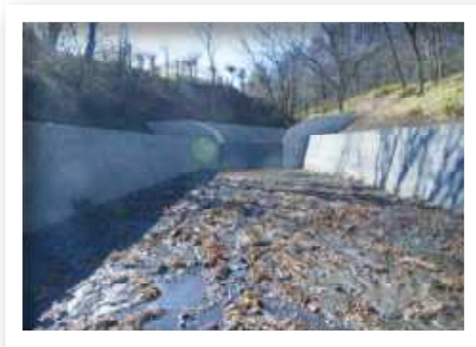
谷止工・護岸工
