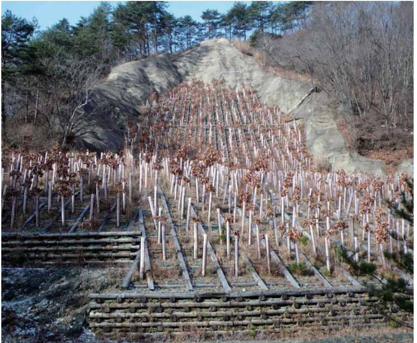
「木製法枠工」施工地
