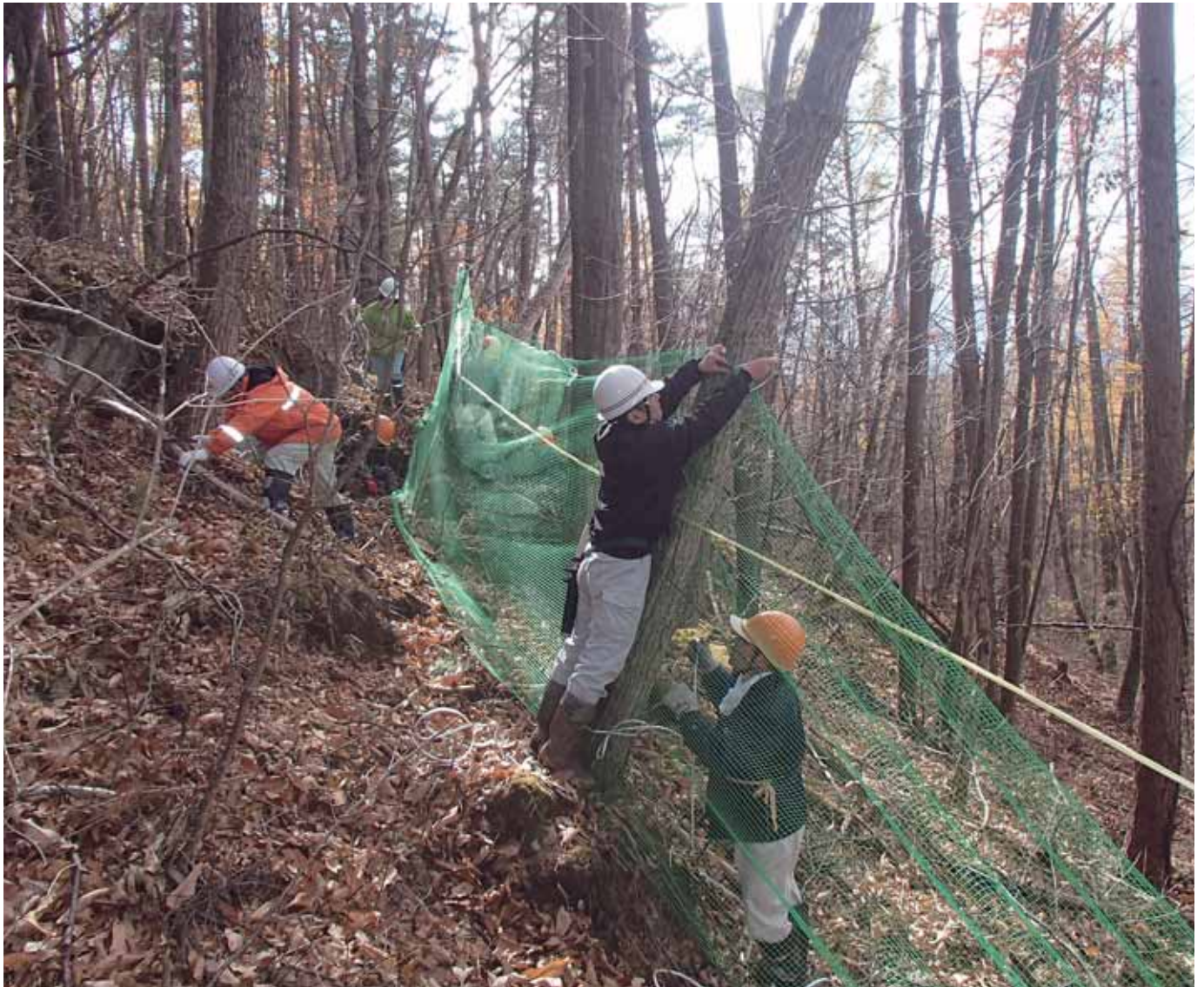
くくりわなにシカを誘導するネット取り付け中
