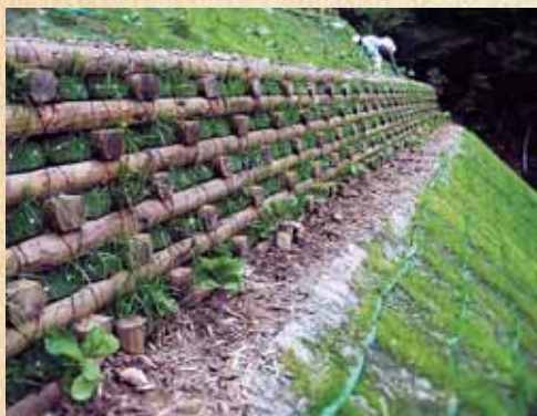
斜面を治める丸太積工
