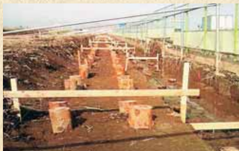
軟弱な地盤を改良する杭 4～5 mも地面の中に杭が打ち込まれています
