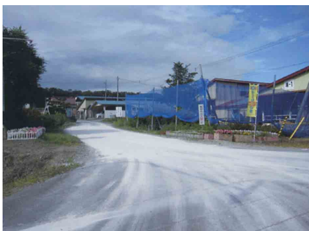
消石灰帯の設置
