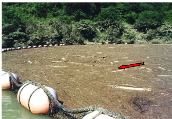
平成11年8月の豪雨 ダム湖流木止め付近
