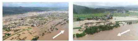
長野県長野市穂保地先の堤防決壊、浸水被害状況
