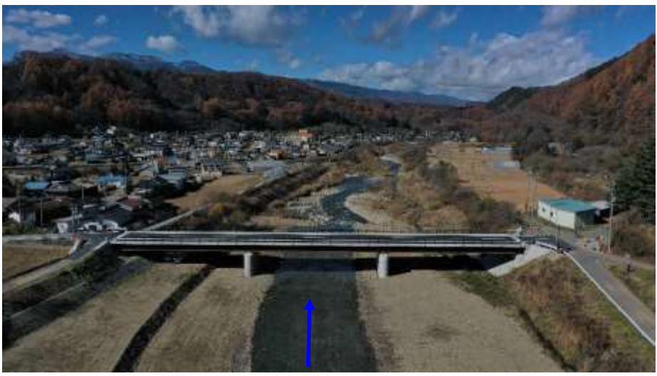
施工状況(令和4年11月完成)
