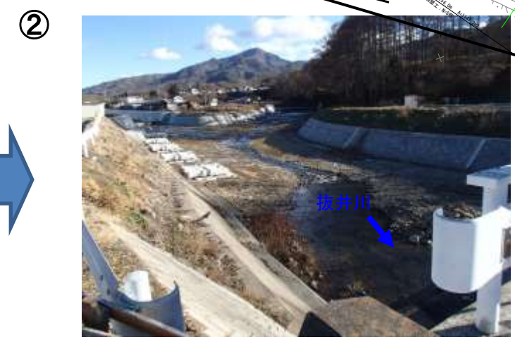
施工状況(R5.3月完成)
