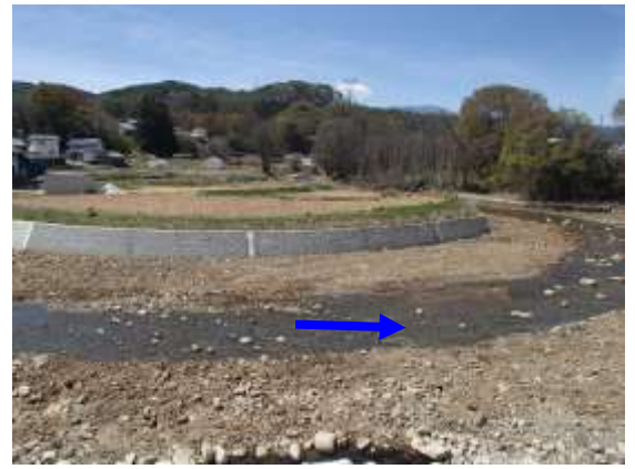
施工状況(R5.3月完成)
