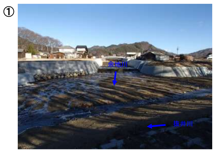
施工状況(R5.3月完成)
