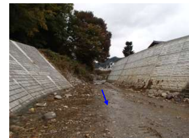
施工状況(R4.12月完成)
