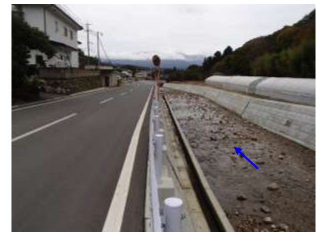
施工状況(R4.12月完成)
