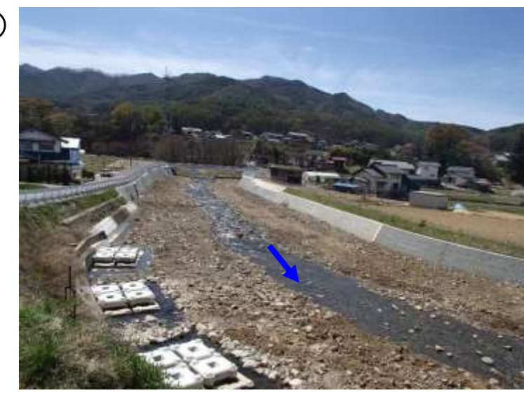
施工状況(R5.3月完成)
