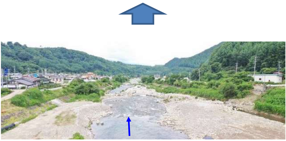
旧橋撤去後(令和2年7月)
