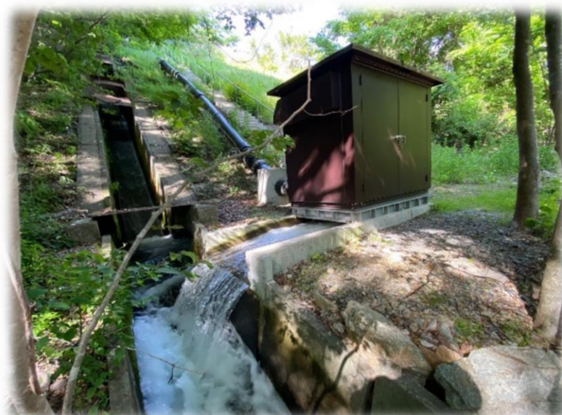
ユニット外装設置イメージ(20kwタイプ)
