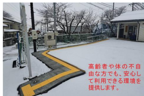
公共施設のバリアフリー化にも貢献 (中野市東山区集会所)
