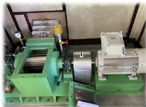
内部のクロスフロー水車
